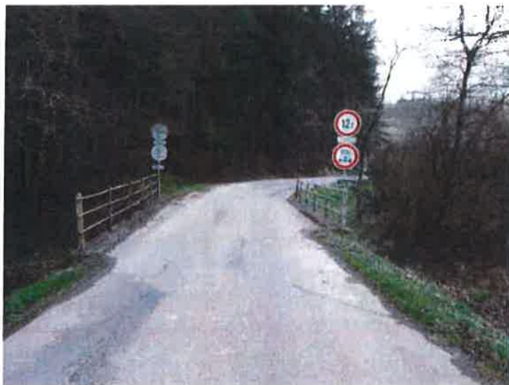
336-006 Celkový pohled na most od OP1.
