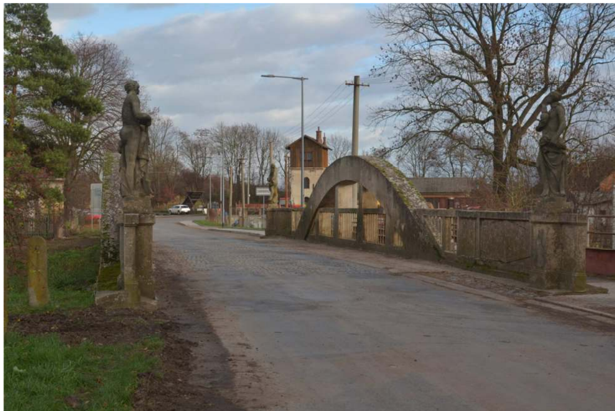
Celkový pohled na most
