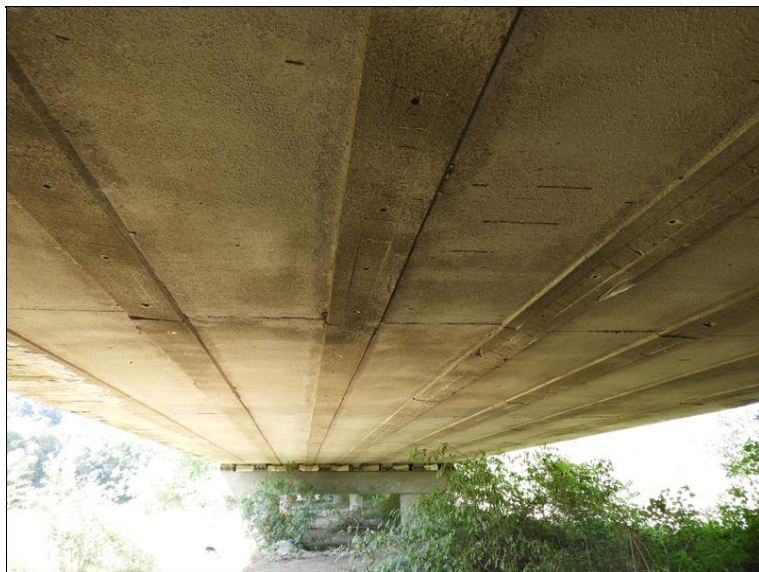
Podhled NK, pole 2
