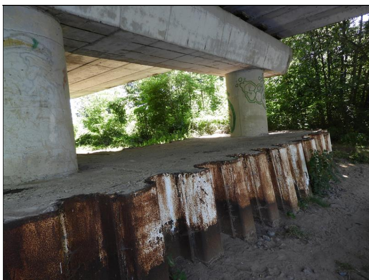
Pohled na P17 proti směru staničení
