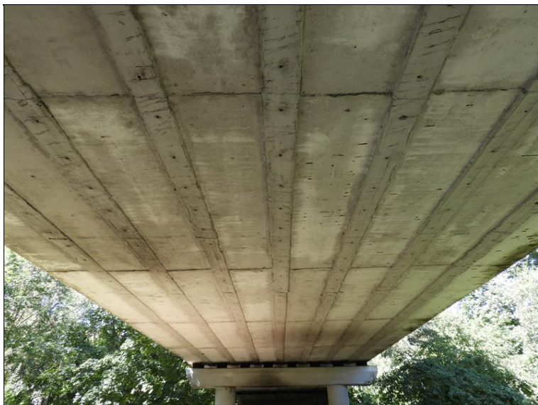
Podhled NK, pole 9
