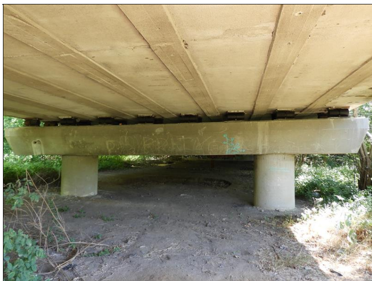
Pohled na Pi2 proti směru staničení
