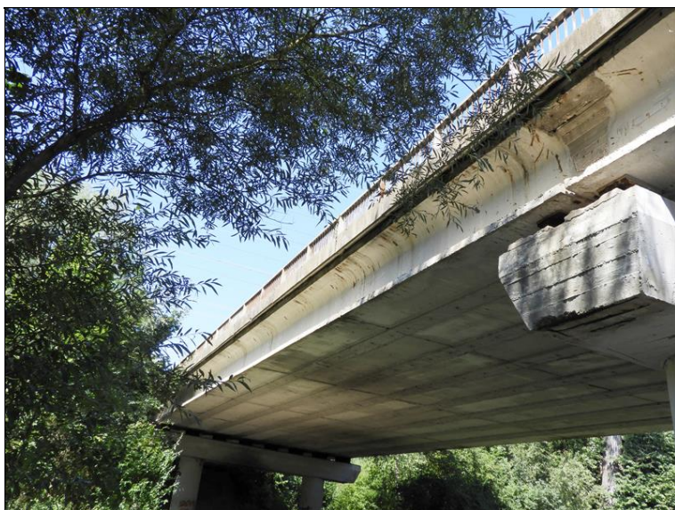
Pohled na most zleva, pole 9
