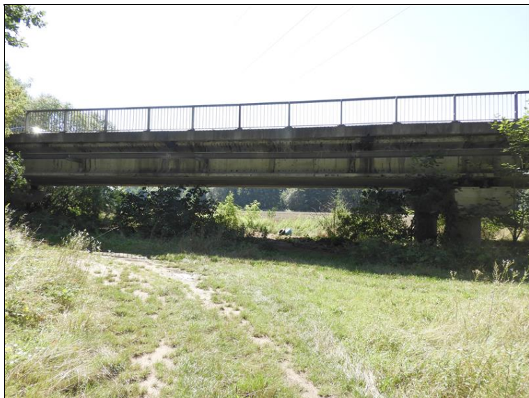
Pohled na most zprava, pole 2
