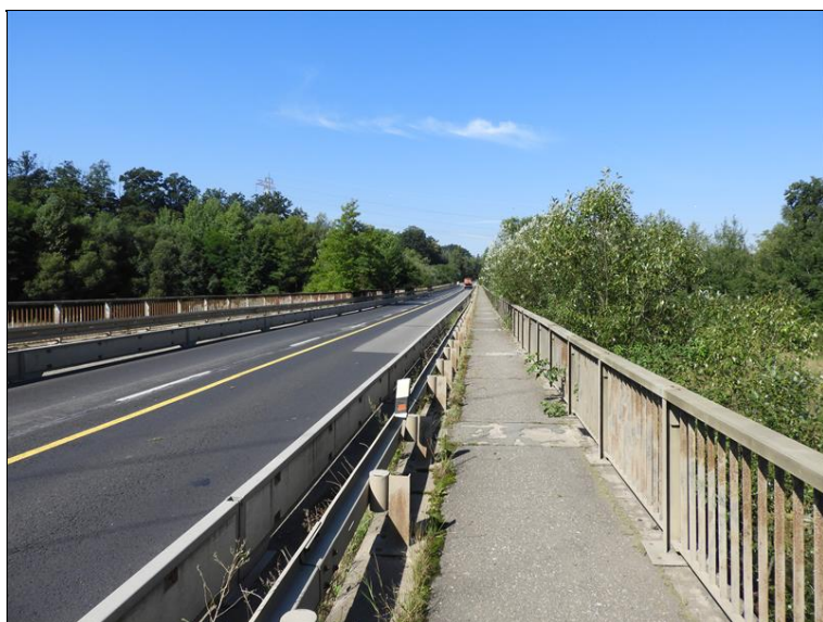
Pohled na obslužný chodník zprava po směru staničení
