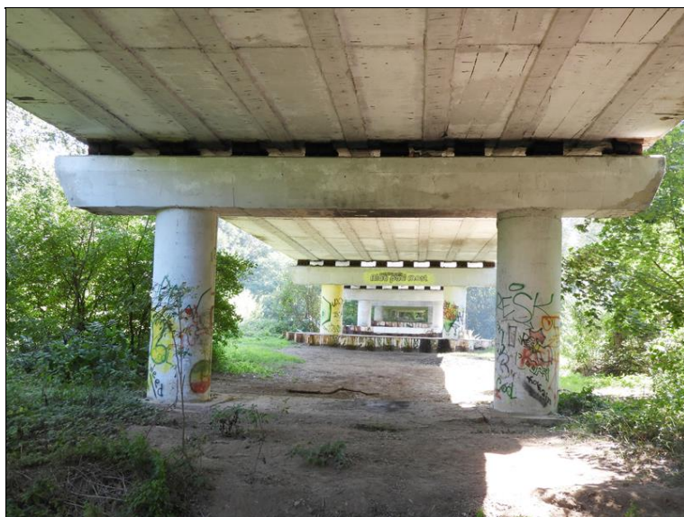
Pohled na Pi10 proti směru staničení
