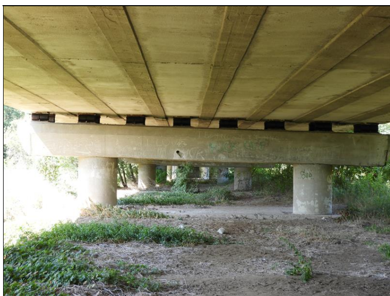
Pohled na Pi4 ve směru staničení
