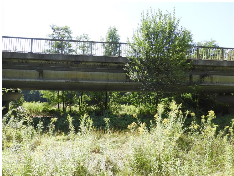
Pohled na most zprava, pole 5
