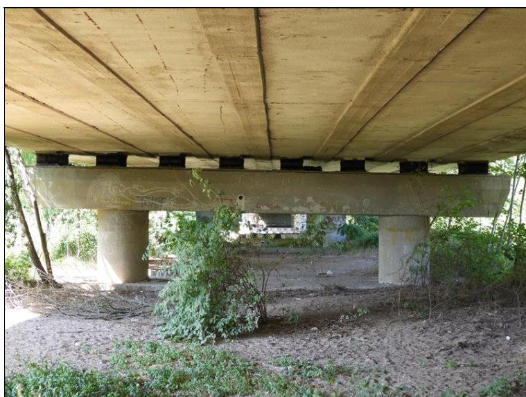
Pohled na Pi5 ve směru staničení
