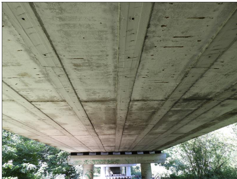
Podhled NK, pole 6
