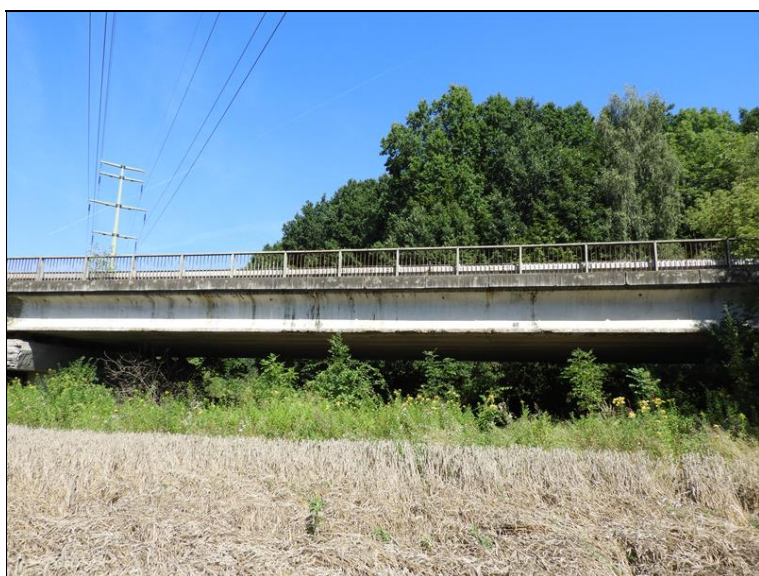
Pohled na most zleva, pole 2
