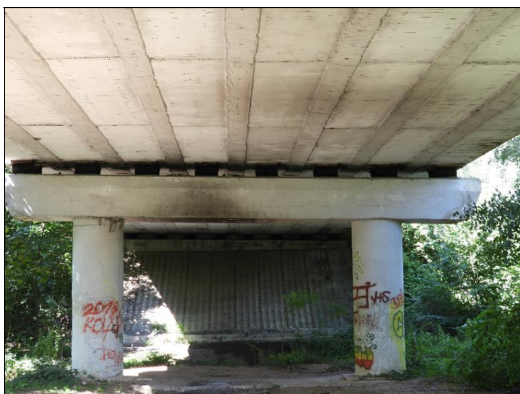
Pohled na Pi10 ve směru staničení
