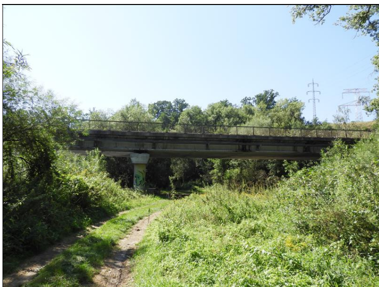
Pohled na most zprava, pole 9
