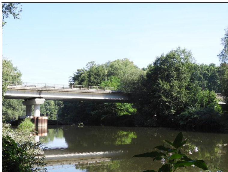
Pohled na most zleva, pole 8
