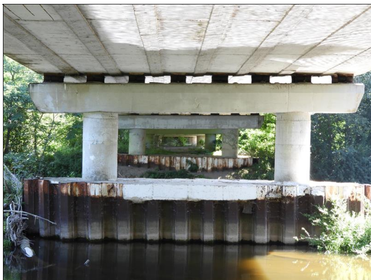
Pohled na P18 proti směru staničení
