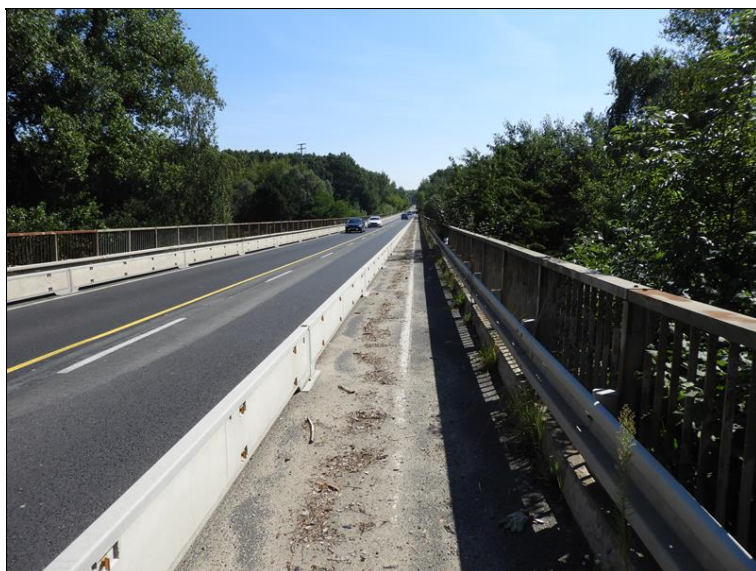
Pohled na obslužný chodník zleva proti směru staničení
