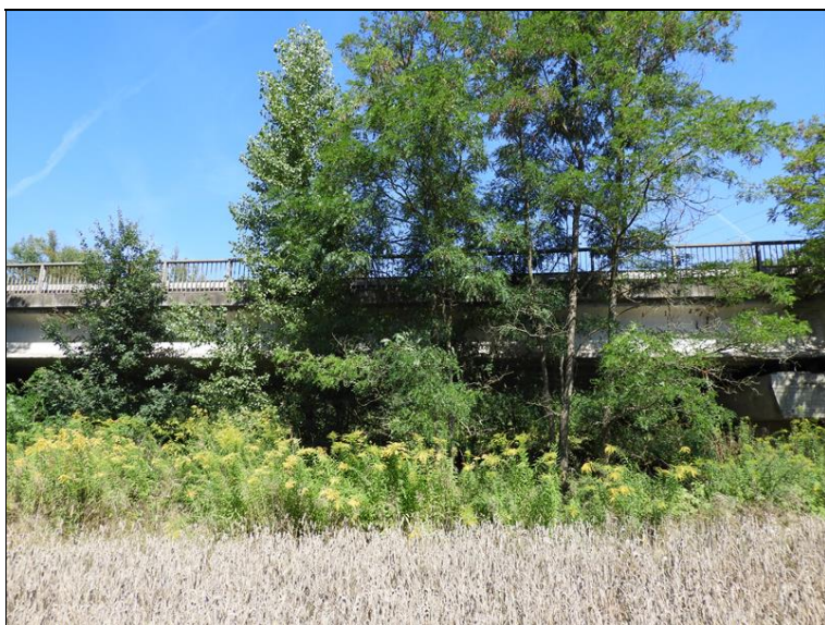
Pohled na most zleva, pole 5
