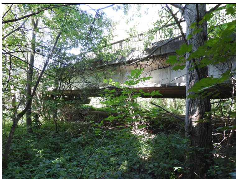
Pohled na most zleva, pole 1
