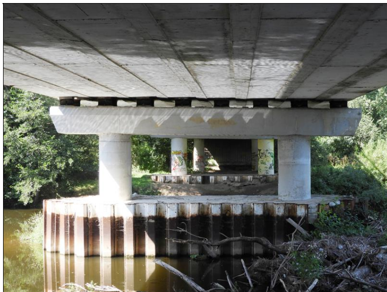
Pohled na Pi8 ve směru staničení
