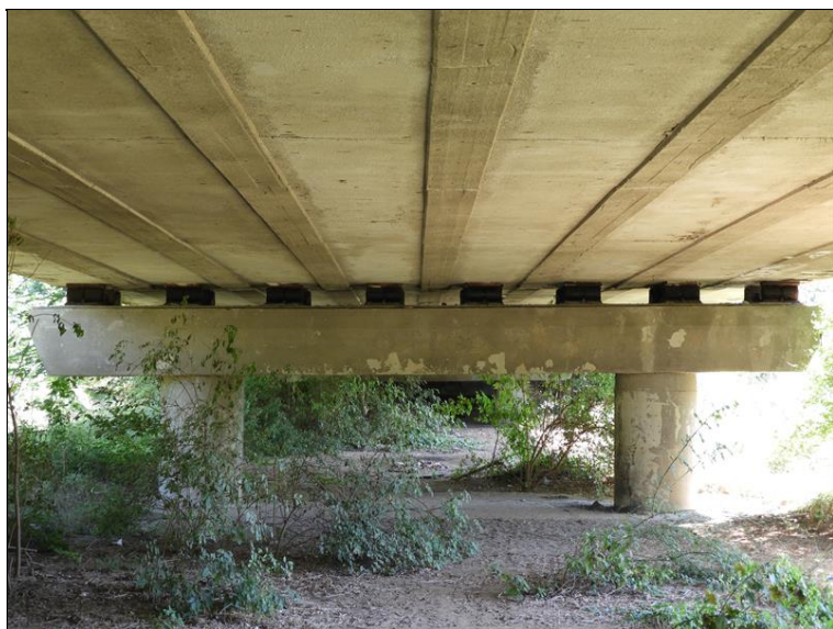
Pohled na Pi3 proti směru staničení
