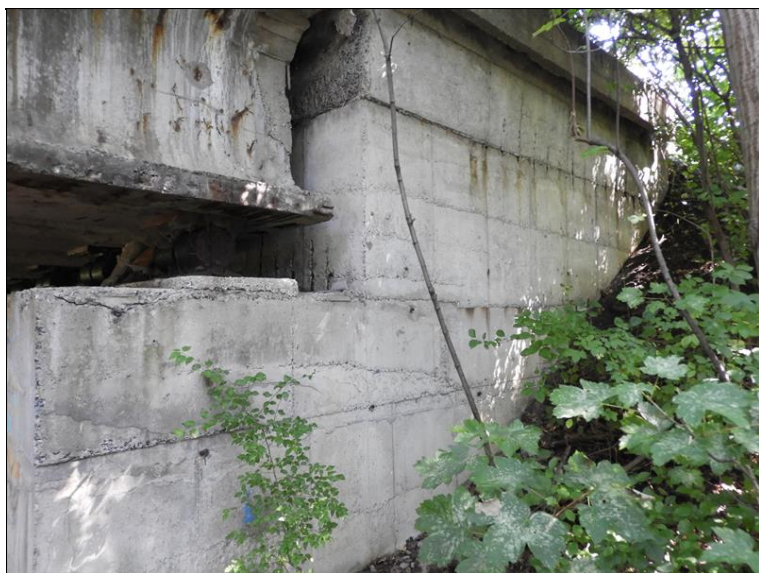
Pohled na křídlo OP1 levé
