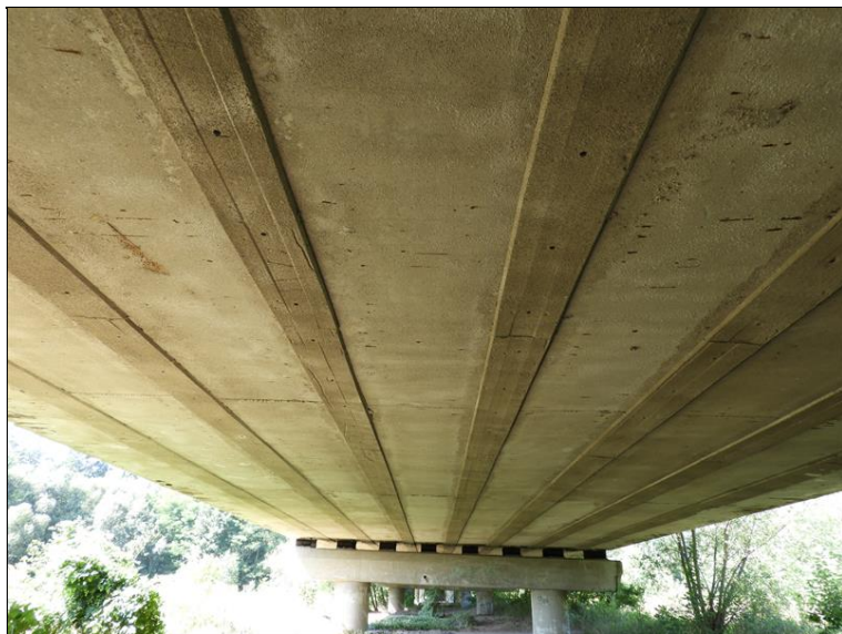
Podhled NK, pole 3
