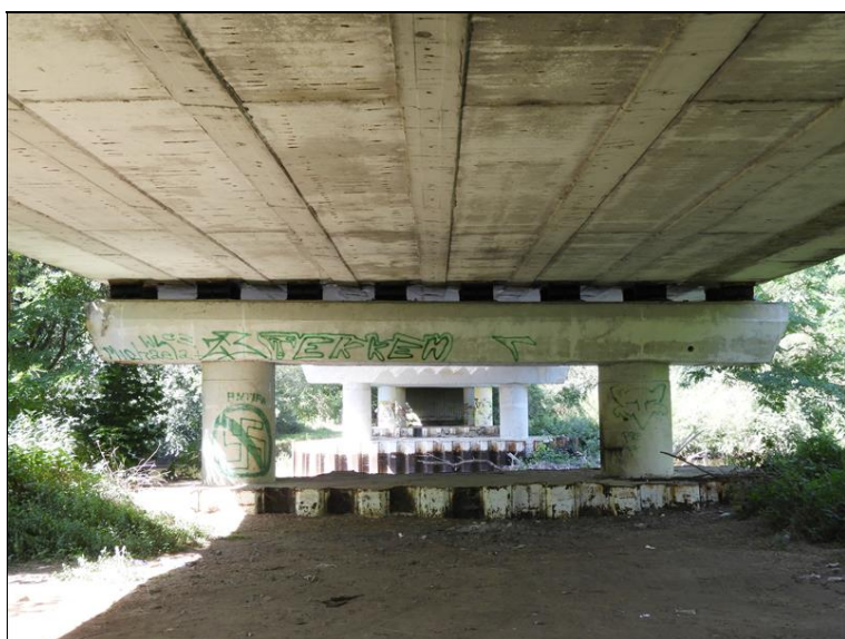
Pohled na Pi7 ve směru staničení
