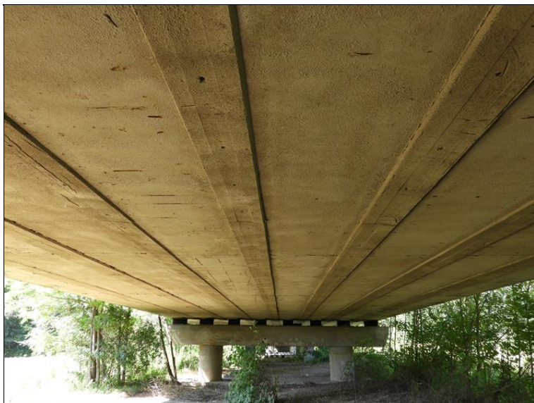
Podhled NK, pole 4
