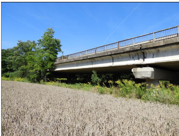
Pohled na most zleva, pole 4
