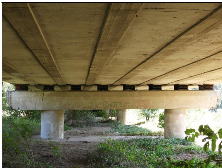
Pohled na Pi4 proti směru staničení
