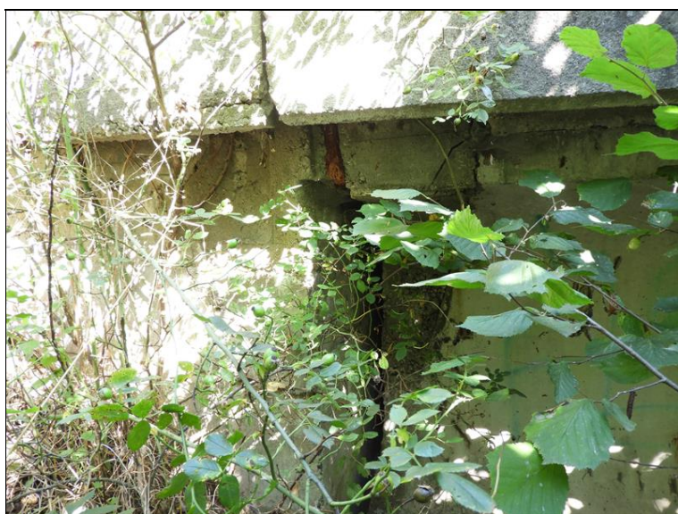
Pohled na křídlo OP11 levé
