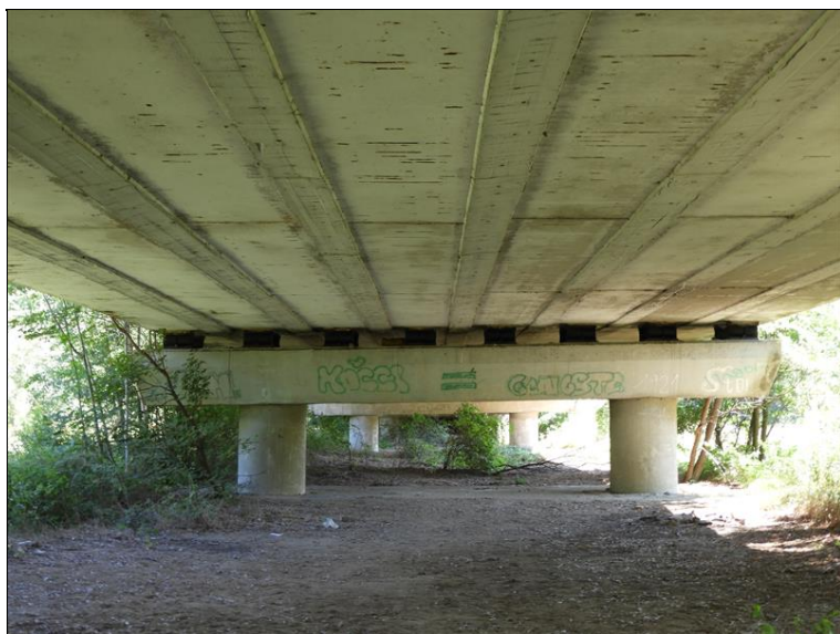
Pohled na Pi5 proti směru staničení
