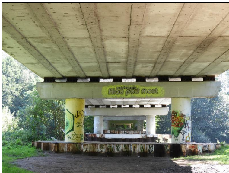
Pohled na Pi9 proti směru staničení
