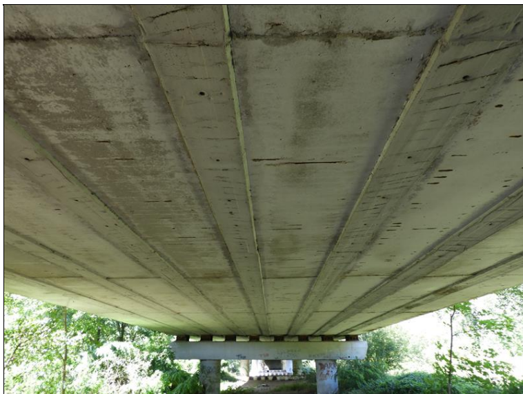
Podhled NK, pole 3
