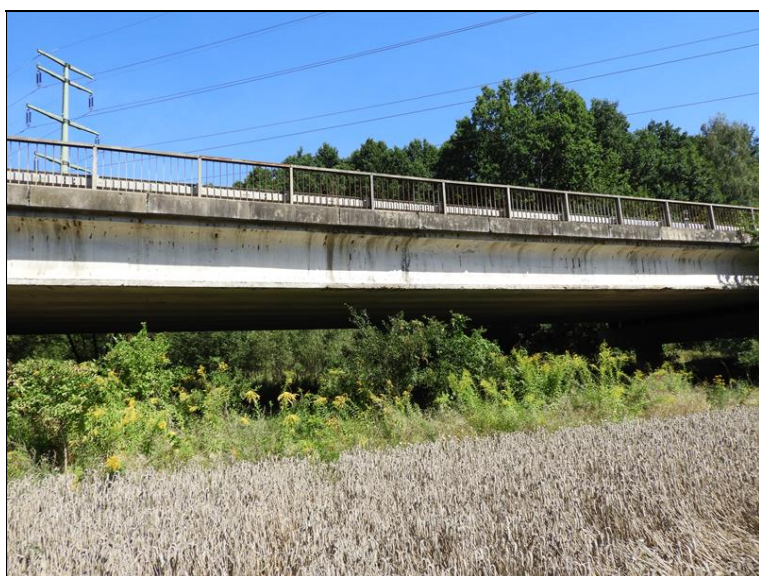
Pohled na most zleva, pole 3
