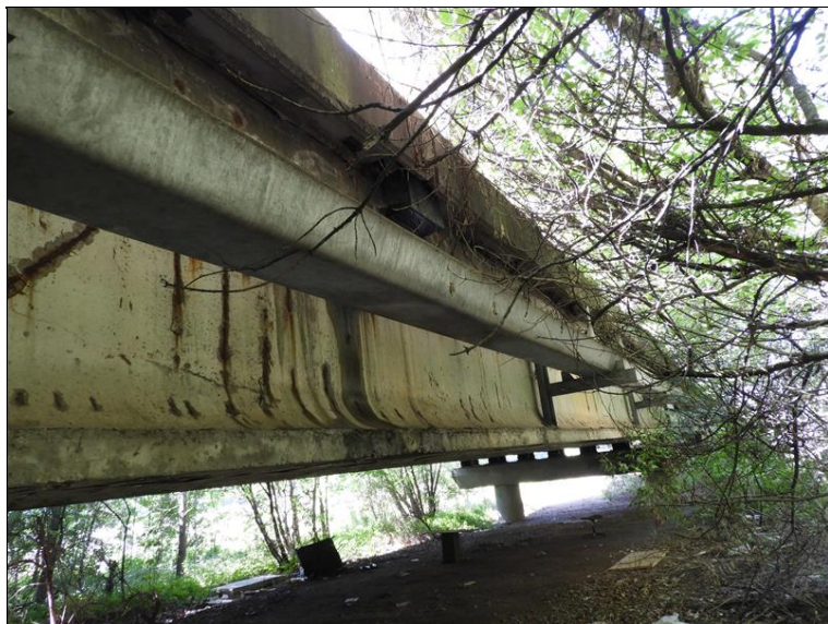
Pohled na most zprava, pole 1
