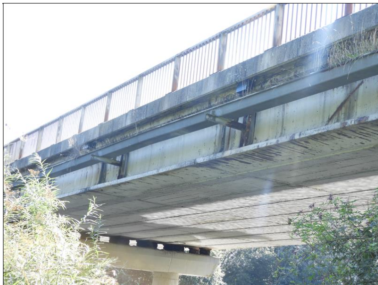
Pohled na most zprava, pole 8
