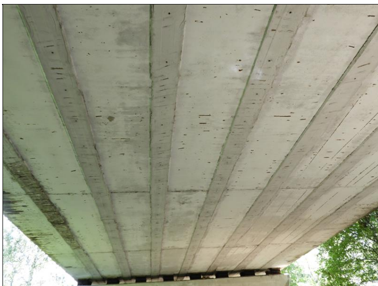
Podhled NK, pole 10
