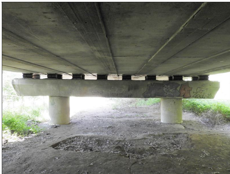
Pohled na Pi2 ve směru staničení
