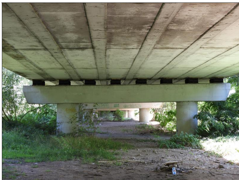
Pohled na Pi6 proti směru staničení
