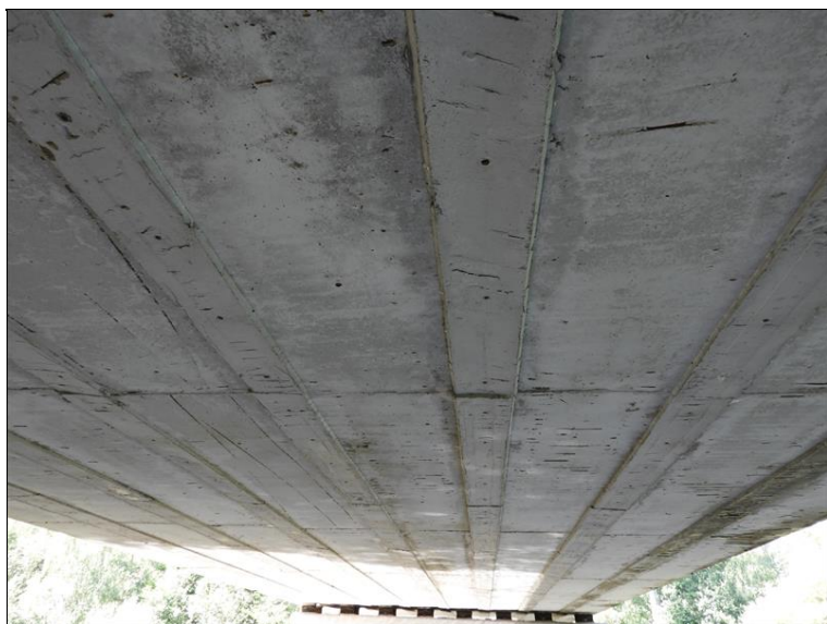
Podhled NK, pole 7
