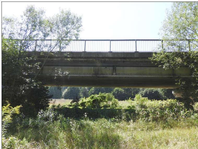
Pohled na most zprava, pole 3
