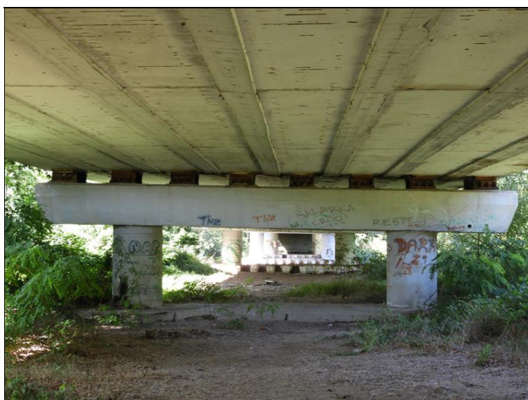
Pohled na Pi6 ve směru staničení
