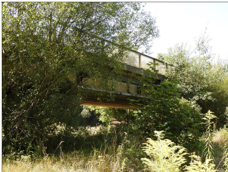
Pohled na most zprava, pole 4
