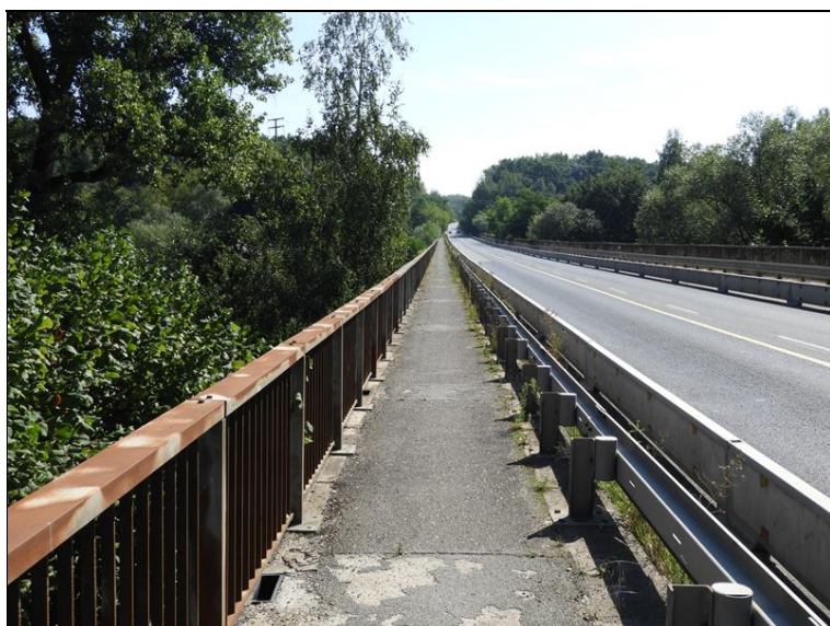
Pohled na obslužný chodník zprava proti směru staničení
