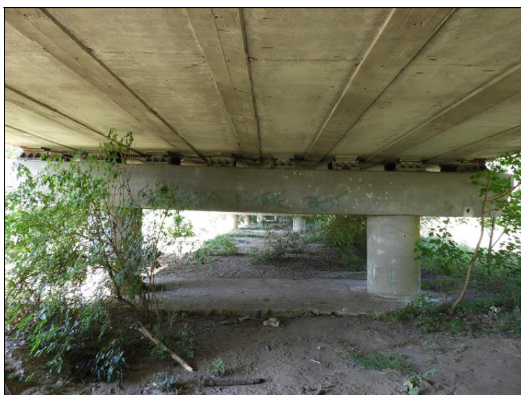
Pohled na Pi3 ve směru staničení
