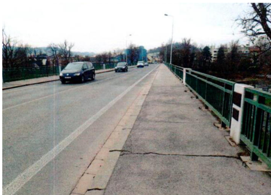
Pohled na most ve směru staničení.
