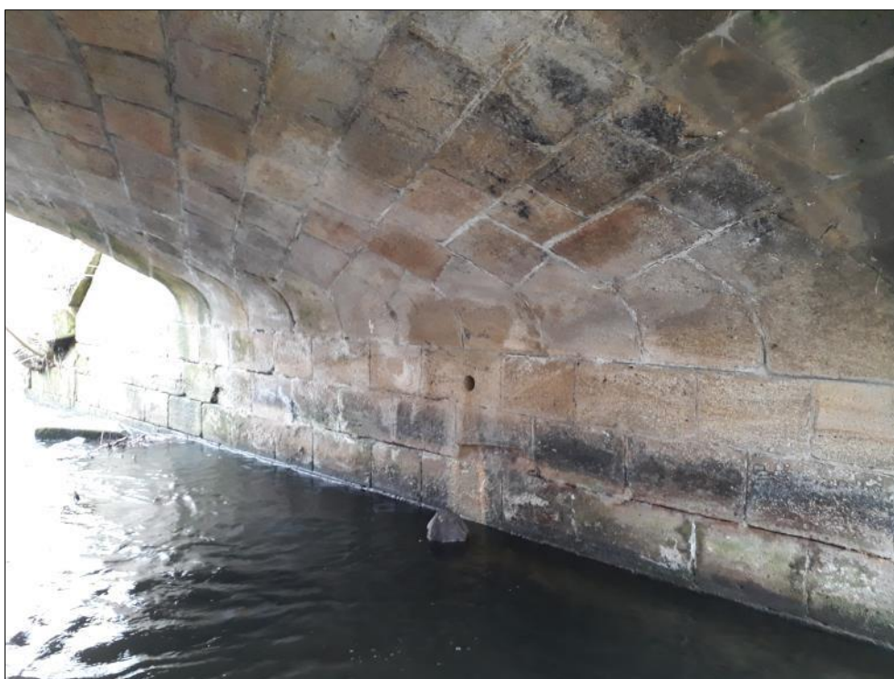
Foto 2: Pohled na západní opěru, lokalizace prováděného jádrového vrtu
