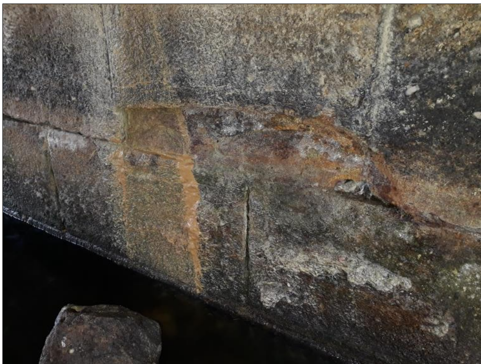
Foto 5: Pohled na západní opěru, patrná degradace pískovcového zdiva
