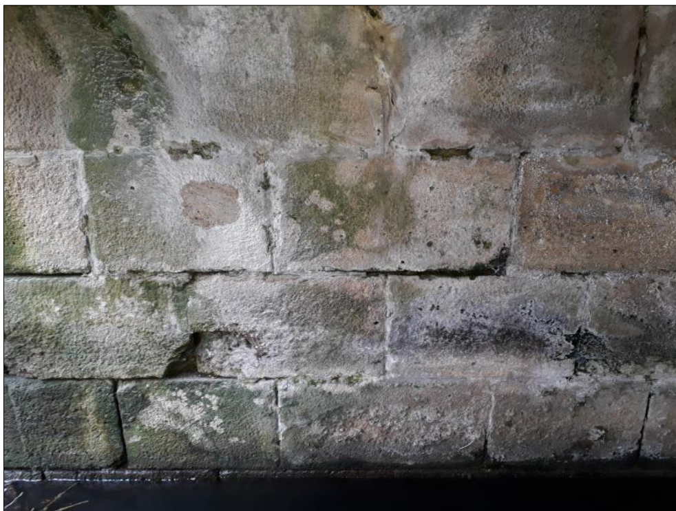
Foto 7: Pohled na západní opěru, patrná degradace pískovcového zdiva, lokálně vyplavená malta ve spodních částech opěry
