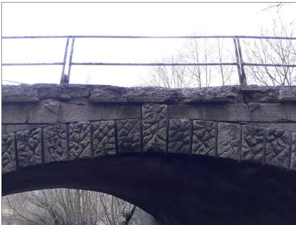
Foto 11: Pohled na návodní stranu klenby, patrný zvýšený klenák (75 cm), patrná degradace betonové římsy mostu
