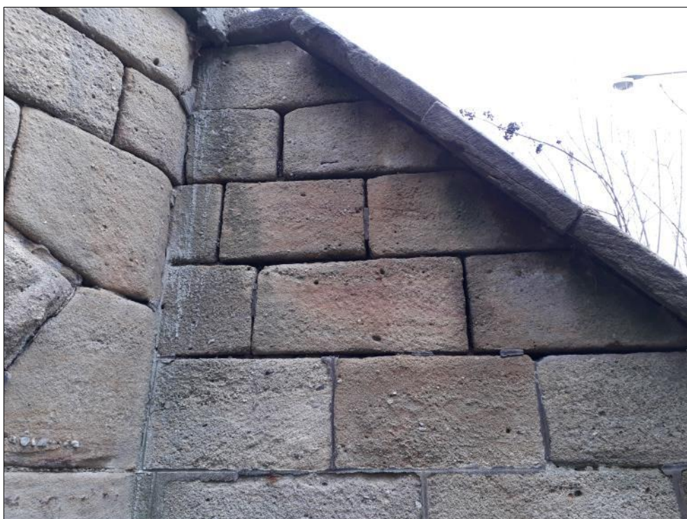
Foto 16: Pohled východní křídlo na povodní straně, patrné nedostatečné vyspárování kamenného zdiva
