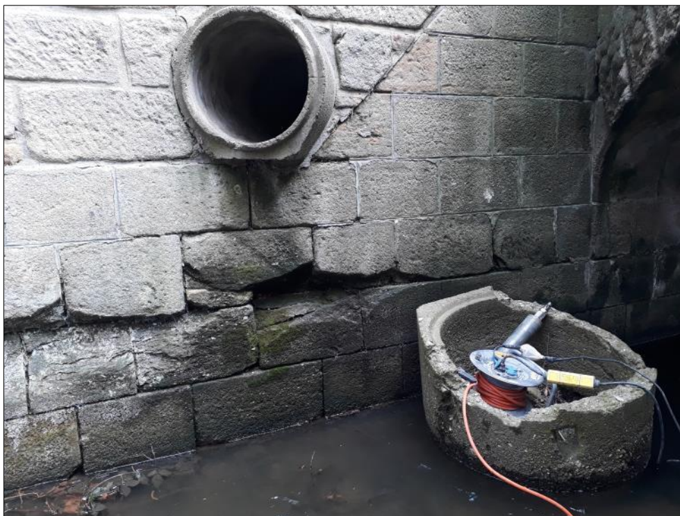
Foto 9: Detail západního křídla návodní strany, patrná degradace pískovcových kvádrů
