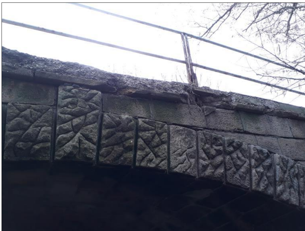
Foto 10: Detail klenebního pásu, patrná degradace betonové římsy
