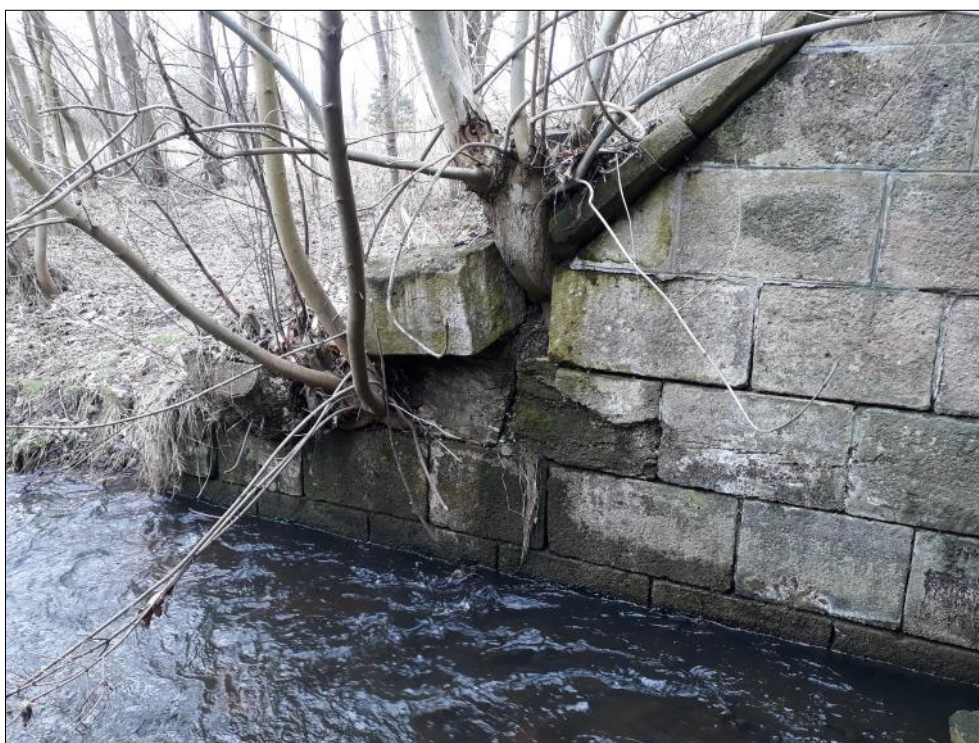
Foto 12: Pohled na západní křídlo povodní strany, patrná degradace zdiva prorůstající vegetací, uvolnění pískovcových bloků
