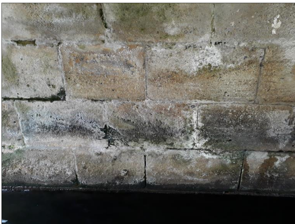
Foto 6: Pohled na západní opěru, patrná degradace pískovcového zdiva, lokálně vyplavená malta ve spodních částech opěry, drobná vegetace
