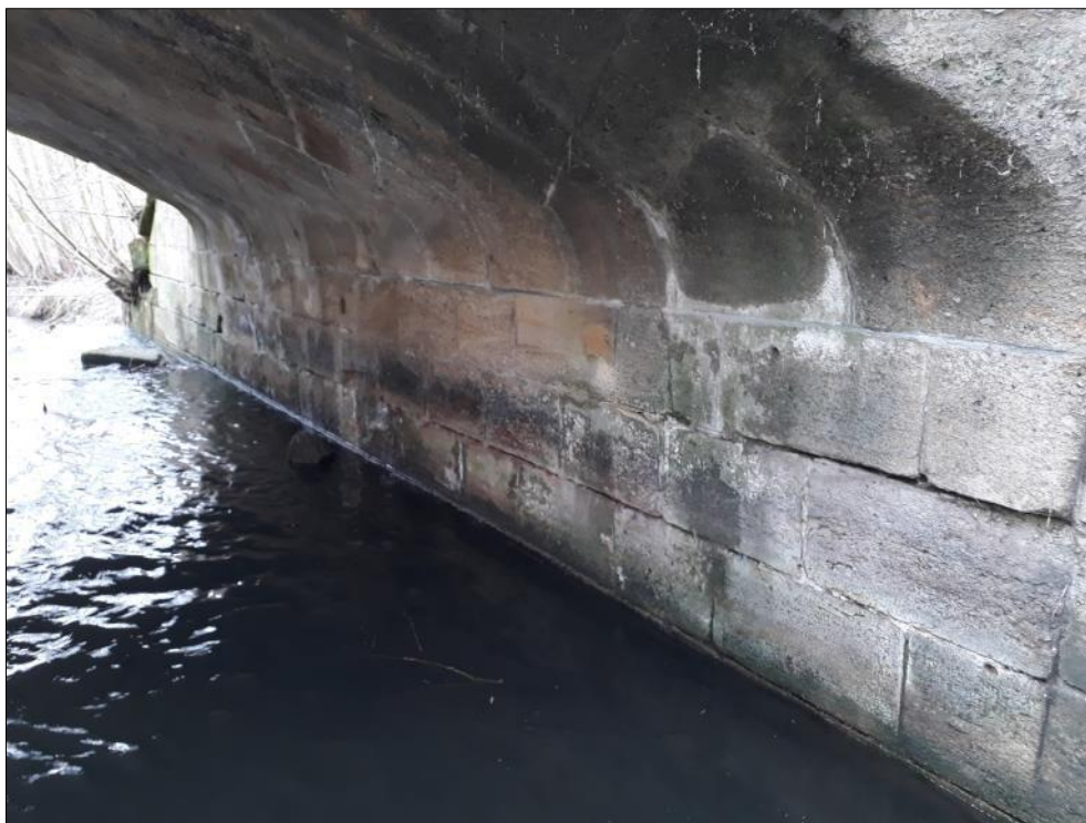
Foto 3: Pohled na západní opěru, patrné posunutí pískovcových kvádrů pod klenbou
