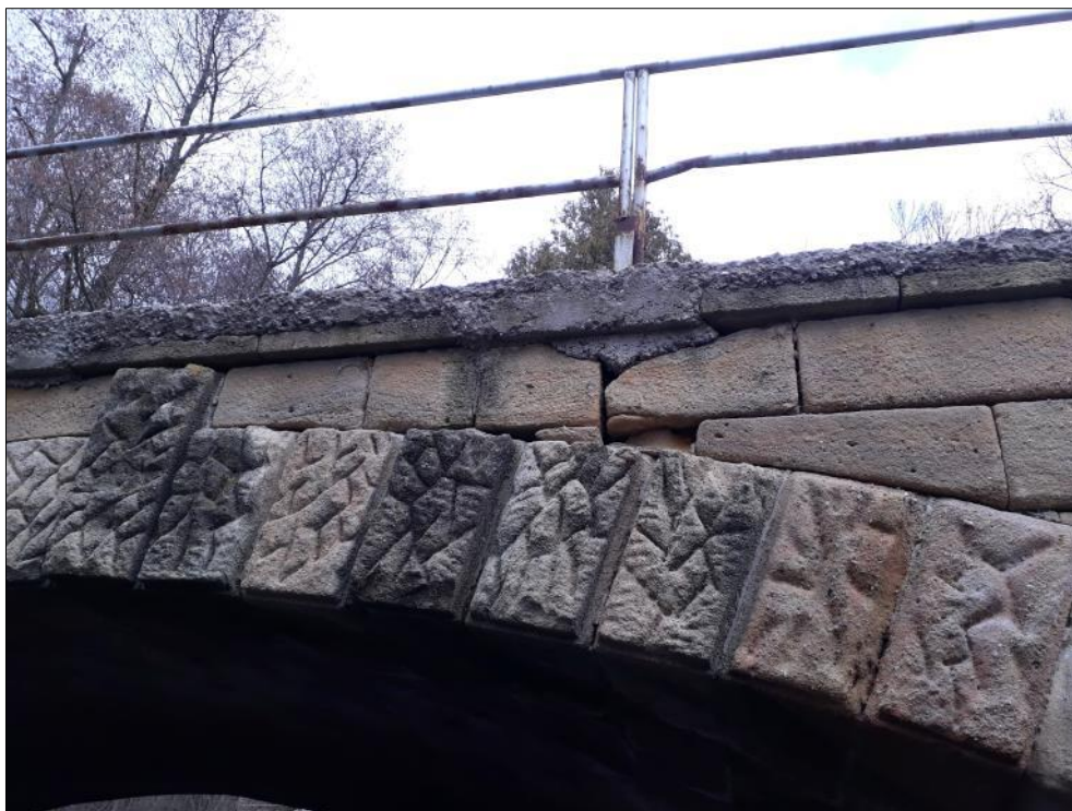
Foto 17: Pohled na povodní stranu vrcholu klenby, patrná degradace pískovce poprsní zídky a degradace betonové římsy
