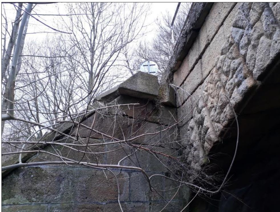
Foto 15: Pohled na západní křídlo povodní strany, patrná degradace a uvolnění horních kvádrů, degradace betonové římsy
