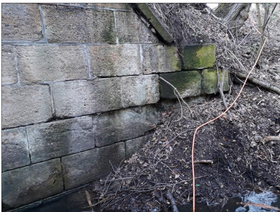
Foto 8: Pohled na západní křídlo návodní strany, patrné uvolňování bloků pískovce
