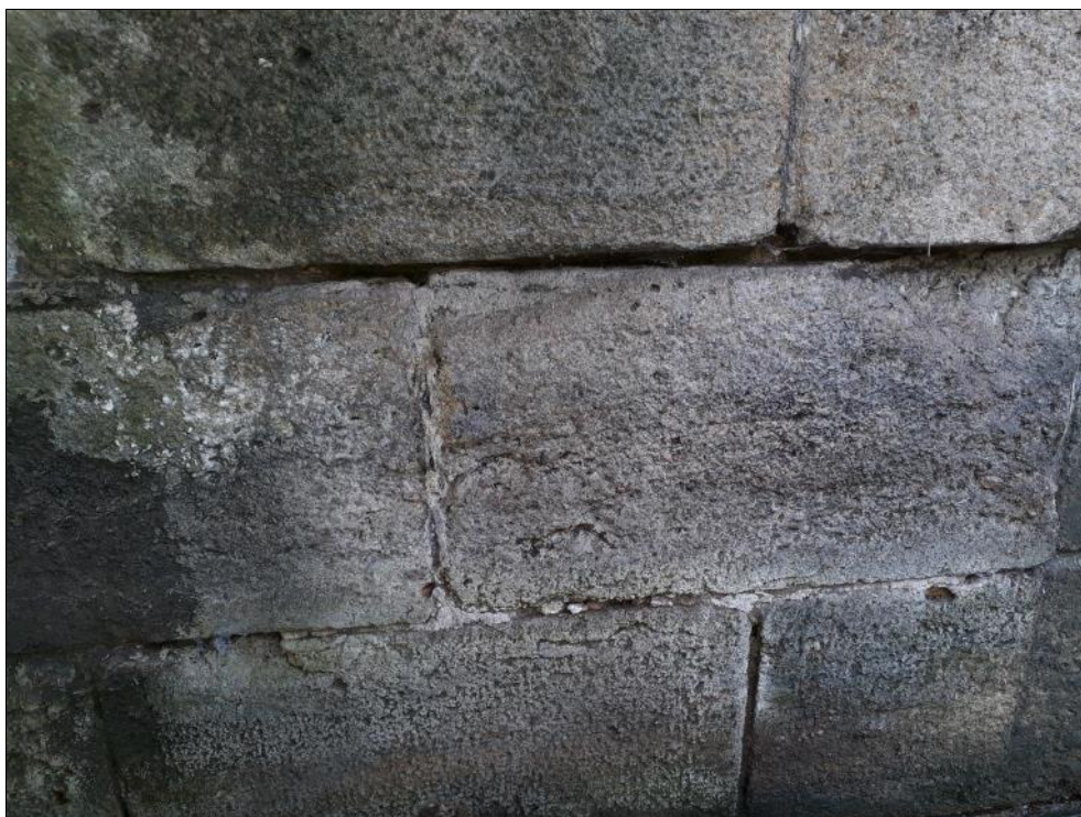
Foto 4: Pohled na západní opěru, patrné posunutí pískovcových kvádrů pod klenbou
