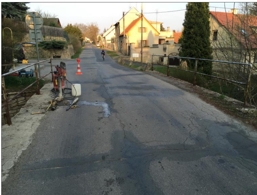
Foto 20: Pohled na vrtání skladby a klenby mostní konstrukce
