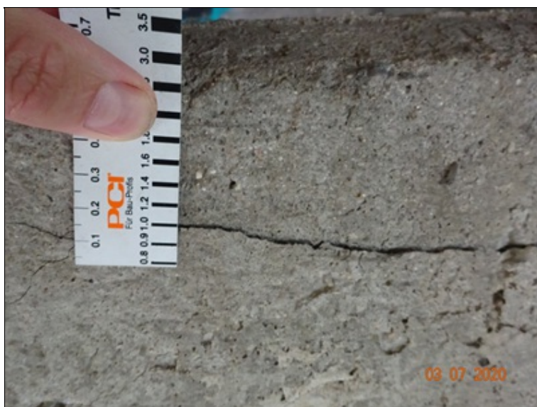
23_ulozny_prah_O4_trhlina_lic.JPG
