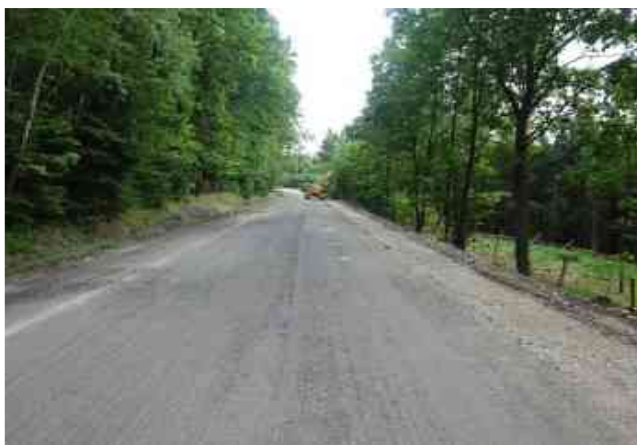
Práce na stabilizaci krajnice v KM 14,200
