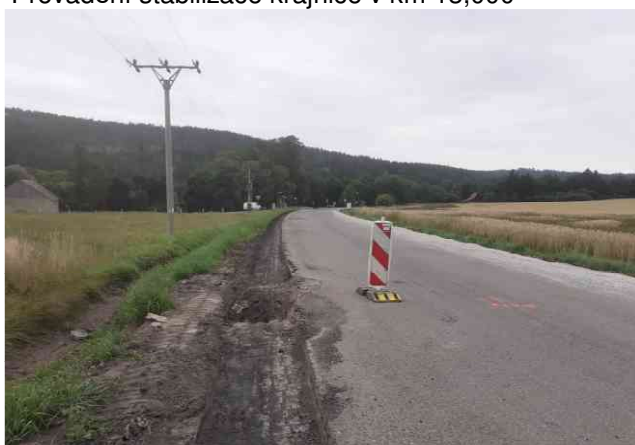
Provádění stabilizace krajnice v km 13,000
