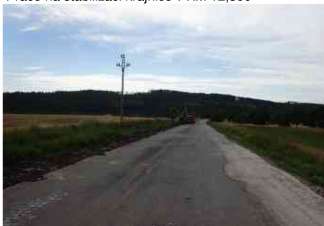
Práce na stabilizaci krajnice v KM 12,800
