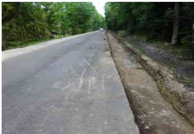
Práce na stabilizaci krajnice v KM 14,500
