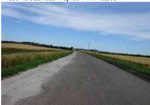
Práce na stabilizaci krajnice v KM 12,800
