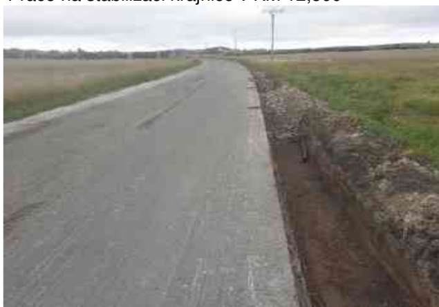
Práce na stabilizaci krajnice v KM 13,100
