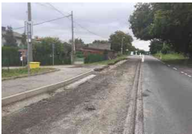
Práce na stabilizaci krajnice v KM 11,300
