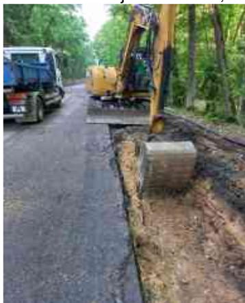
Práce na stabilizaci krajnice v KM 14,500
