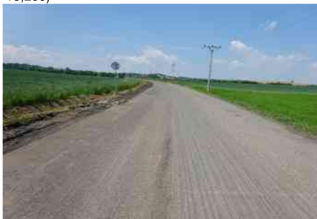
Stav prací na úseku KM 13,000
