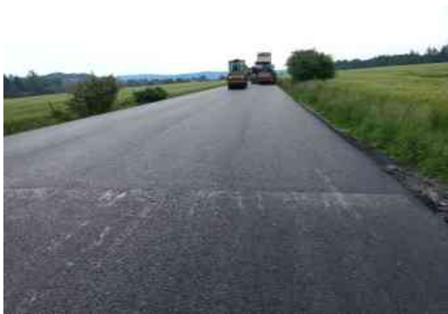
Provádění ACO km 10,600
