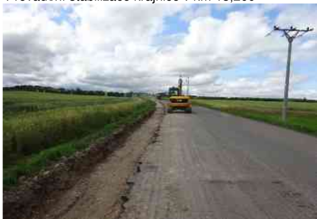
Provádění stabilizace krajnice v km 13,200
