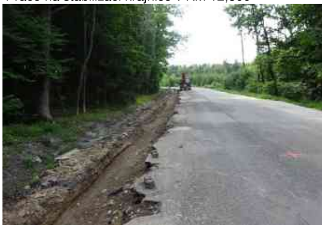
Práce na stabilizaci krajnice v KM 14,500
