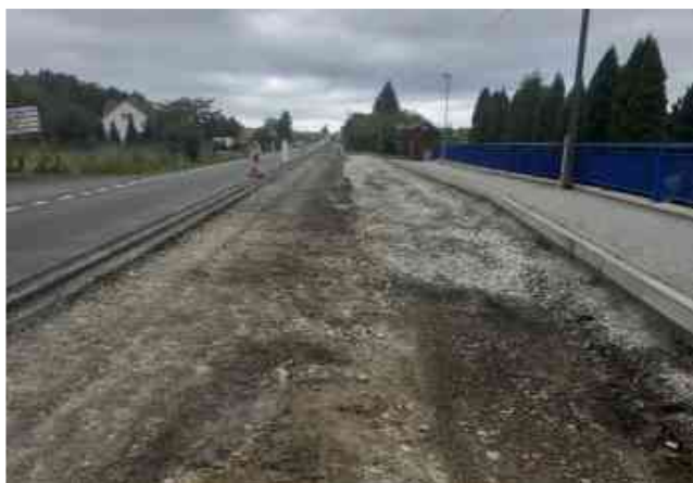
Práce na stabilizaci krajnice v KM 11,300
