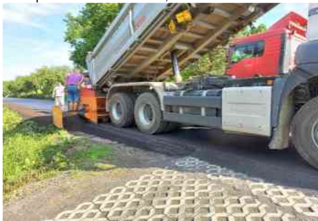
Provádění ACO km 9,800
