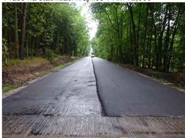
Práce na pokládce ACL v KM 14,500
