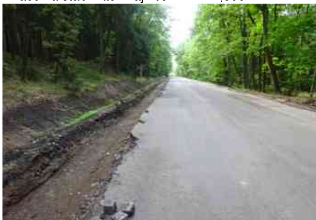
Práce na stabilizaci krajnice v KM 14,300
