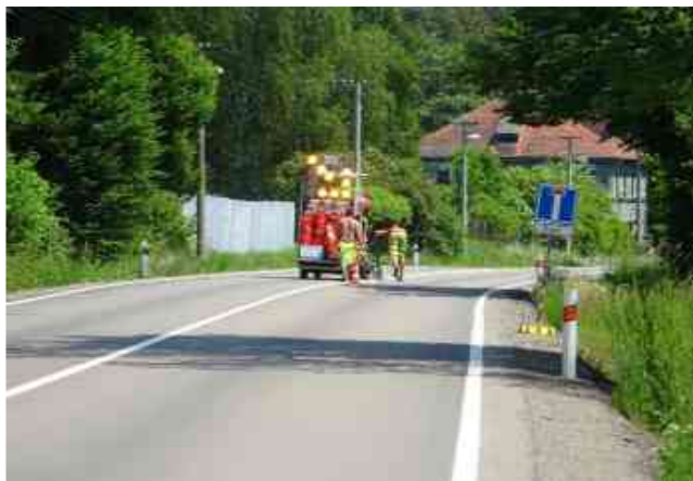
Provádění VDZ-plast na dokončených úsecích (KM 15,200)
