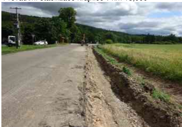
Provádění stabilizace krajnice v km 13,000
