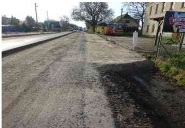
Příprava před pokládkou ACP v KM 11,350
