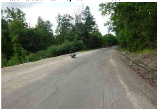
Pokládka SC v KM 14,500
