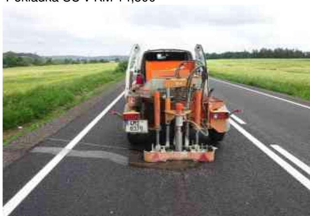
Provádění kontrolních vývrtů tl. vrstev km 10,600
