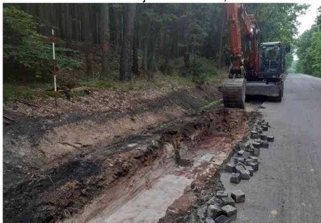
Práce na stabilizaci krajnice v KM 14,200
