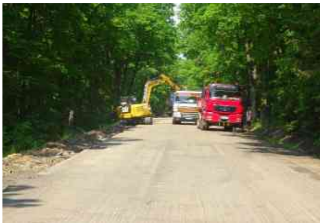
Práce na stabilizaci krajnice v KM 14,600
