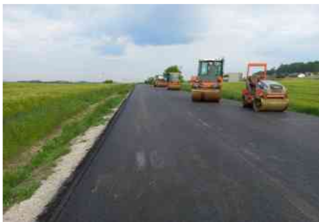
Provádění ACO km 10,600
