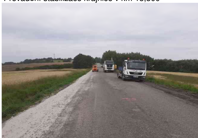
Provádění stabilizace krajnice v km 13,300
