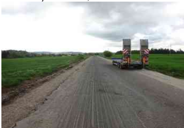
Sanace krajnice v km 10,400
