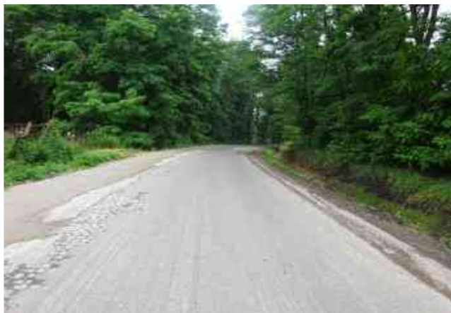
Práce na stabilizaci krajnice v KM 15,000
