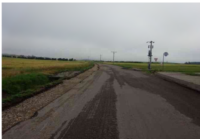
Provádění stabilizace krajnice v km 13,300
