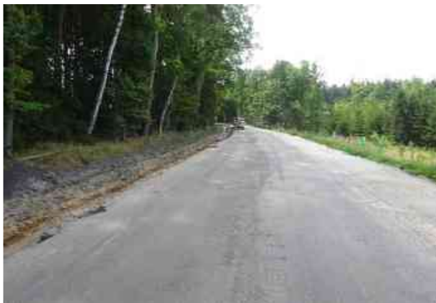
Práce na stabilizaci krajnice v KM 14,600
