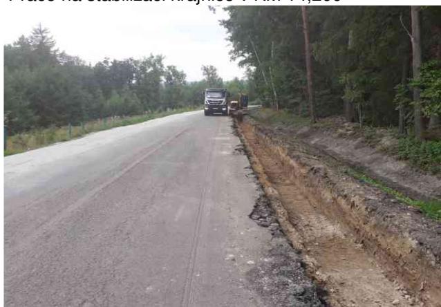
Práce na stabilizaci krajnice v KM 14,700
