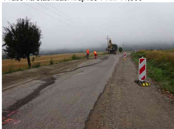
Práce na stabilizaci krajnice v KM 12,500
