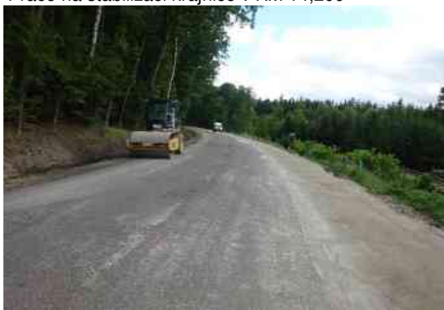
Pokládka SC v KM 14,300
