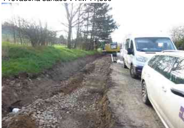
Sanace krajnice v km 9,900
