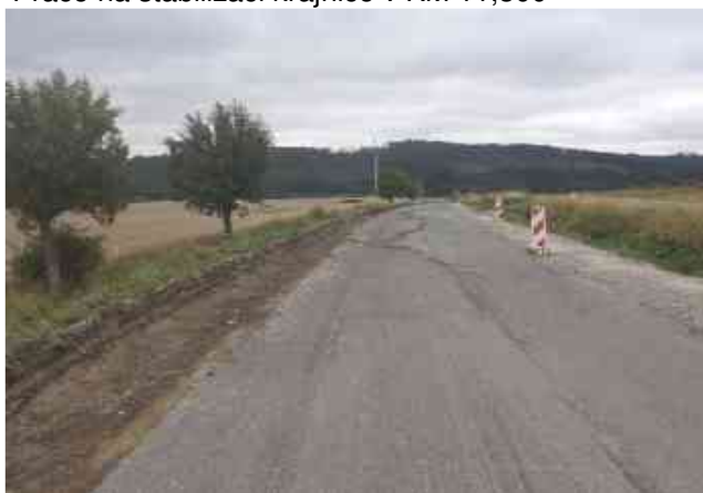
Práce na stabilizaci krajnice v KM 12,500
