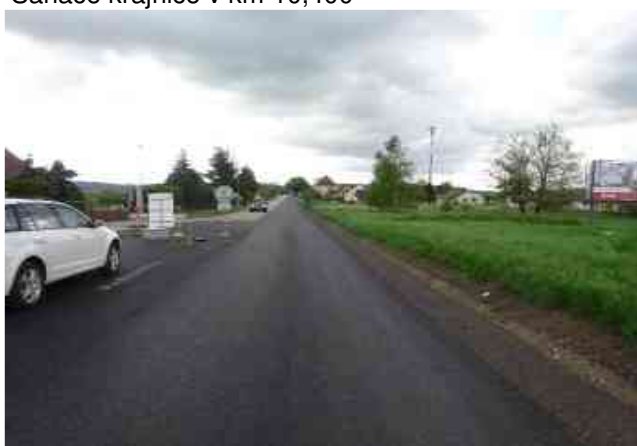
Dokončené ACO pravá strana v obci Chotýšany
