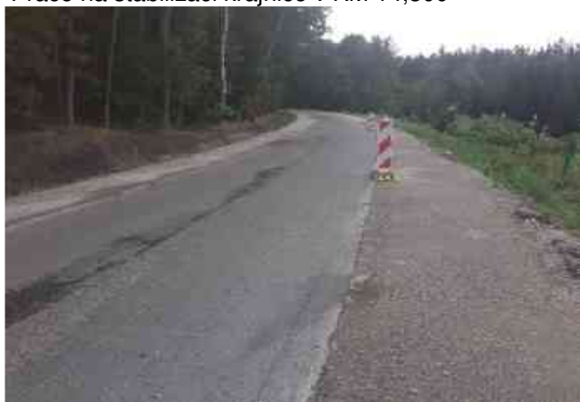
Práce na stabilizaci krajnice v KM 14,300
