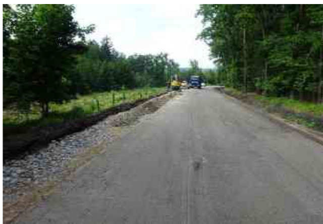
Práce na stabilizaci krajnice v KM 14,800
