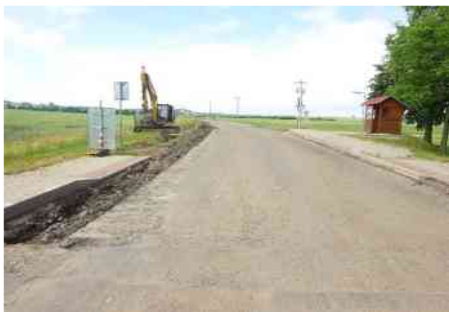
Provádění stabilizace krajnice v km 13,200
