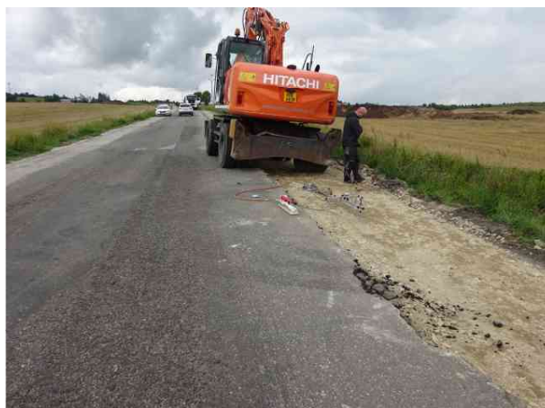
Práce na stabilizaci krajnice v KM 11,500
