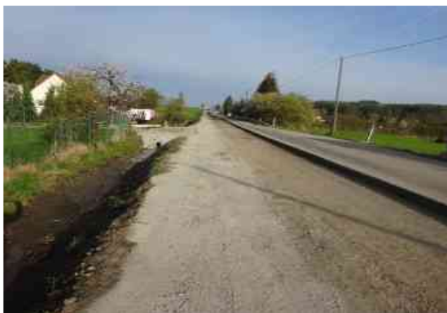
Propustek sjezdu v obci Chotýšany v KM 11,280
