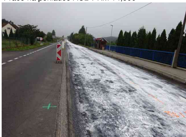
Příprava pro pokládku ACP v obci Chotýšany
