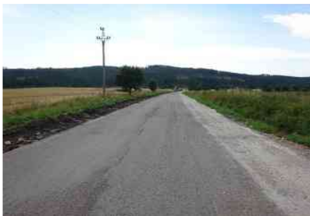
Práce na stabilizaci krajnice v KM 12,300
