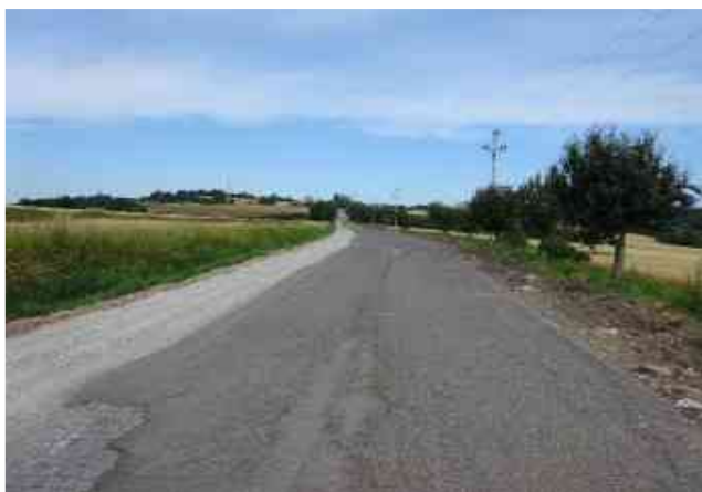
Práce na stabilizaci krajnice v KM 12,300
