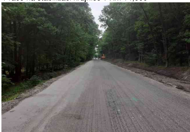
Práce na stabilizaci krajnice v KM 14,500
