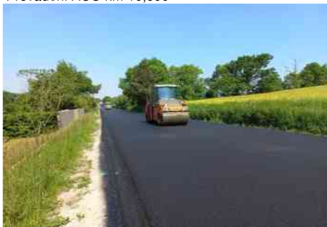
Provádění ACO km 10,600
