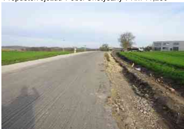
Sanace krajnice v km 10,300
