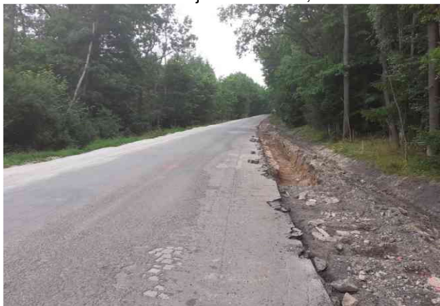
Práce na stabilizaci krajnice v KM 14,600
