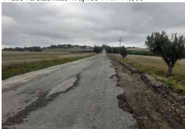
Práce na stabilizaci krajnice v KM 12,500
