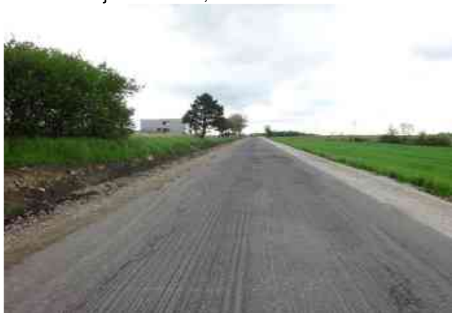
Sanace krajnice v km 10,200
