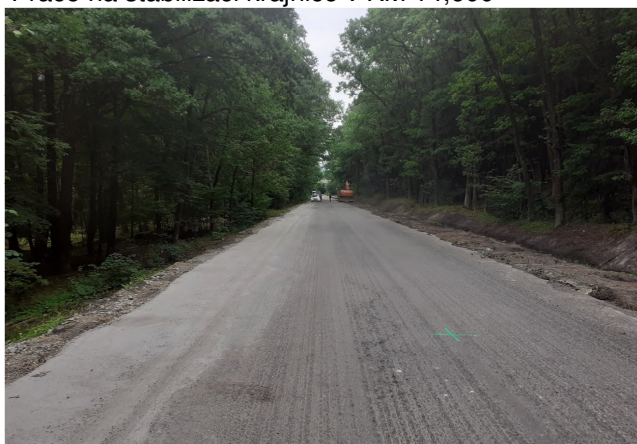
Práce na stabilizaci krajnice v KM 14,500
