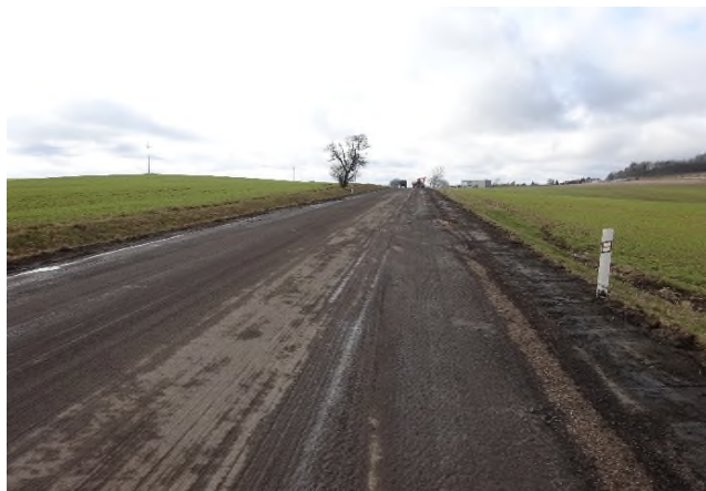
Vyfrézovaná vozovka v úseku cca KM 10,900
