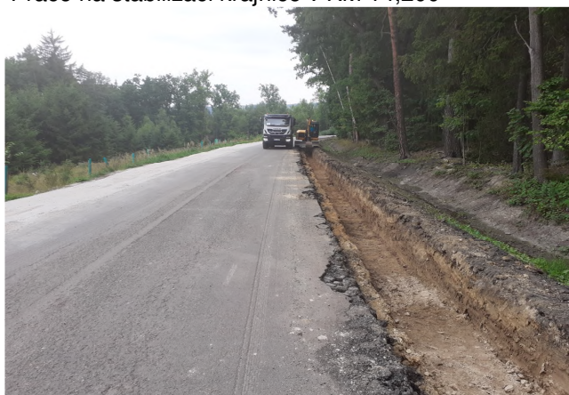
Práce na stabilizaci krajnice v KM 14,700
