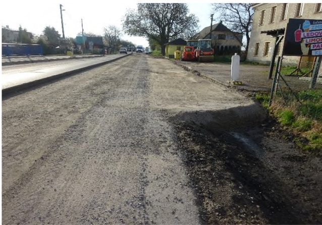
Příprava před pokládkou ACP v KM 11,350
