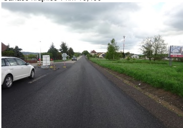
Dokončené ACO pravá strana v obci Chotýšany
