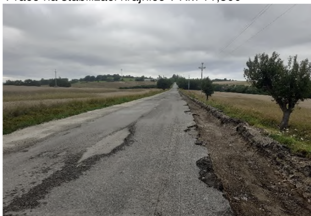
Práce na stabilizaci krajnice v KM 12,500
