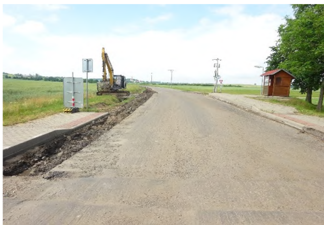
Provádění stabilizace krajnice v km 13,200
