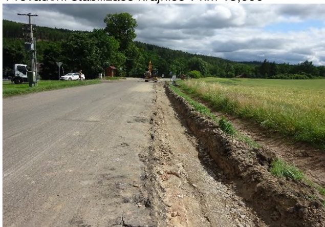
Provádění stabilizace krajnice v km 13,000
