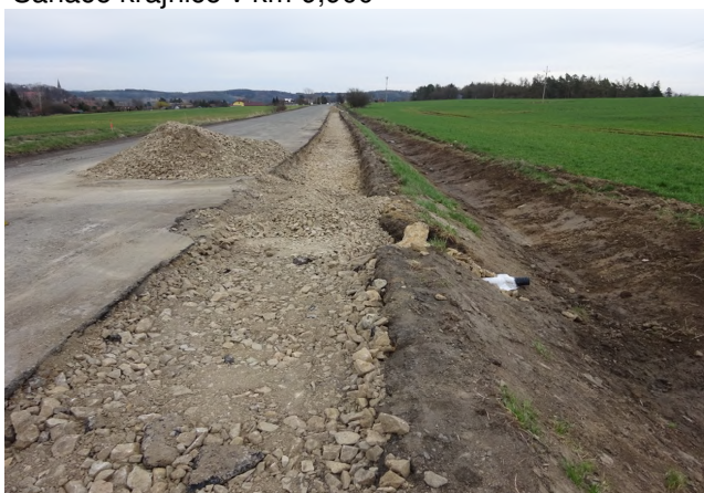
Sanace krajnice v km 10,500
