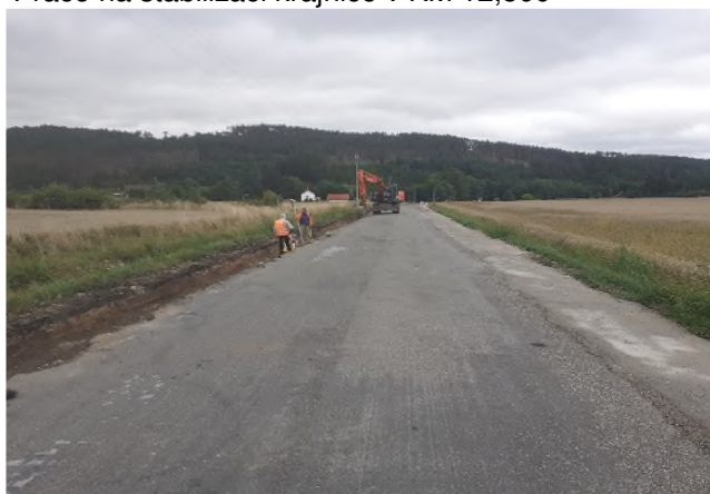
Práce na stabilizaci krajnice v KM 13,000
