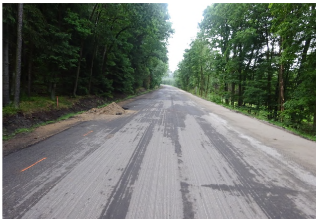
Práce na stabilizaci krajnice v KM 14,300
