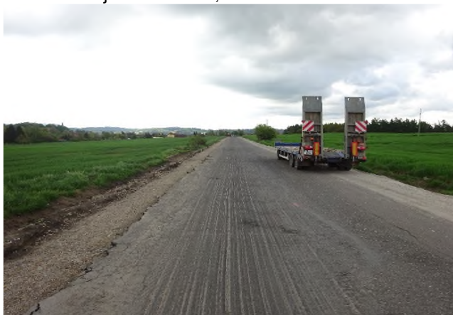
Sanace krajnice v km 10,400
