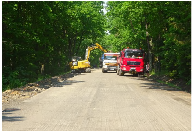
Práce na stabilizaci krajnice v KM 14,600
