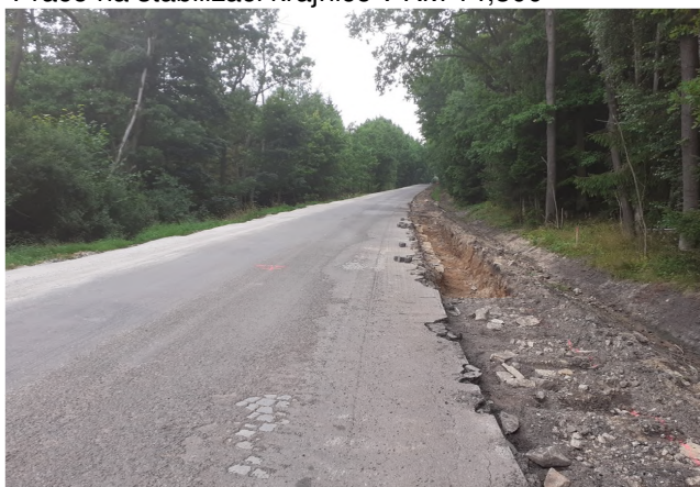
Práce na stabilizaci krajnice v KM 14,600
