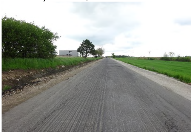
Sanace krajnice v km 10,200
