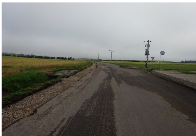
Provádění stabilizace krajnice v km 13,300
