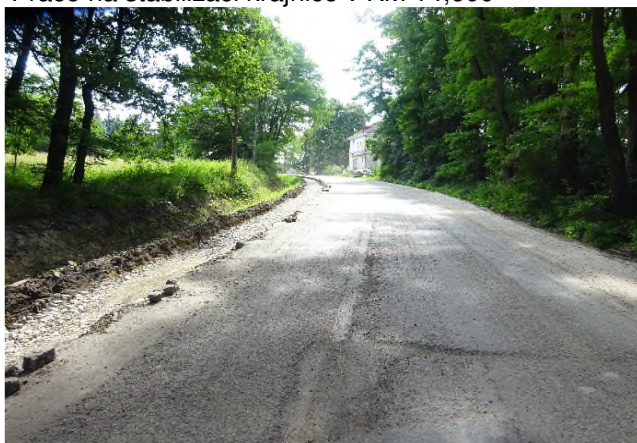
Práce na stabilizaci krajnice v KM 14,600
