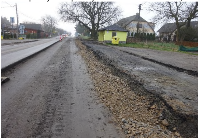
Sanace krajnice v km 11,350
