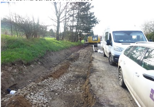
Sanace krajnice v km 9,900
