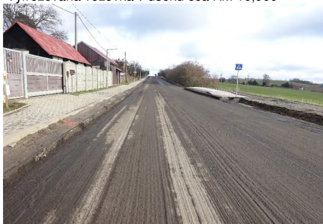
Vyfrézovaná vozovka v úseku cca KM 10,900
