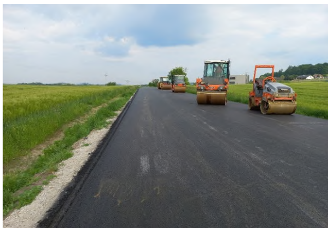
Provádění ACO km 10,600
