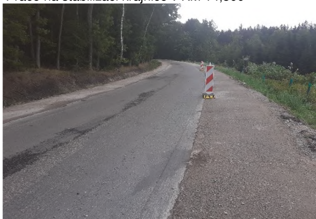
Práce na stabilizaci krajnice v KM 14,300
