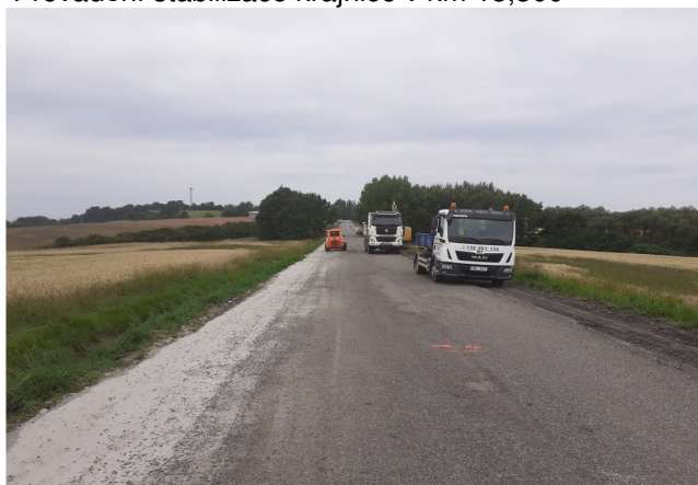
Provádění stabilizace krajnice v km 13,300
