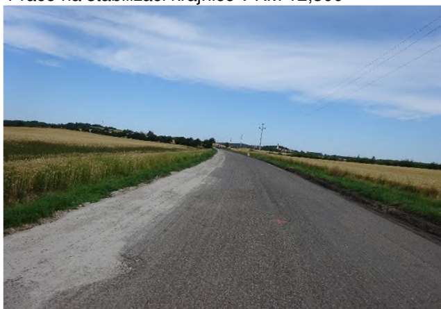
Práce na stabilizaci krajnice v KM 12,800
