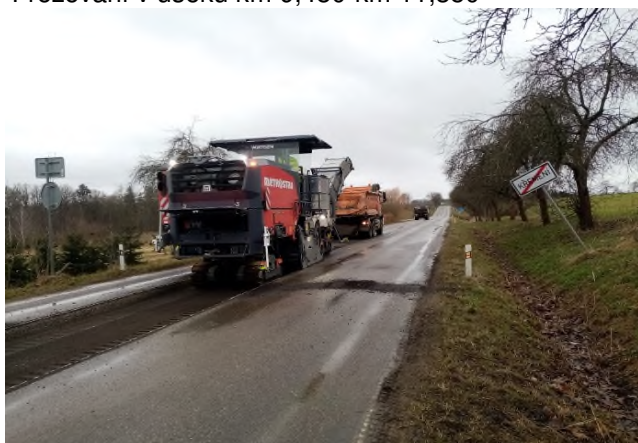
Frézování v úseku
