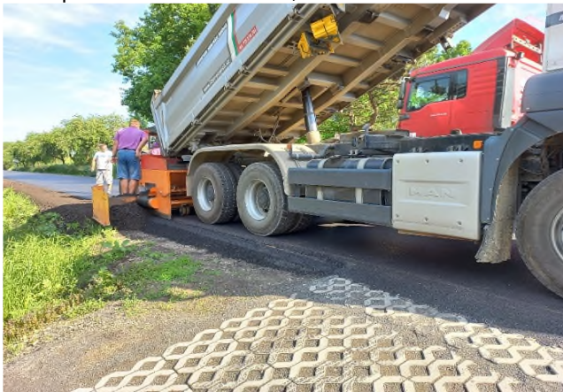
Provádění ACO km 9,800
