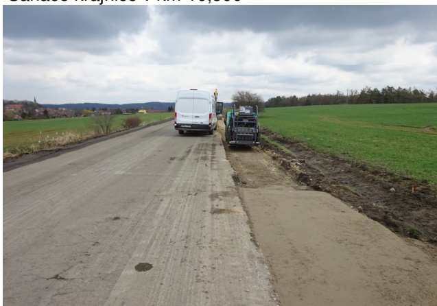
Pokládka SC v km 10,700
