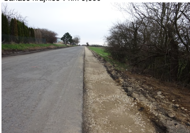
Sanace krajnice v km 10,200
