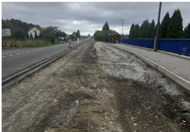
Práce na stabilizaci krajnice v KM 11,300
