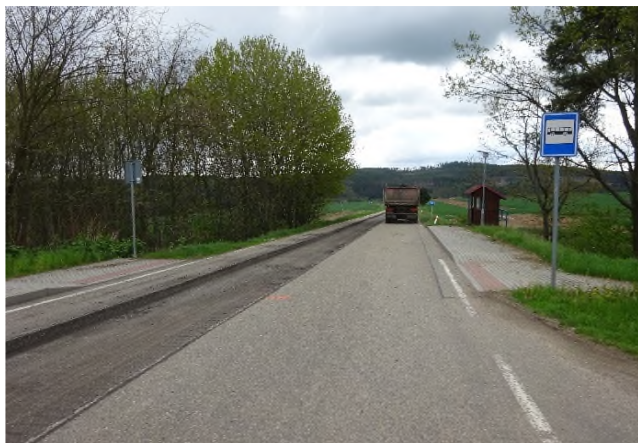
Frézování úseku KM 12,150-13,320
