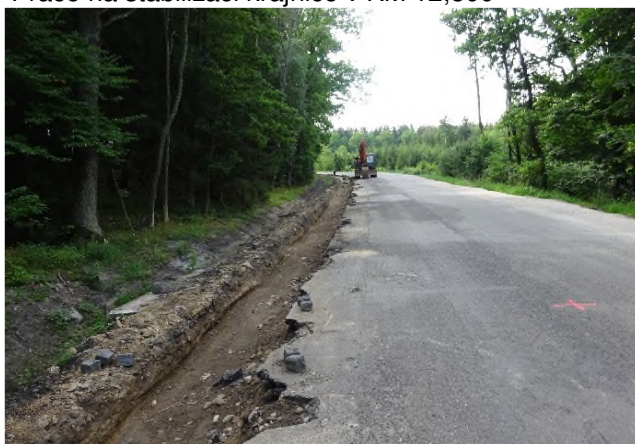
Práce na stabilizaci krajnice v KM 14,500
