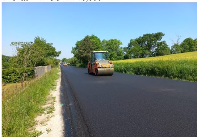
Provádění ACO km 10,600
