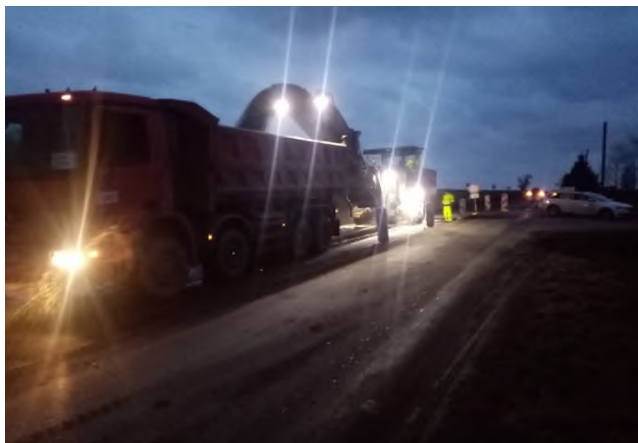
Frézování v úseku km 9,480-km 11,350
