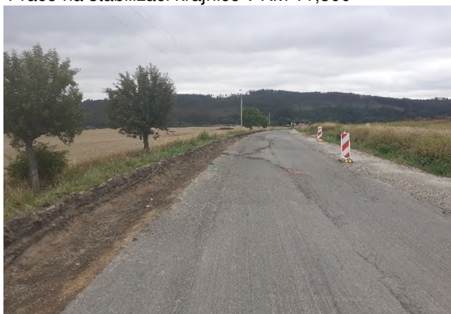
Práce na stabilizaci krajnice v KM 12,500
