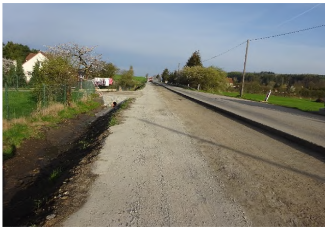
Propustek sjezdu v obci Chotýšany v KM 11,280
