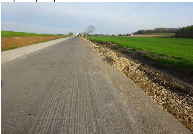
Prováděná sanace v KM 11,800
