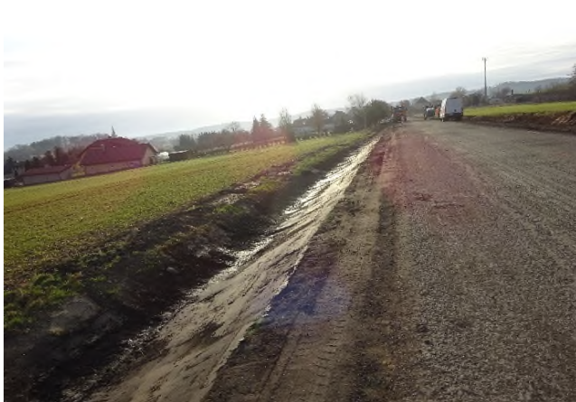
Vyčištěný příkop km 11,000
