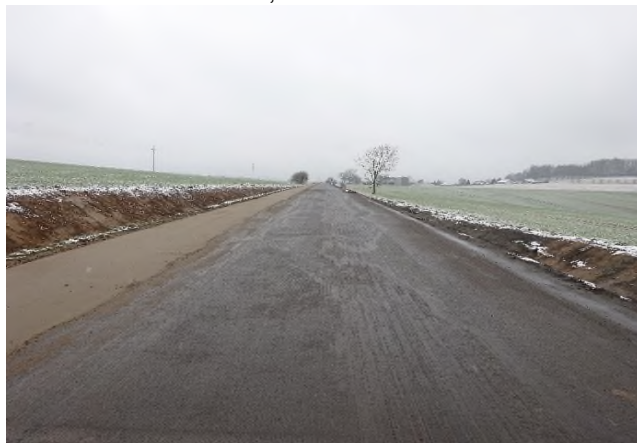
Položené SC v km 10,900
