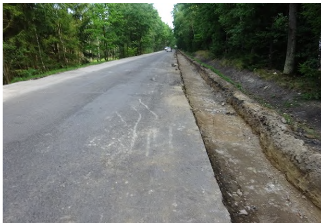
Práce na stabilizaci krajnice v KM 14,500
