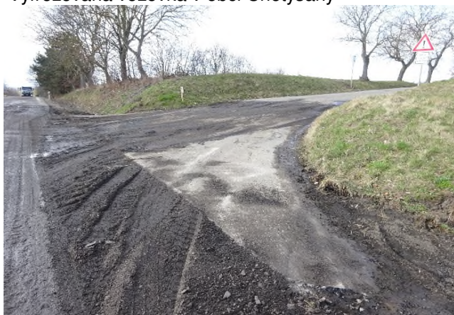
Vyfrézovaná vozovka v obci Chotýšany
