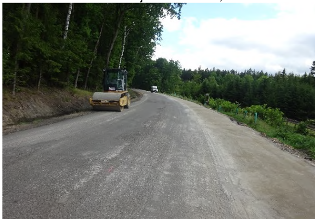
Pokládka SC v KM 14,300
