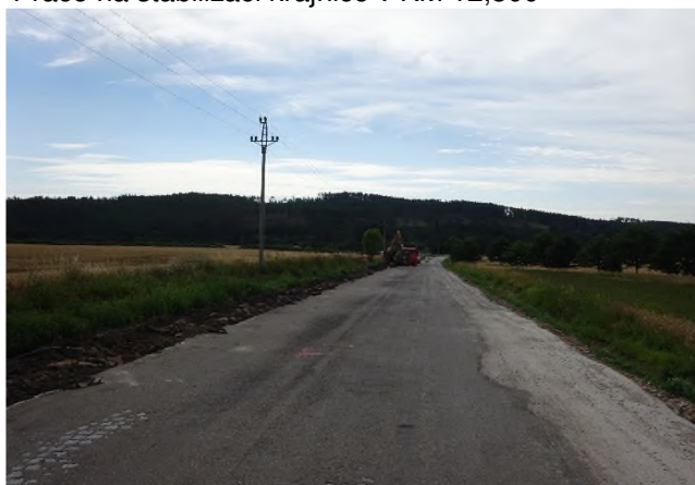
Práce na stabilizaci krajnice v KM 12,800
