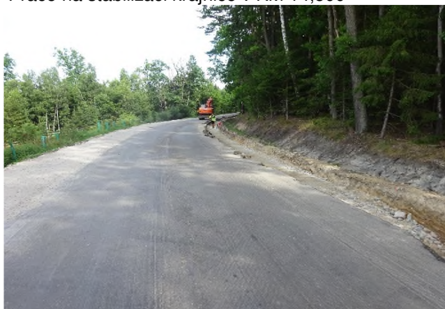
Práce na stabilizaci krajnice v KM 14,500
