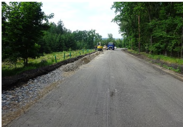
Práce na stabilizaci krajnice v KM 14,800
