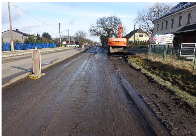
Vyfrézovaná vozovka v obci Chotýšany
