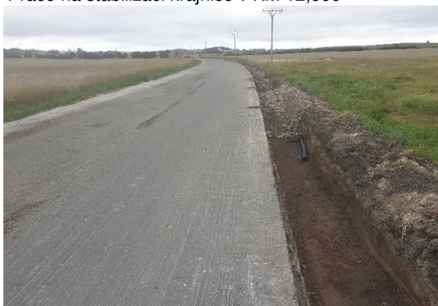
Práce na stabilizaci krajnice v KM 13,100
