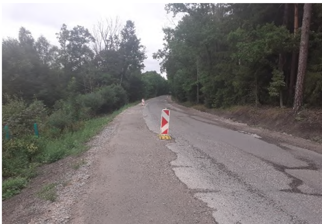
Práce na stabilizaci krajnice v KM 14,700
