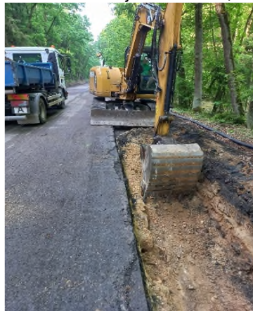
Práce na stabilizaci krajnice v KM 14,500
