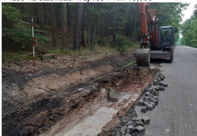
Práce na stabilizaci krajnice v KM 14,200
