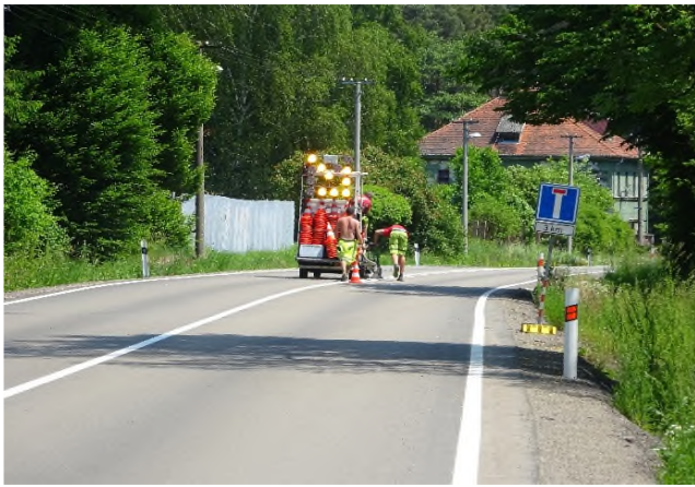
Provádění VDZ-plast na dokončených úsecích (KM 15,200)
