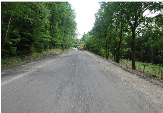
Práce na stabilizaci krajnice v KM 14,200
