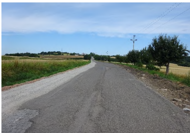
Práce na stabilizaci krajnice v KM 12,300
