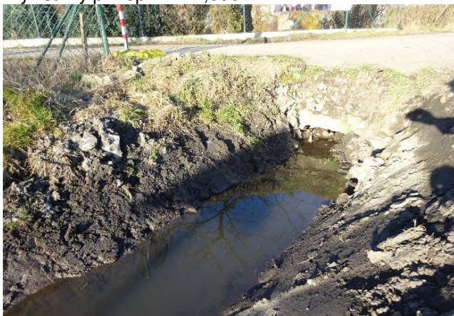
Nefunkční propustek na sjezdu v km 11,200 - obec Chotýšany
