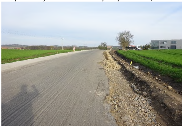
Sanace krajnice v km 10,300
