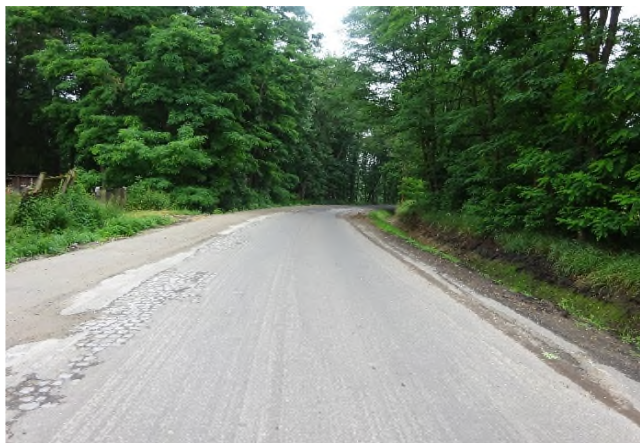
Práce na stabilizaci krajnice v KM 15,000
