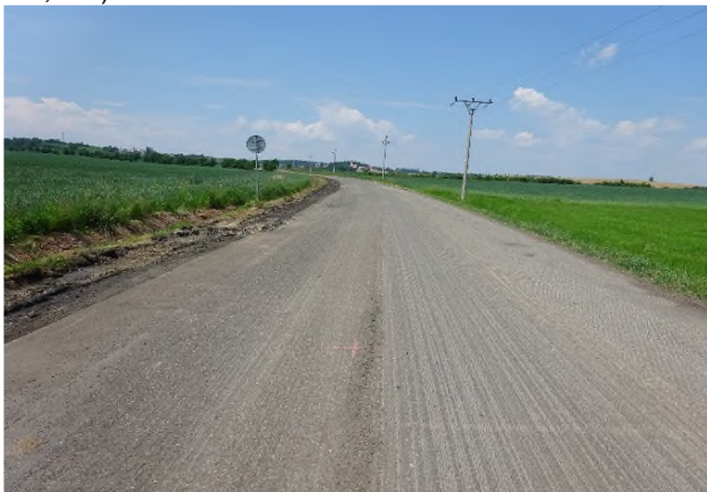
Stav prací na úseku KM 13,000
