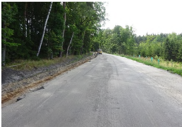
Práce na stabilizaci krajnice v KM 14,600
