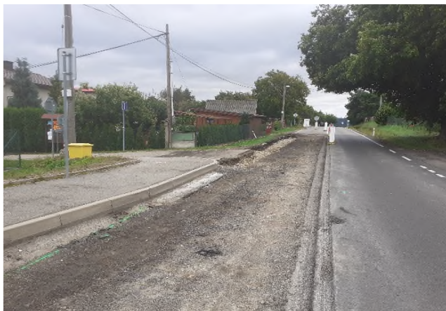
Práce na stabilizaci krajnice v KM 11,300
