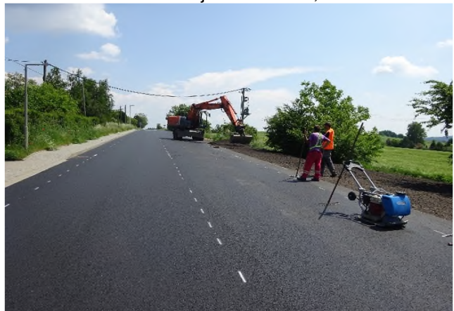
Provádění krajnic v KM 10,000
