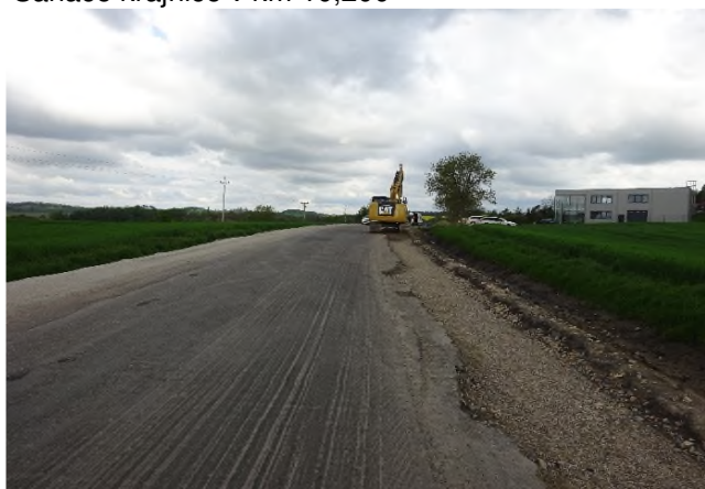
Provádění SC km 10,350
