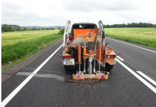
Provádění kontrolních vývrtů tl. vrstev km 10,600
