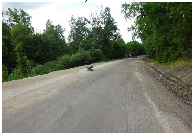
Pokládka SC v KM 14,500
