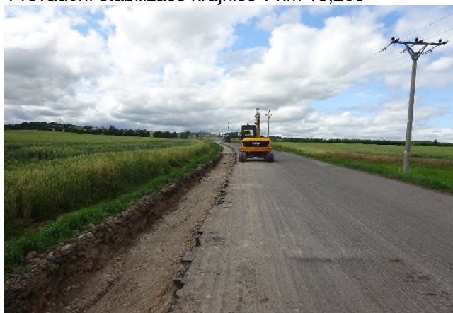
Provádění stabilizace krajnice v km 13,200
