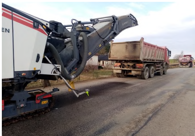
Frézování v úseku km 9,480-km 11,350
