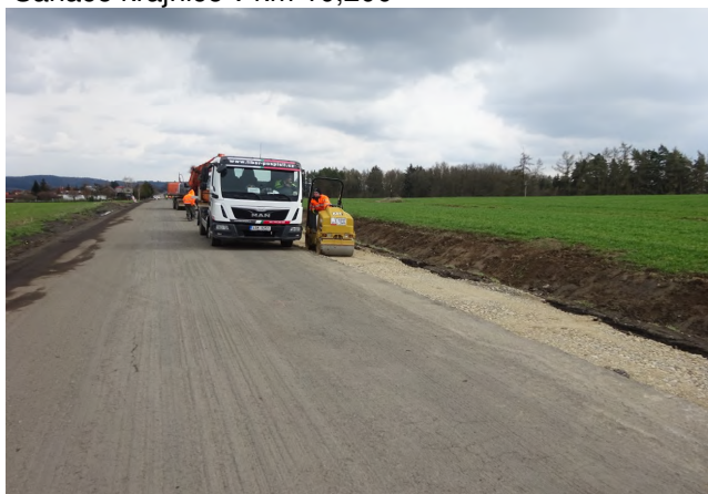
Sanace krajnice v km 10,700
