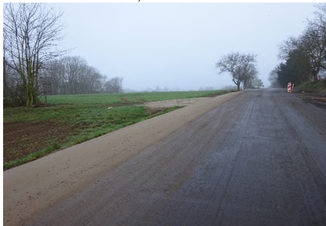
Pokládka SC v km 10,700
