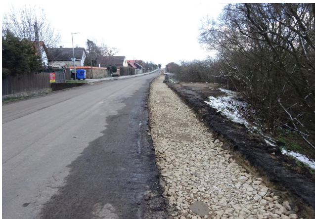
Sanace krajnice v km 9,900
