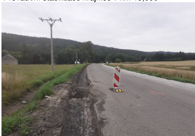
Provádění stabilizace krajnice v km 13,000
