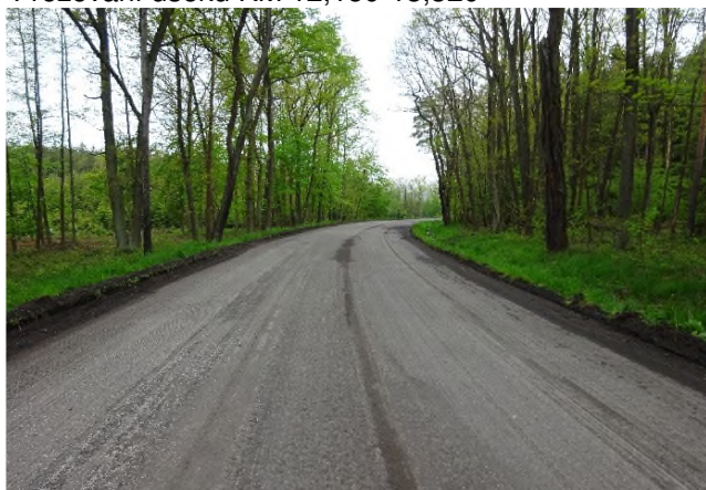
Frézování úseku KM 12,150-13,320
