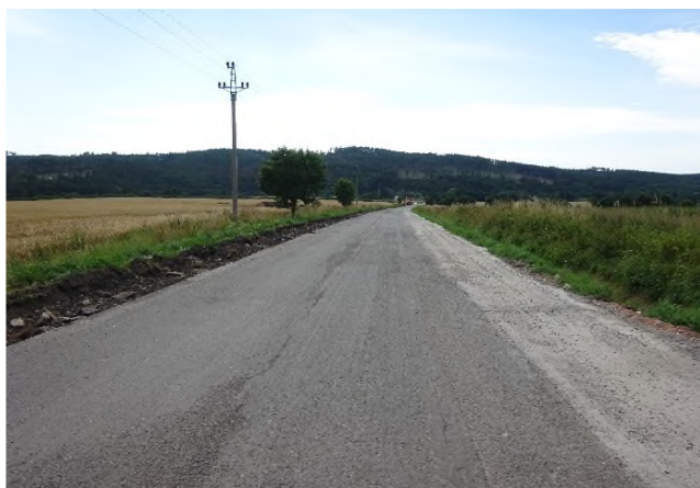
Práce na stabilizaci krajnice v KM 12,300
