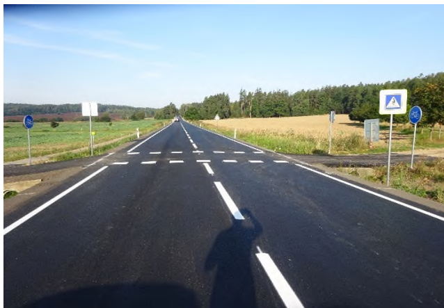
Dokončená komunikace v úseku KM 15,020 - 17,788
