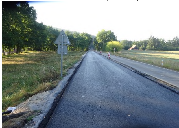
Položené ACP v úseku KM 13,320-14,260
