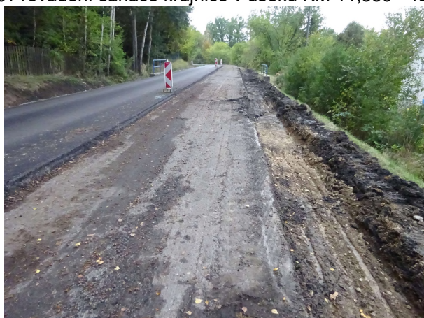
Provádění sanace krajnice v úseku KM 13,32-14,26
