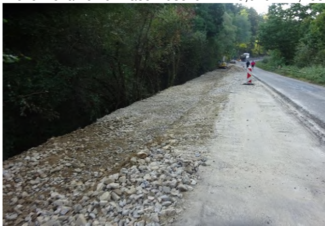
Sanace komunikace v KM 13,320-14,260 před SC
