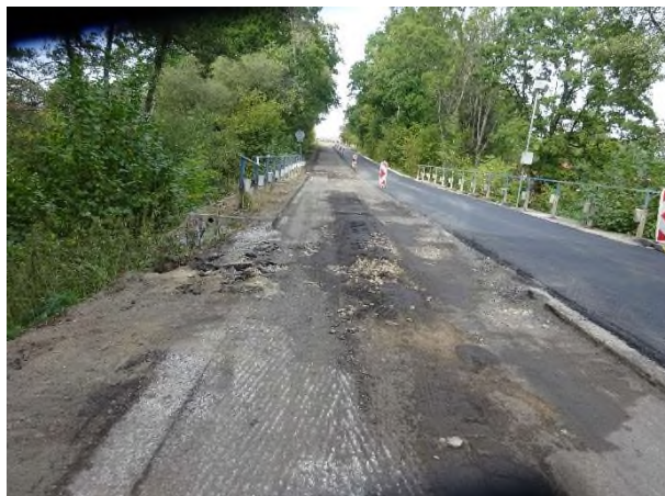
Čištění příkopů v úseku KM 13,320-14,260
