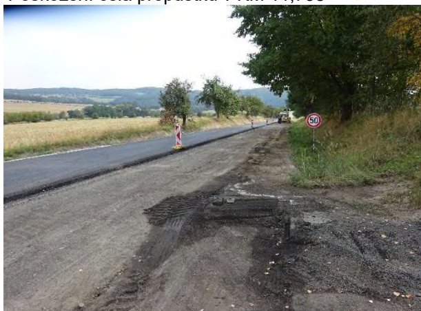
Čištění příkopů v úseku KM 11,350 - 12,150
