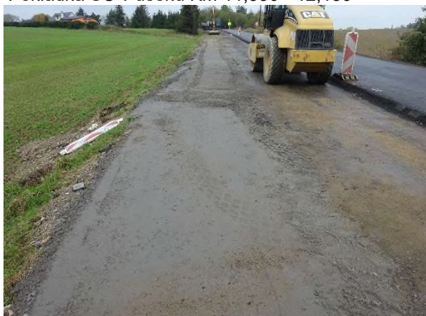
Pokládka SC v úseku KM 11,350 - 12,150
