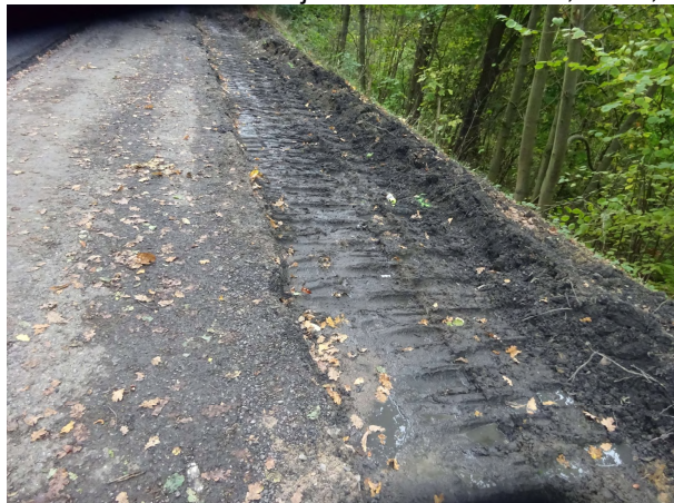
Provádění sanace krajnice v úseku KM 13,32-14,26
