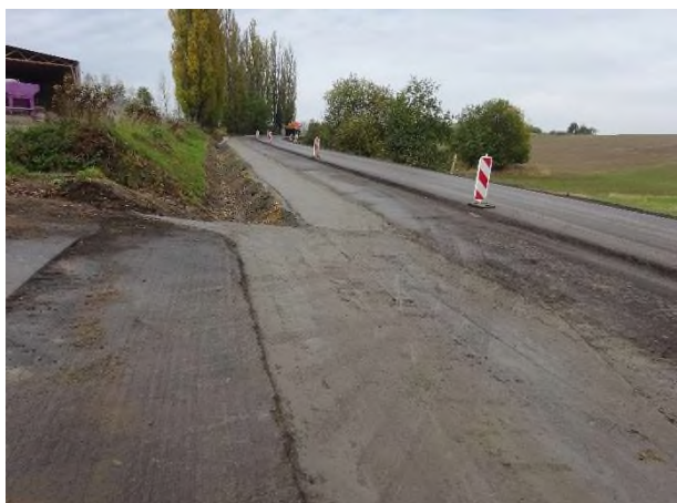
Pokládka SC v úseku KM 11,350 - 12,150
