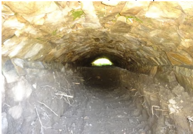
Čištění propustku v KM 11,738
