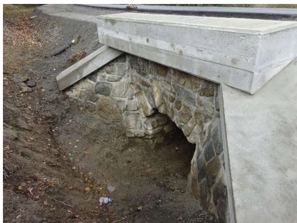
Opravený propustek v KM 11,738
