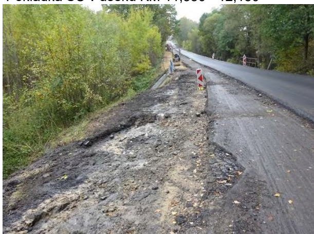
Provádění sanace krajnice v úseku KM 13,32-14,26
