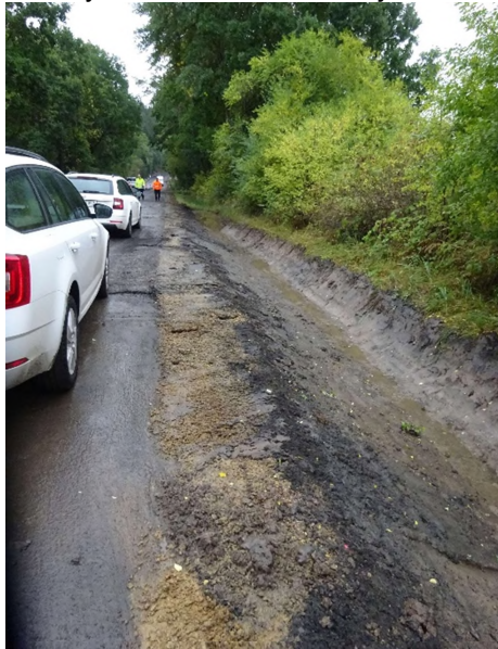
Vyčištěné příkopy v KM 13,320-14,260
