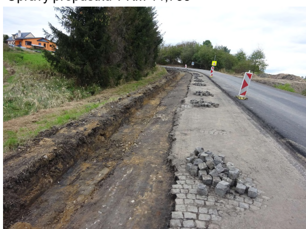
Provádění sanace krajnice v úseku KM 11,350 - 12,150 Provádění sanace krajnice v úseku KM 11,350 - 12,150
