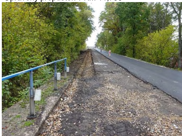
Provádění sanace krajnice v úseku KM 13,32-14,26
