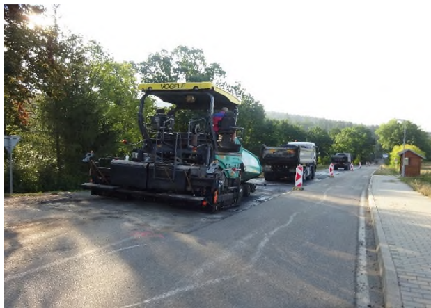
Pokládka ACP v úseku KM 13,320-14,260
