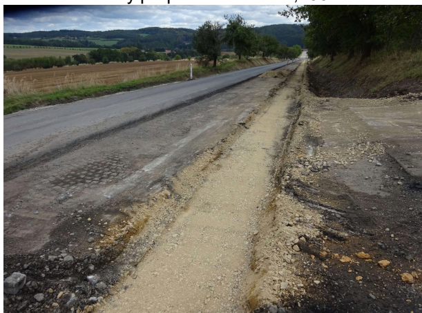
Provádění sanace krajnice v úseku KM 11,350 - 12,150 Provádění sanace krajnice v úseku KM 11,350 - 12,150
