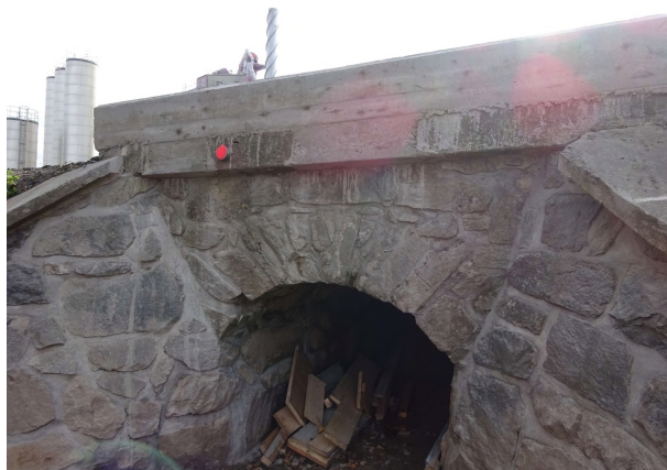
Opravy propustku v KM 11,738
