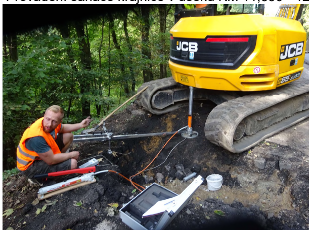
Ověřování podloží krajnic cca v KM 14,200
