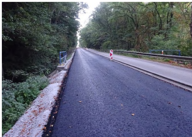
Položené ACL v KM 13,320-14,260
