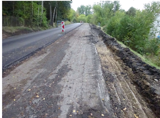
Provádění sanace krajnice v úseku KM 13,32-14,26
