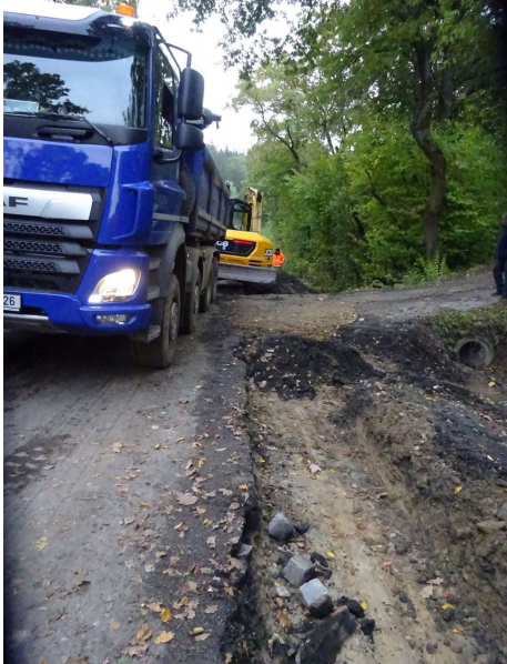
Provádění sanace krajnice v úseku KM 13,32-14,26
