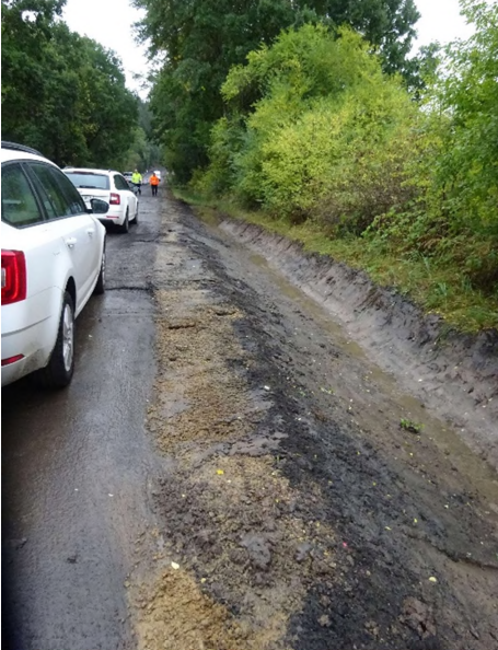
Vyčištěné příkopy v KM 13,320-14,260
