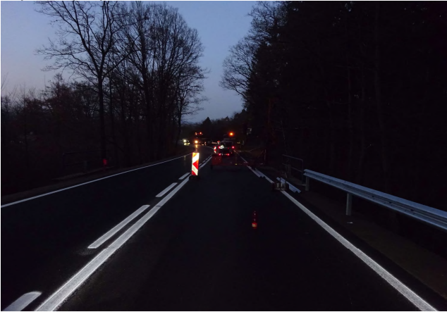
Osazování svodidel v úseku KM 13,32-14,26
