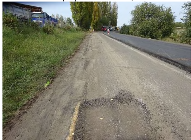
Čištění příkopů v úseku KM 11,350 - 12,150
