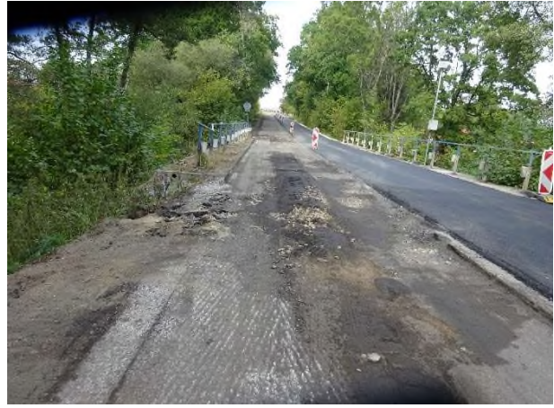
Čištění příkopů v úseku KM 13,320-14,260
