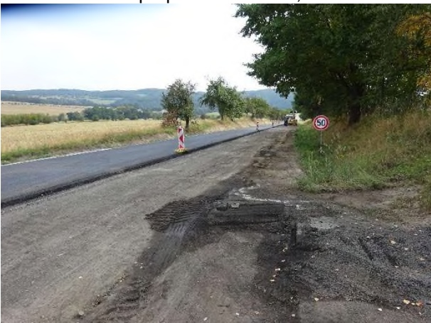
Čištění příkopů v úseku KM 11,350 - 12,150
