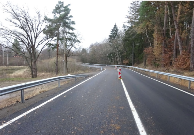
Dokončený úsek v úseku KM 13,32-14,26
