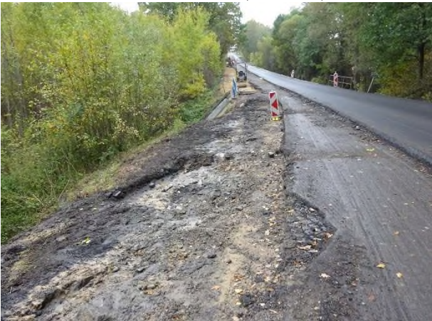
Provádění sanace krajnice v úseku KM 13,32-14,26
