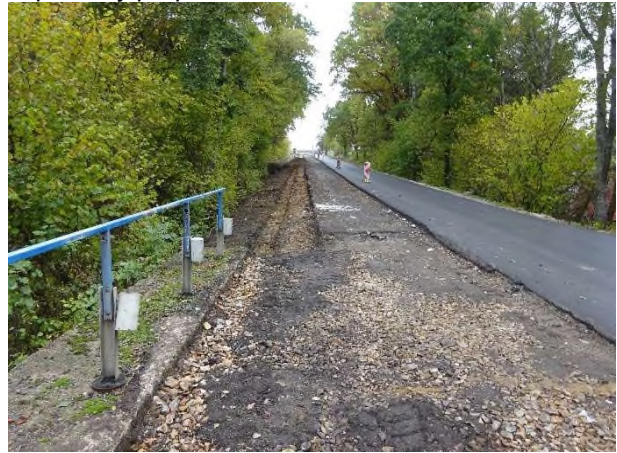
Provádění sanace krajnice v úseku KM 13,32-14,26
