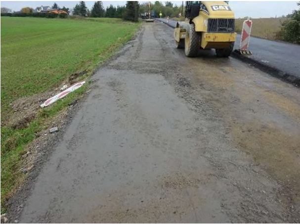
Pokládka SC v úseku KM 11,350 - 12,150
