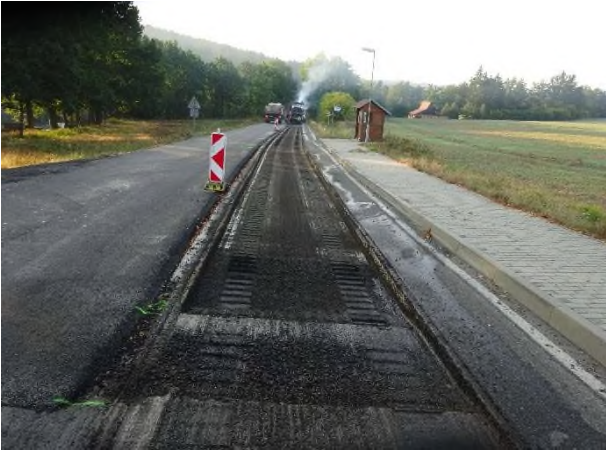
Převedení dopravy a frézování vozovky v úseku KM 13,320-14,260
