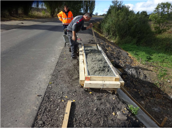
Povádění římsy propustku v KM 11,738
