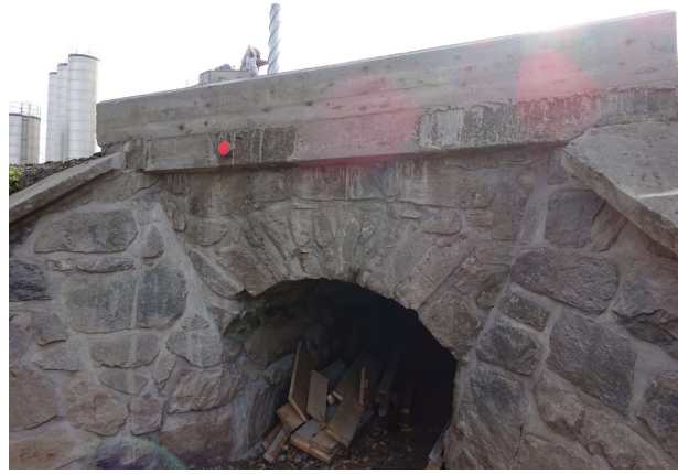
Opravy propustku v KM 11,738
