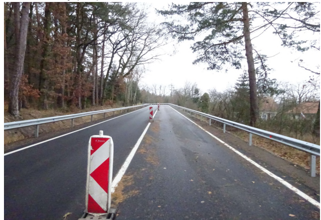
Dokončený úsek v úseku KM 13,32-14,26
