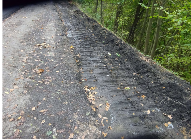
Provádění sanace krajnice v úseku KM 13,32-14,26
