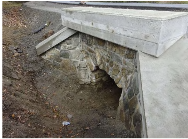
Opravený propustek v KM 11,738
