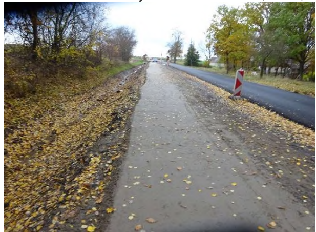
Pokládka SC v úseku KM 13,32-14,26
