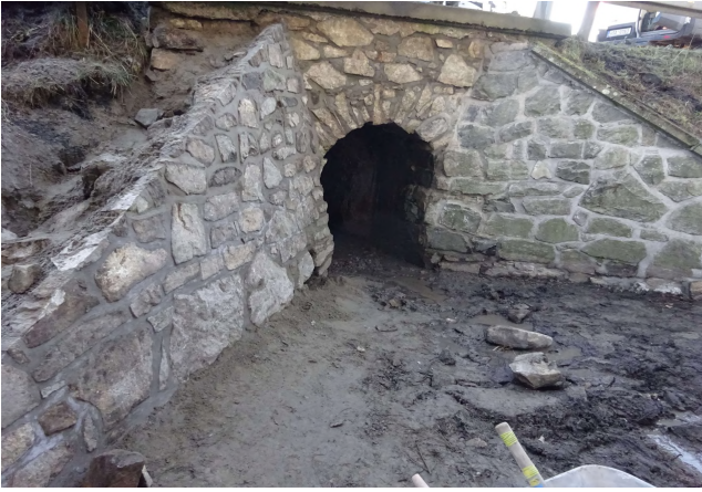
Oprava propustku v KM 11,2148
