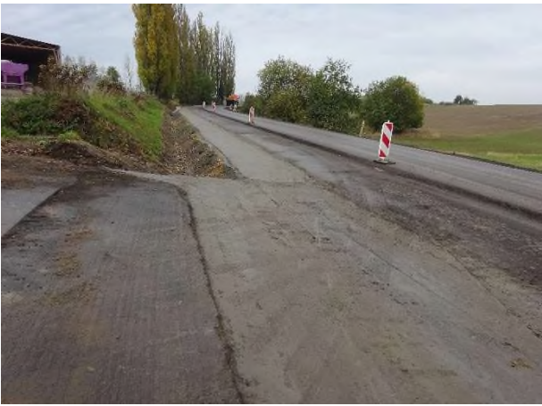
Pokládka SC v úseku KM 11,350 - 12,150
