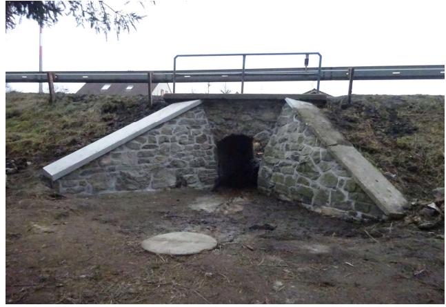
Dokončený propustek v KM 11,2148
