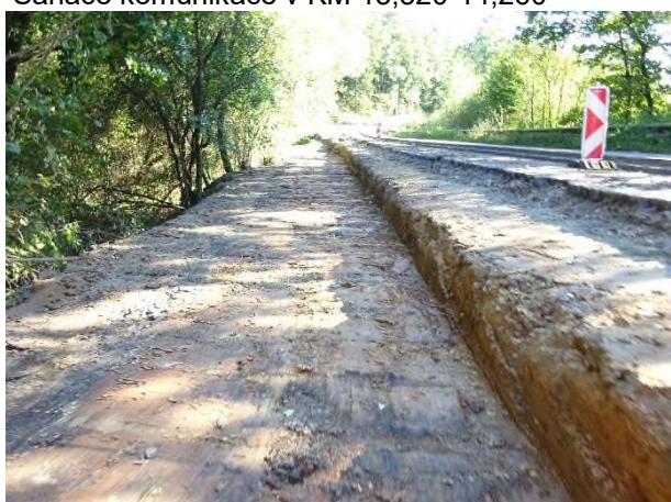
Sanace komunikace v KM 13,320-14,260
