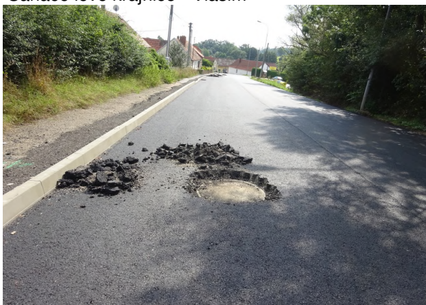
Příprava pro osazení IS do projektované výšky
