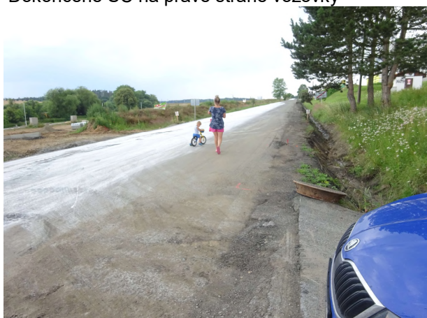
Ochrana penetračního nátěru před pokládkou ACP
