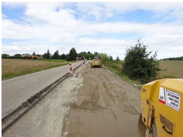
Pokládka SC v úseku KM 11,350 - 12,150
