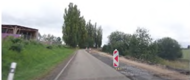
Sanace krajnice v úseku KM 11,350 - 12,150
