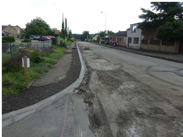
Dokončené obruby v Domašíně
