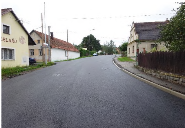
Dokončené SMA (finální vrstva) v obci Domašín
