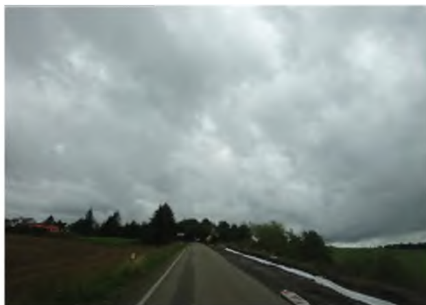
Sanace krajnice v úseku KM 11,350 - 12,150
