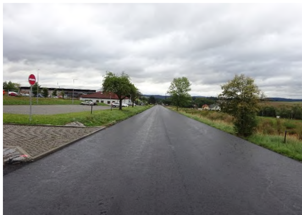
Dokončené ACO u obce Domašín - směr Domašín
