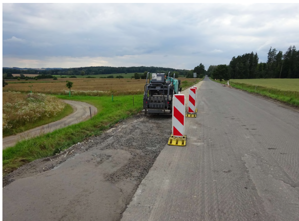
Dokončené SC na pravé straně vozovky
