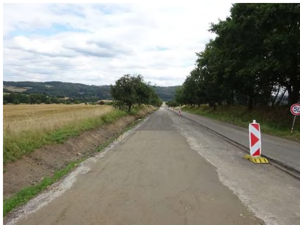
Dokončené SC v úseku KM 11,350 - 12,150
