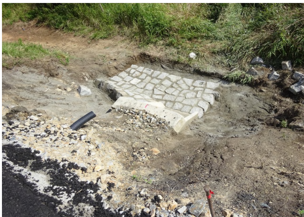
Provádění opevnění svahu propustku
