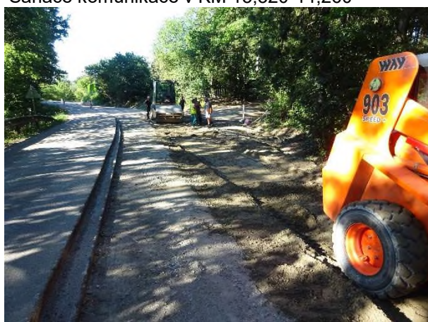
Pokládka SC v úseku KM 13,320-14,260
