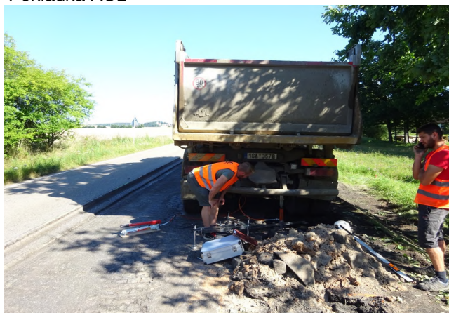
Statické zkoušky na krajnici
