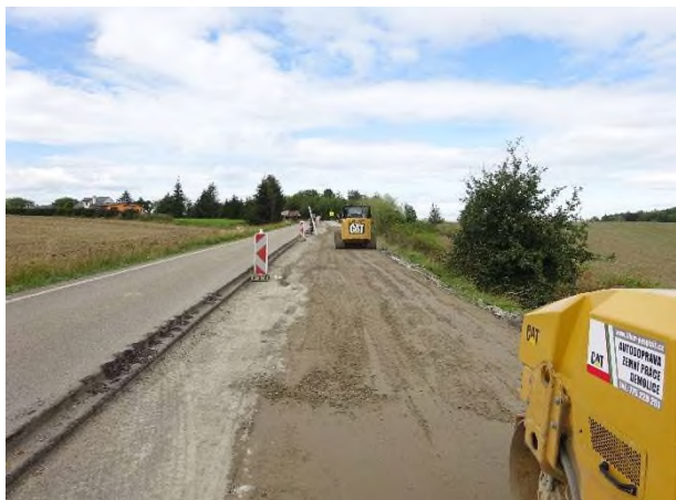
Pokládka SC v úseku KM 11,350 - 12,150
