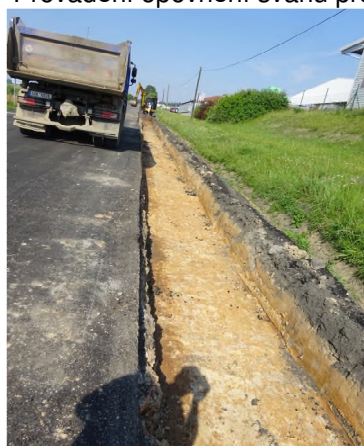
Sanace levé krajnice - Vlašim
