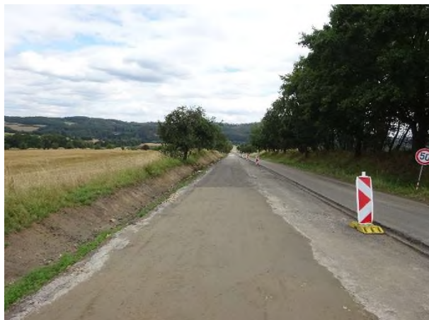
Dokončené SC v úseku KM 11,350 - 12,150
