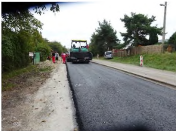
Pokládka ACL v KM 11,350 - 12,150
