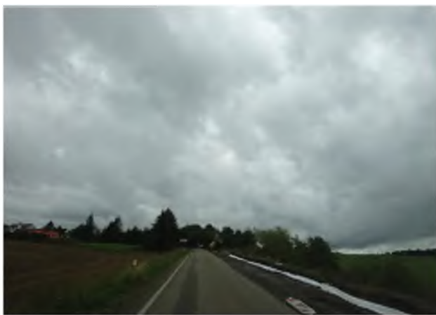
Sanace krajnice v úseku KM 11,350 - 12,150
