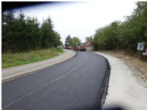
Položené ACL v KM 11,350 - 12,150
