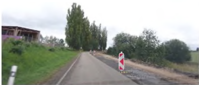
Sanace krajnice v úseku KM 11,350 - 12,150
