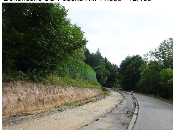
Sanace komunikace v KM 13,320-14,260
