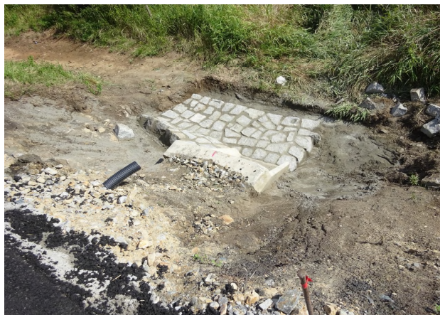
Provádění opevnění svahu propustku
