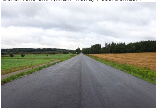
Položené ACO směr Bruk
