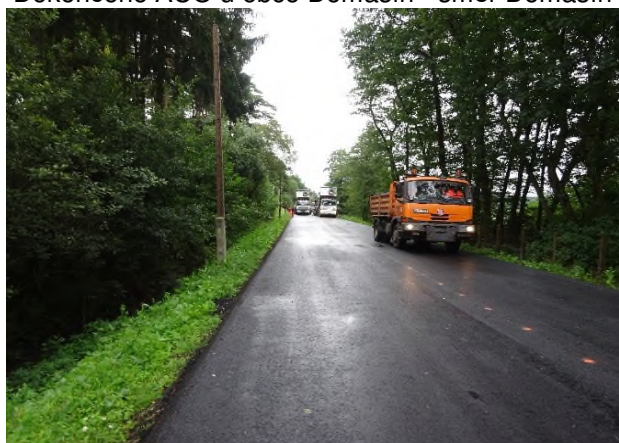
Pokládka ACO v obci Bruk
