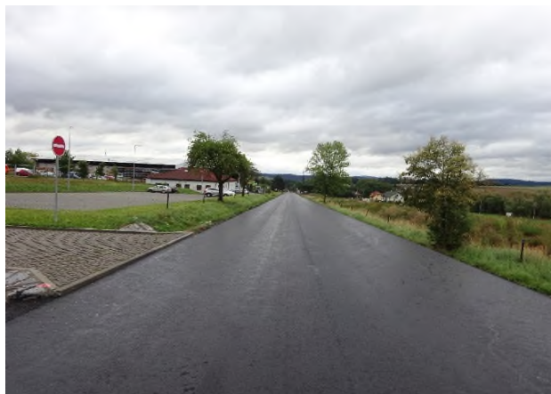
Dokončené ACO u obce Domašín - směr Domašín
