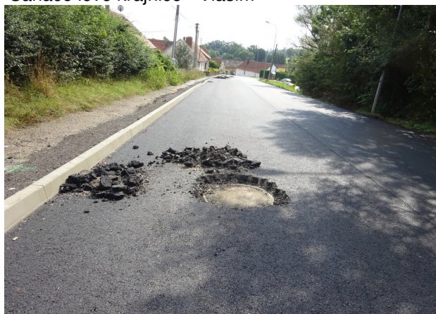
Příprava pro osazení IS do projektované výšky
