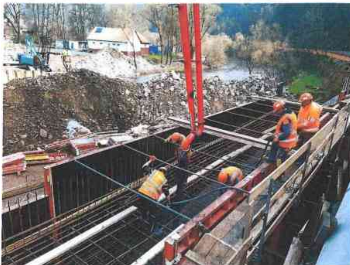
Obrázek 1 - SO 201/OP 4 – betonáž základu díku opěry
