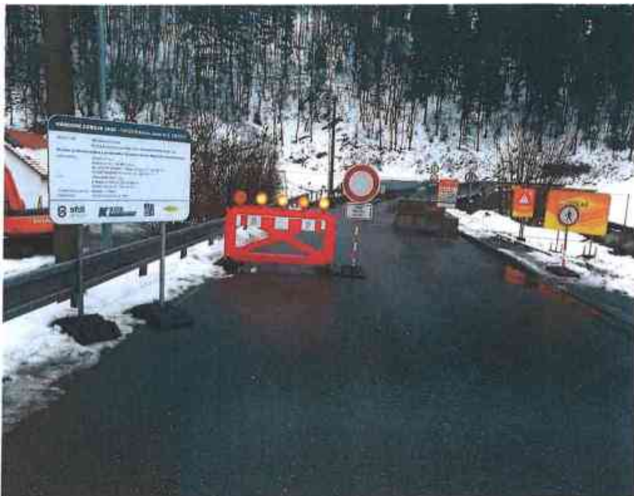
Obrázek 4 SO 201 most - osazené DIO včetně informačních tabulí a zákazových značek od 16.2.2021
