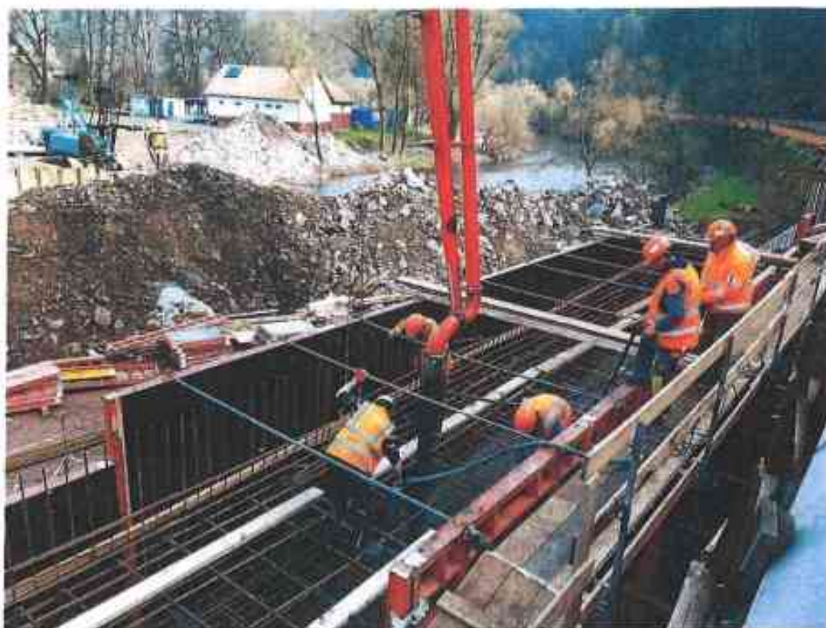
Obrázek 1 - SO 201/OP 4 – betonáž základu dířku opěry
