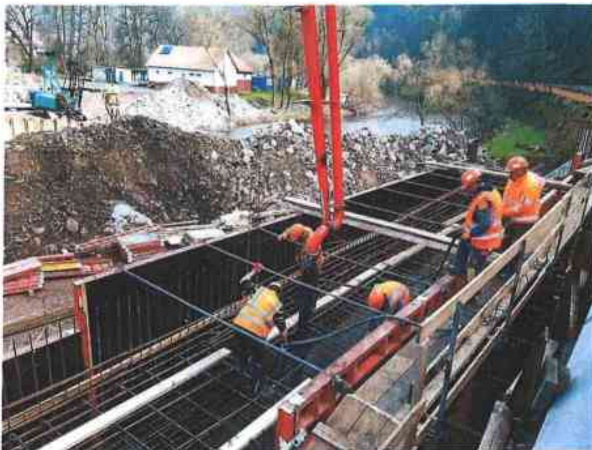
Obrázek 1 - SO 201/OP 4 – betonáž základu díku opěry
