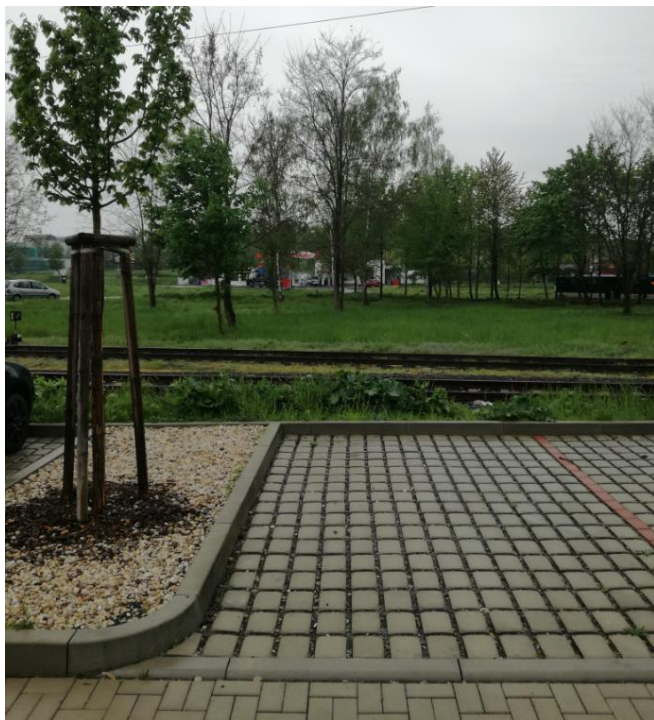
Obr. 1 povrch parkoviště z betonové dlažby s dilatačními spárami na parkovišti P+R v Milovicích
