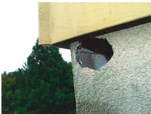
č. 17 Detail poškození KZS s hnízdíštěm roryse obecného, severní fasáda
