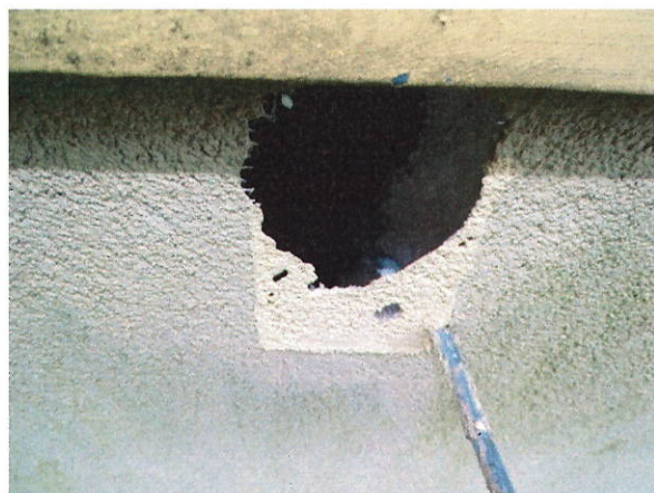
č. 18 – 23 Detaily poškození KZS
