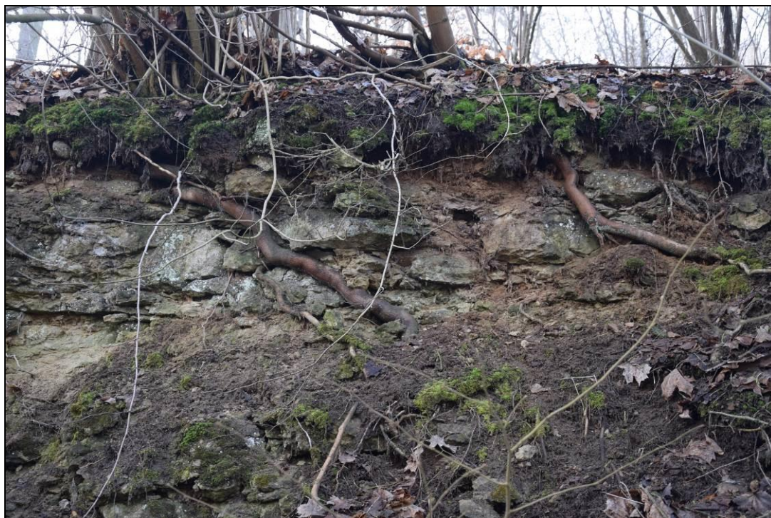
Foto 13 K nestabilitě líce skalní stěny přispívají i kořeny stromů penetrující podle diskontinuit do masivu. Po opadu nestabilní části dochází k obnažení kořenů, jak je patrné i z foto 13.
