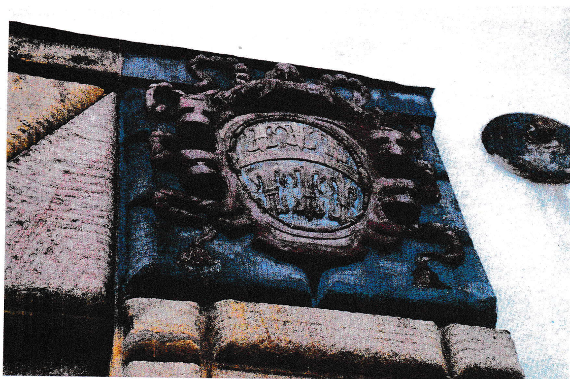
Malované erby na kameni nad vstupní bránou Zámku ve Smečně
