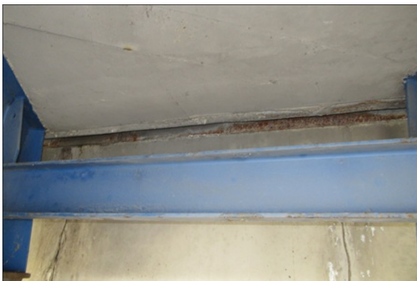
02 - Pohled na trhliny v závěrné zídce opěry OP5
