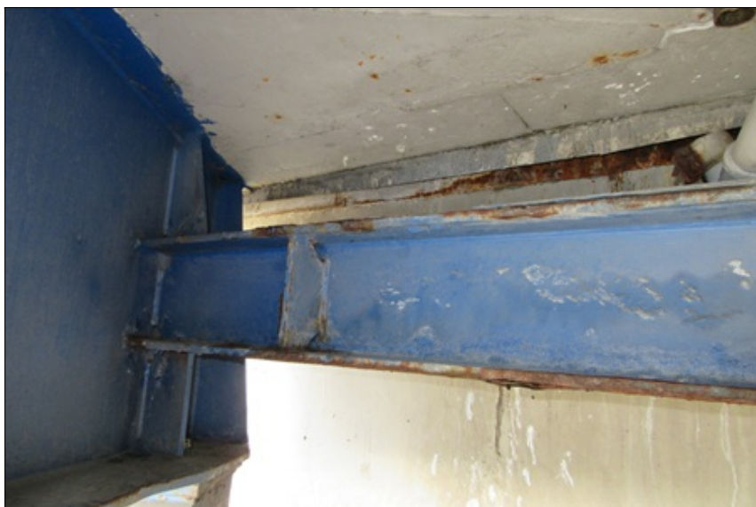
05 - Pohled na koncový příčník OP5, poruchy PKO, místy progresivní koroze základního materiálu
