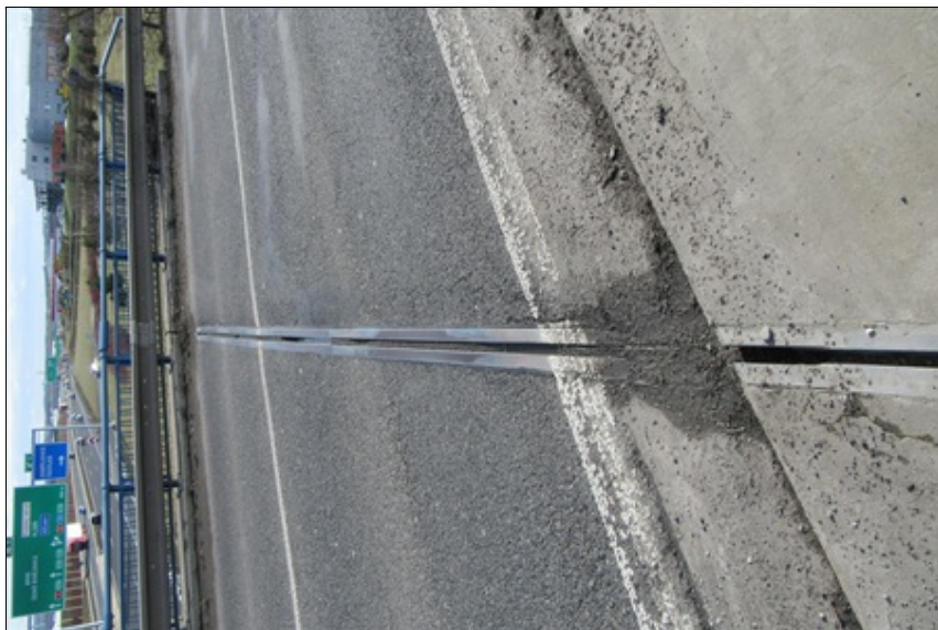
16 Pohled na MZ na OP1, nečistoty, trhliny ve vozovce
