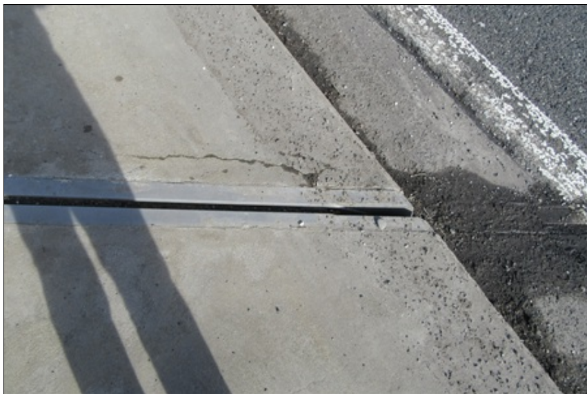
19 - Pohled na trhliny v chodníkové římse u MZ na OP1
