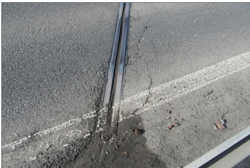
17 - Pohled na MZ u OP5, trhliny ve vozovce, výtluky, nečistoty
