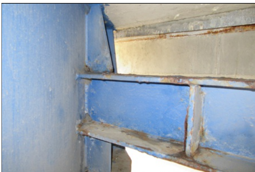
06 - Pohled na koncový příčník, nefunkční PKO, koroze
