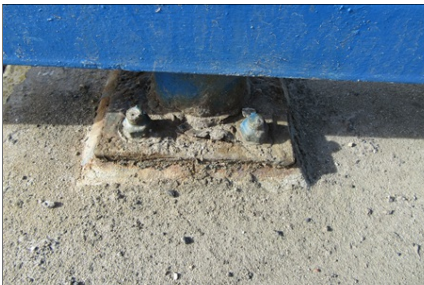
26 - Pohled na zkorodovanou patní desku sloupku zábradlí
