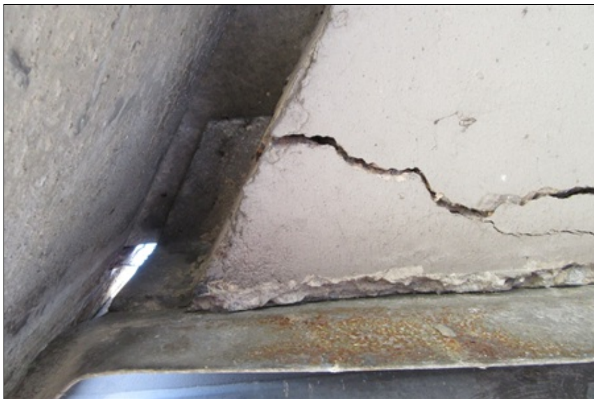
10 - Pohled na trhlinu ve spřahující desce v místě kotvení MZ na OP5
