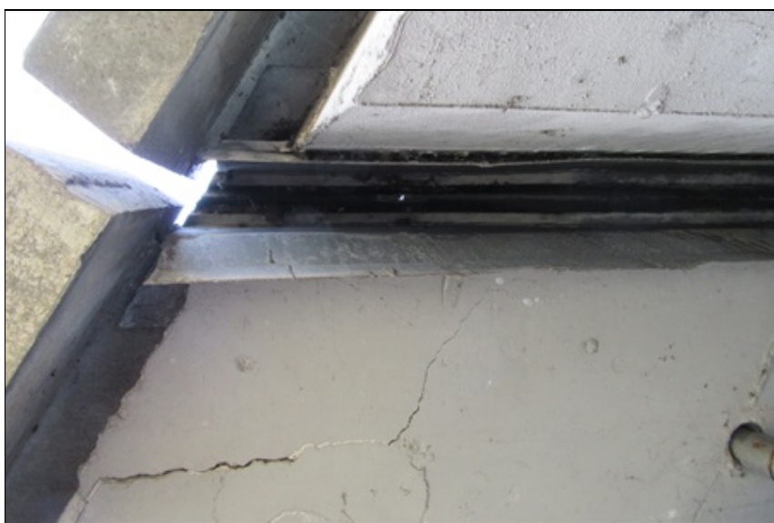
15 - Pohled na MZ na OP5, trhliny v desce a proražená těsnící guma MZ
