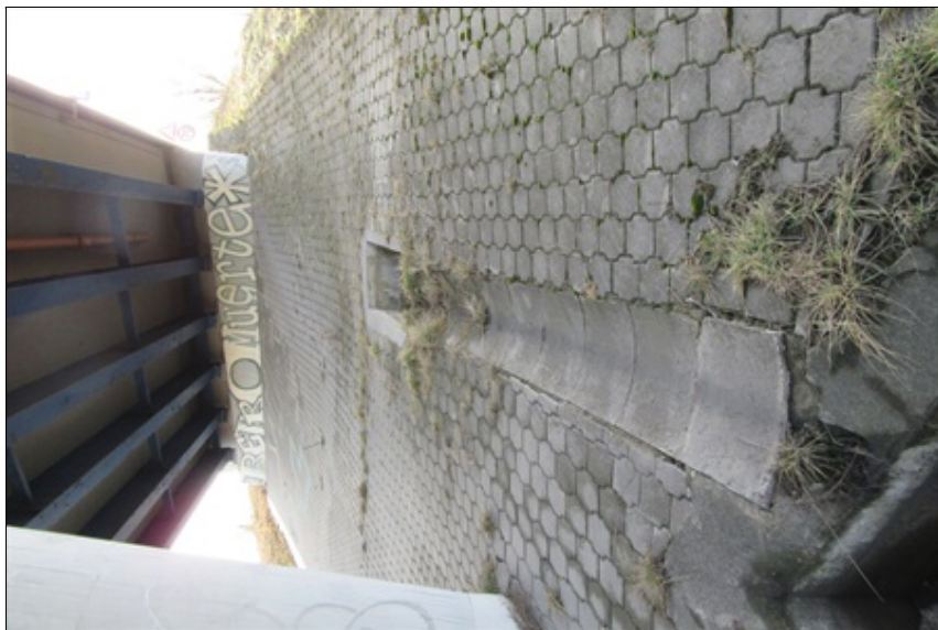
04 - Pohled na odláždění svahu u OP1, vegetace, prosednutí a zanesená vsakovací jímka a vývěřiště
