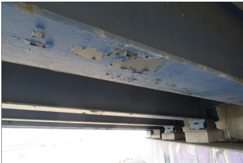
07 - Pohled na spodní pás hlavního nosníku, odlupující se vrstvy PKO, koroze
