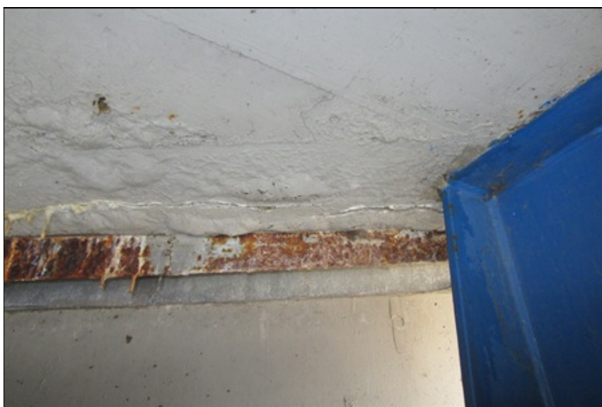
12 - Pohled na výluhy na spřahující desce na OP1
