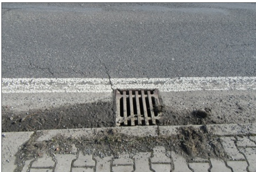
23 - Pohled na kanál v předpolí mostu, trhliny ve vozovce
