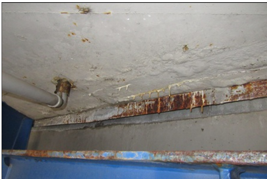
03 - Pohled na výluhy a krápníčky na desce mostovky na OP1
