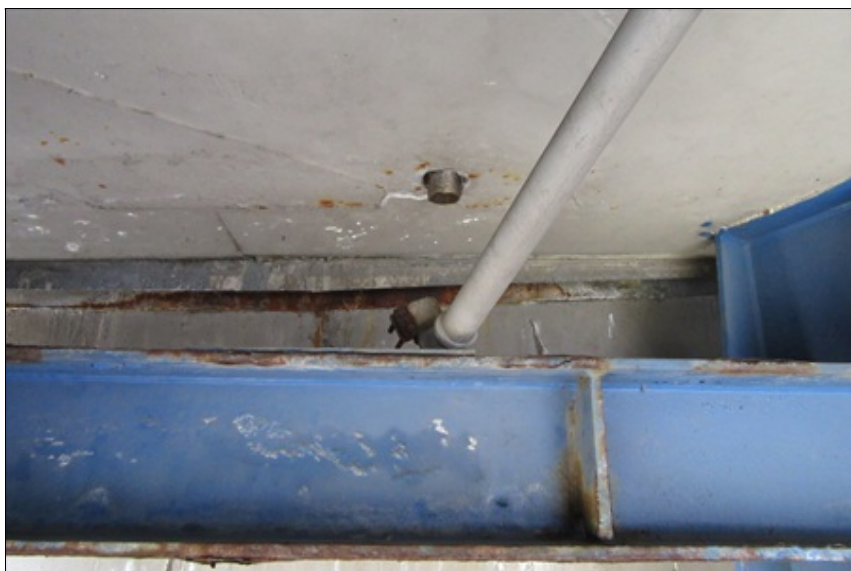
08 - Pohled na koncový příčník a nefunkční vývod odvodňovací trubičky, porušená PKO, koroze základního materiálu
