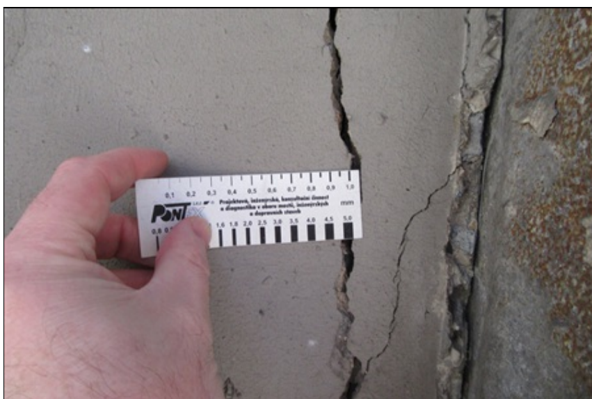
09 - Pohled na trhlinu ve spřahující desce v místě kotvení MZ na OP1
