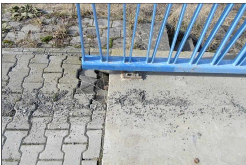
21 - Pohled na propadlou navazující dlažbu na konci křídla u OP1
