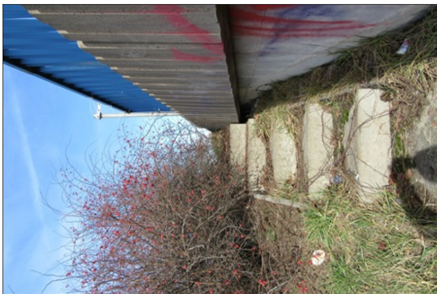
29 - Pohled na revizní schodiště, nečistoty, vegetace, zarostlý přístup
