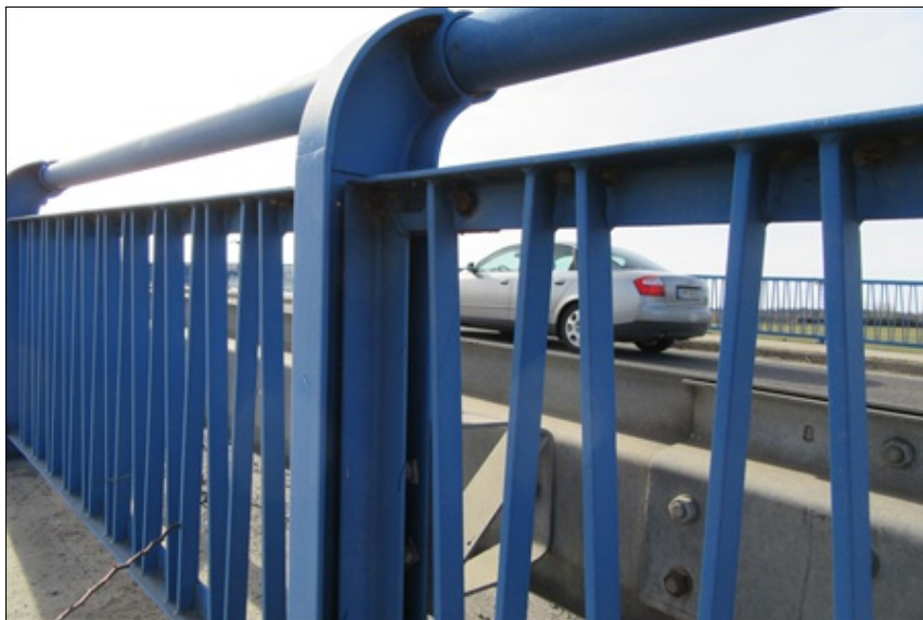
28 - Pohled na zkorodovaný spojovací materiál na svodidle
