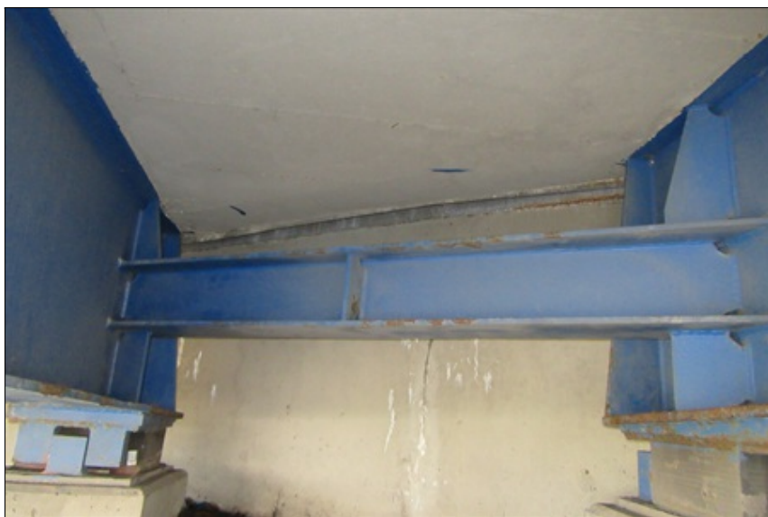
11 - Pohled na koncový příčník a ložiska na OP5, nefunkční PKO, koroze základního materiálu
