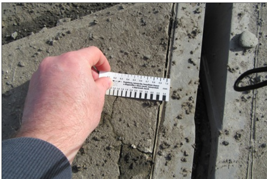
20 - Pohled na trhliny v chodníkové římse a mezeru s porušeným těsněním na styku MZ a beton římse
