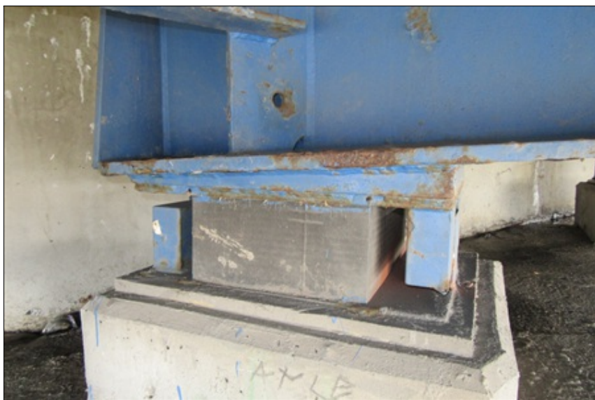
14 - Pohled na ložisko, nefunkční PKO, koroze základního materiálu
