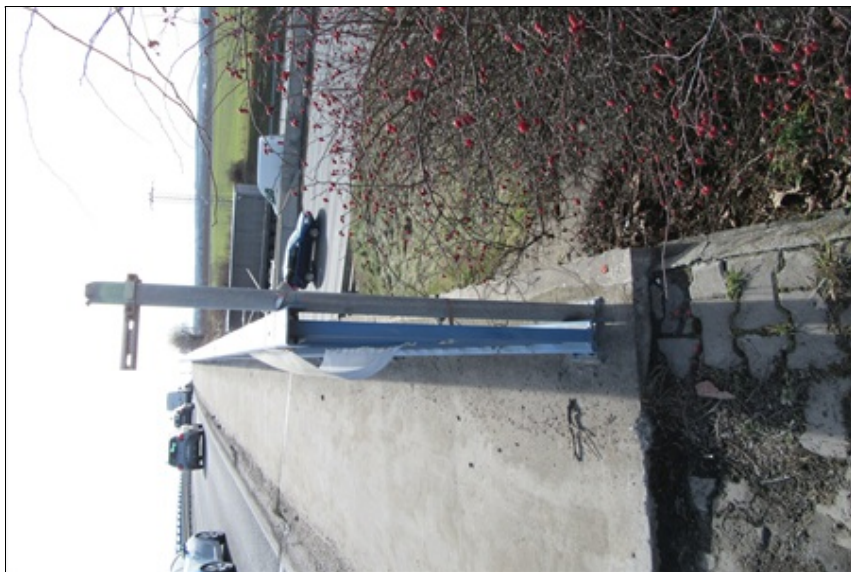
22 - Pohled na propadlou dlažbu na konci křídla u OP5, chybějící značka s evidenčním číslem mostu
