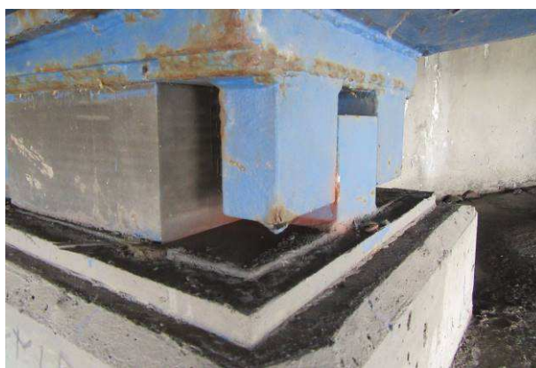
Pohled na konstrukci ložiska s výskytem prorezavění na hranách a plošnou korozi
