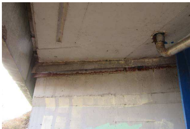
Pohled na bednicí plech s korozními produkty
