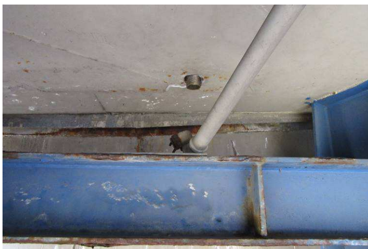
Pohled na nefunkční odvodnění u O5
