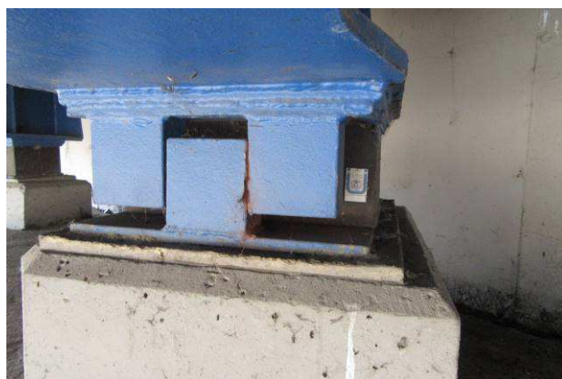
Pohled na nečistoty ložiska
