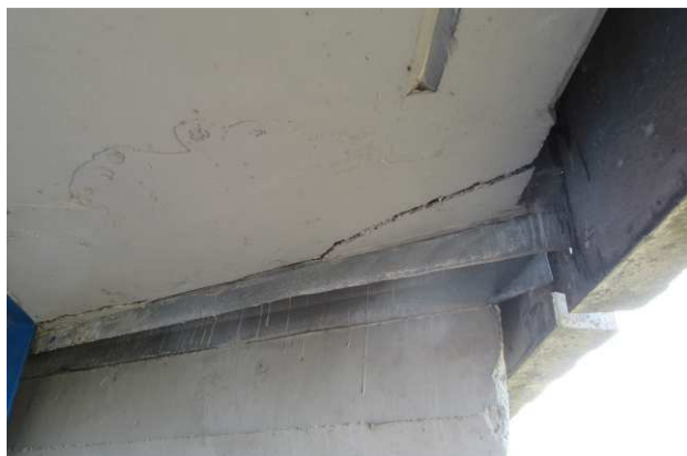
Pohled na trhlinu u opěry O1 pod chodníkovou částí a oddělenou část betonu
