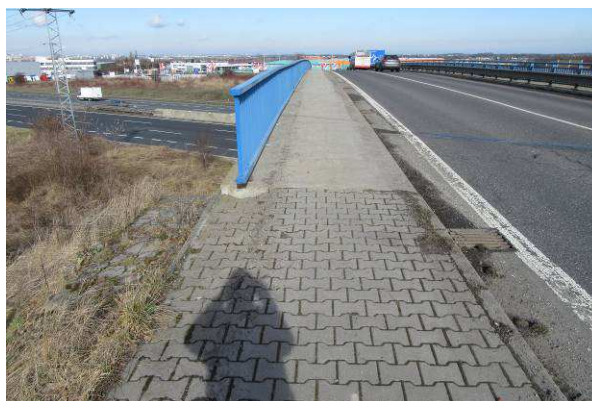
Pohled na vozovku v předpolí a poškození okolo odvodňovače
