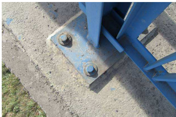
Pohled na podkorodované OPS patní desky svodidla
