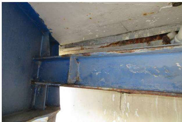
Pohled na koncový příčník s počínajícími korozními úbytky a korozi po vrstvách.
