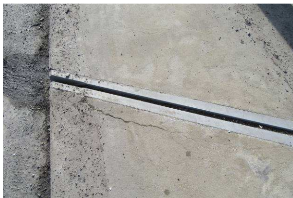
Pohled na trhlinu v chodníkové části u OP1
