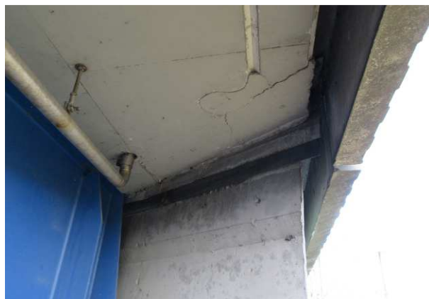
Pohled na trhlinu na O5 pod římsovou částí
