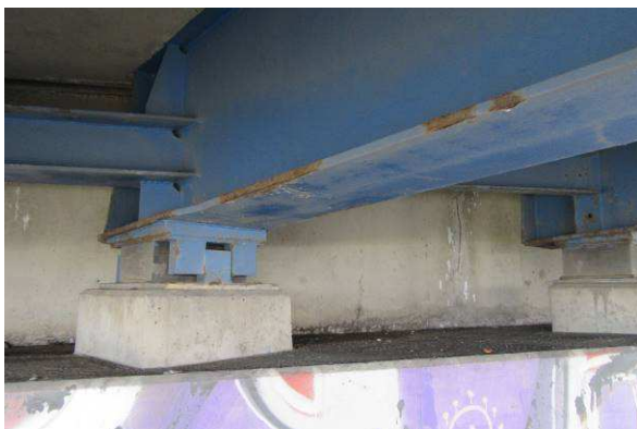
Pohled na dolní pásnici hlavního nosníku v oblasti opěr, prorezavění na hranách, plošná koroze
