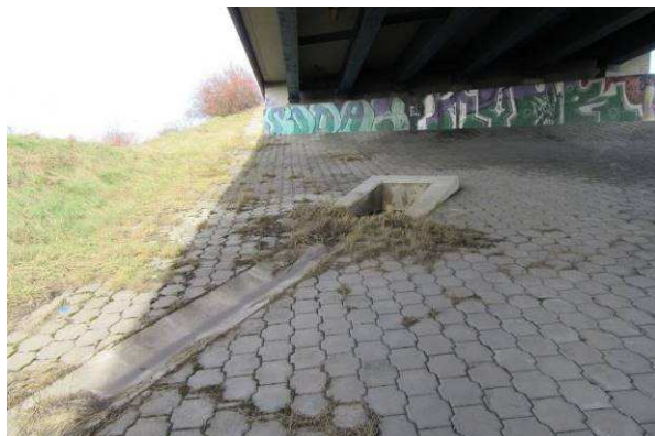
Pohled na skluz a spadovou jímku v odláždění u OP5
