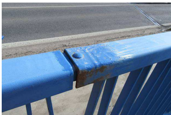
Pohled na podkorodovaný OPS madla zábradlí
