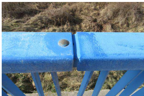
Pohled na spoj. mat. madla a prosvítající mezivrstvy nátěru.
