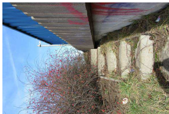
Pohled na schodiště u OP5, zamezení přístupu keřem, nečistoty, vegetace, mechy
