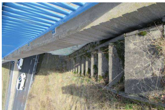
Pohled na schodiště u OP1, nečistoty, vegetace, mechy
