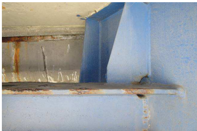
Pohled na horní pás koncového příčníku a počínající korozní úbytky základního materiálu
