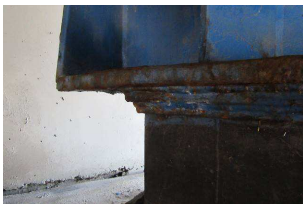
Pohled na uložení hl. nosníku s významnými korozními projevy.
