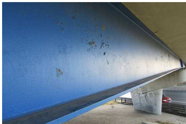
Pohled na stěnu hla. nosníku, projevy praskání nátěru až na základní materiál
