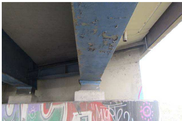
Pohled na spodní pásnici hl. nosníku, projevy praskání a odlupování nátěrů
