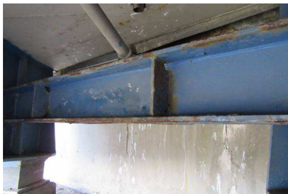
Pohled na koncový příčník, prorezavění na hranách, plošná koroze spodního povrchu pásnic
