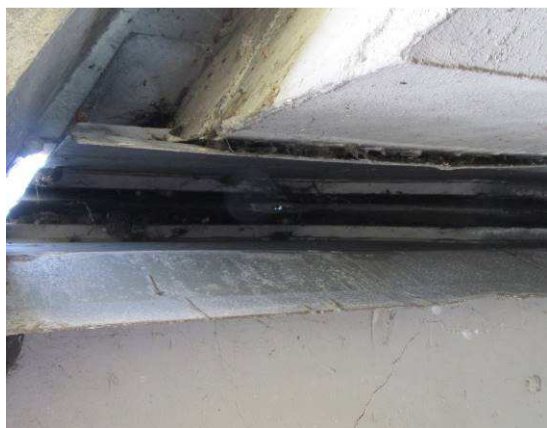
Pohled na MZ u OP5 v římsové části s prosvitujícím proraženým otvorem v gumě
