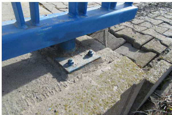
Pohled na patní desku zábradlí s podkorodovaným OPS
