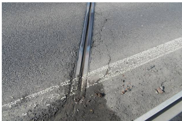
Pohled na MZ u OP5, trhliny ve vozovce, usazování nečistot
