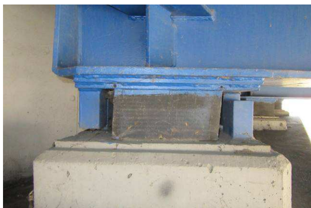
Pohled na nečistoty na ložisku
