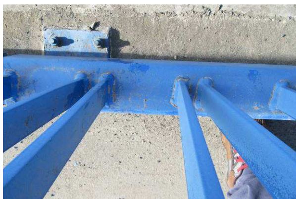
Pohled na odlupující se nátěry na spodním páso výplní
