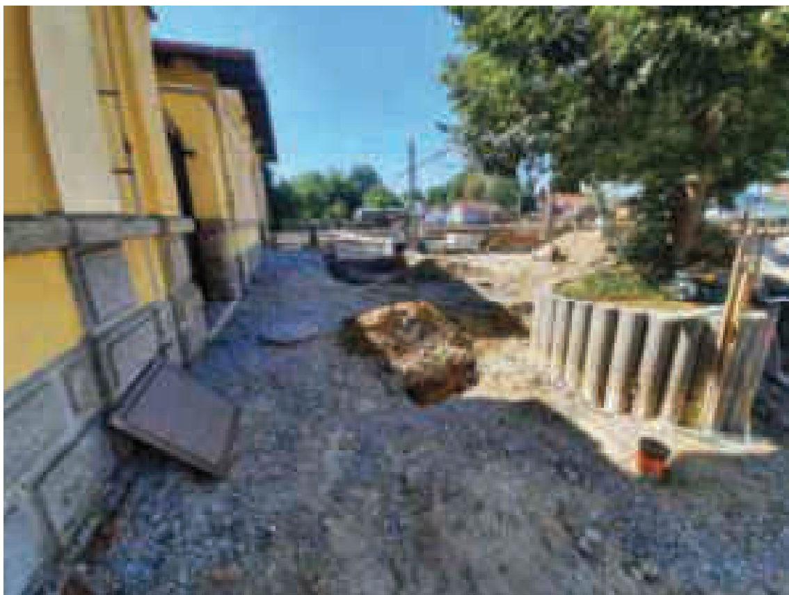
Instalace kamenných palisád 9.9.2020
