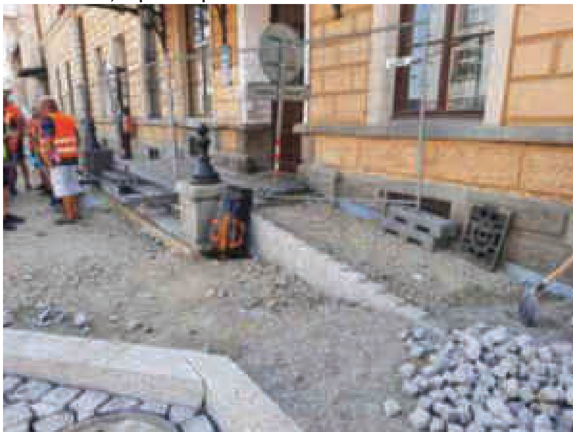
Hotová rampa podle zadávací projektové dokumentace při kontrolním dnu 14.9.2020
