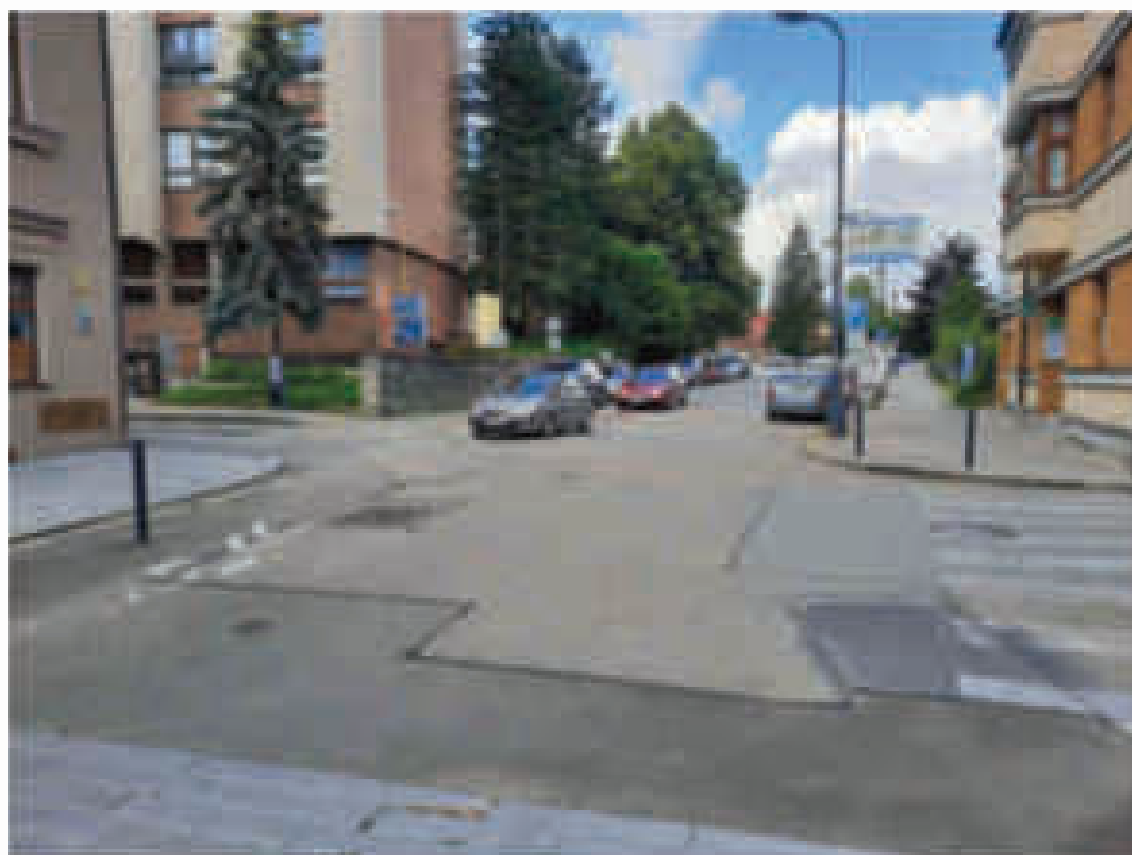
Sloupy veřejného osvětlení před zahájením prací
