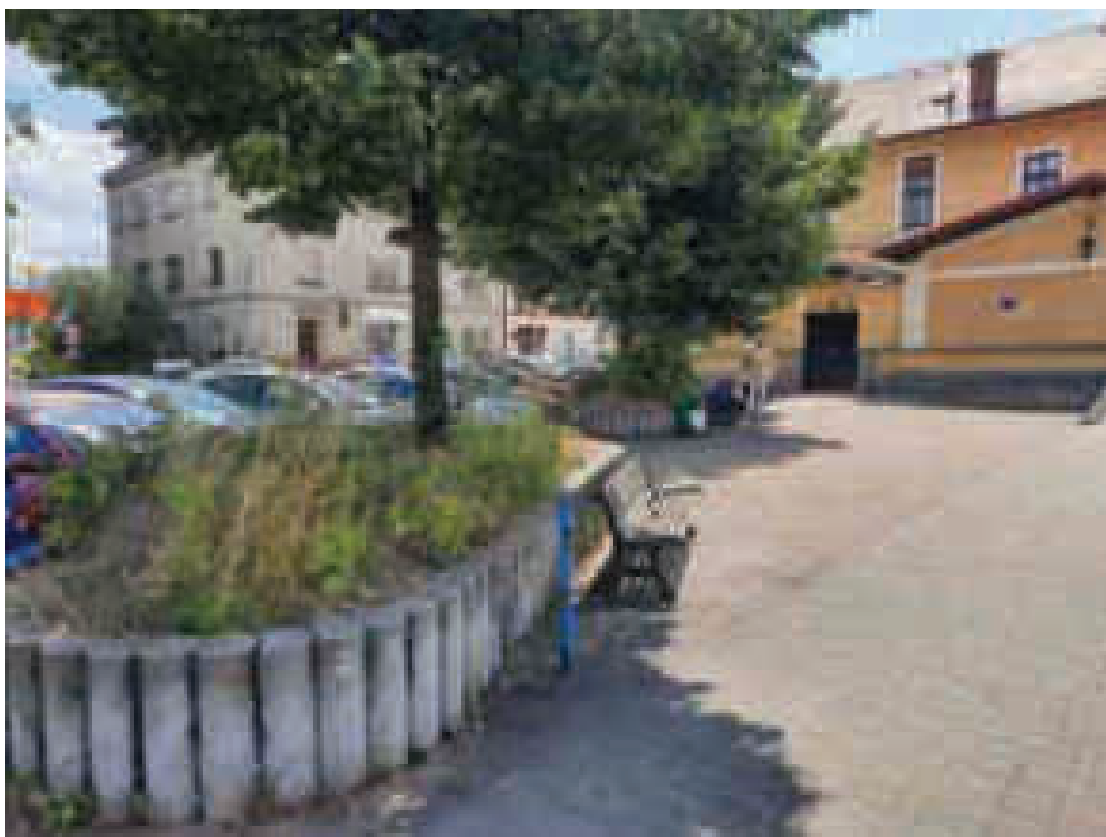
Stav před zahájením stavby 23.6.2020
