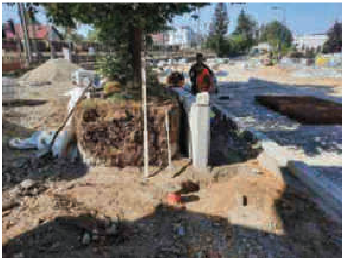
Instalace kamenných palisád 15.9.2020
