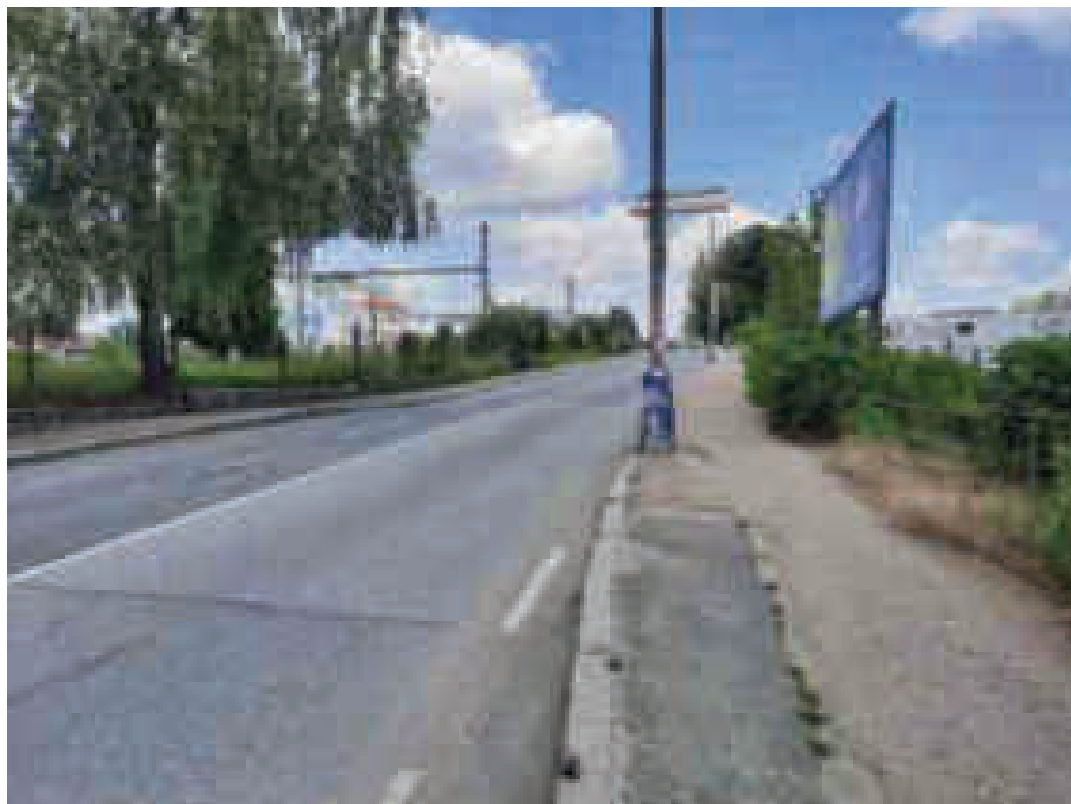
Sloupy veřejného osvětlení před zahájením prací
