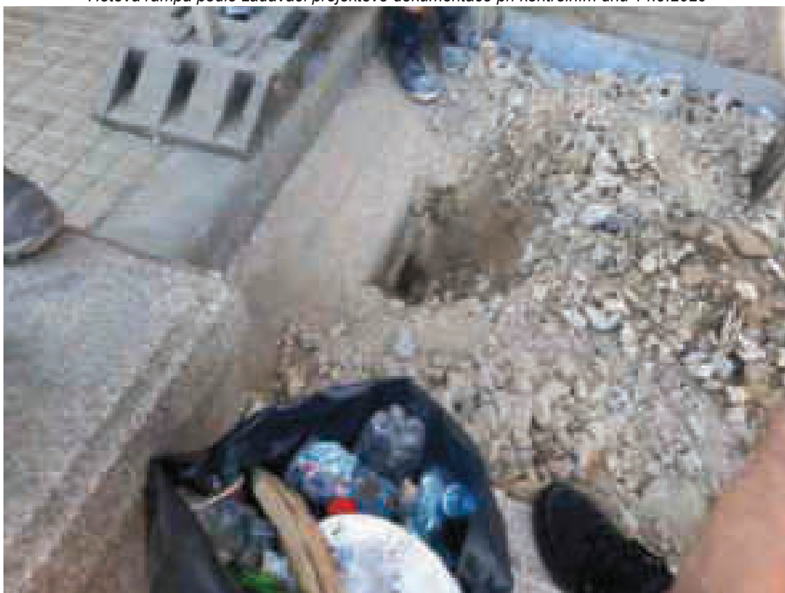
Sonda při kontrolním dnu 14.9.2020, prokazující zachování původních schodů
