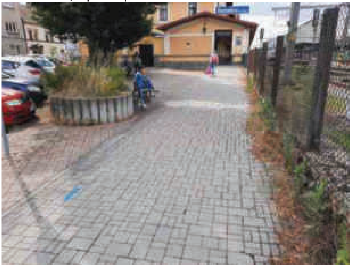
Stav před zahájením stavby 17.7.2020
