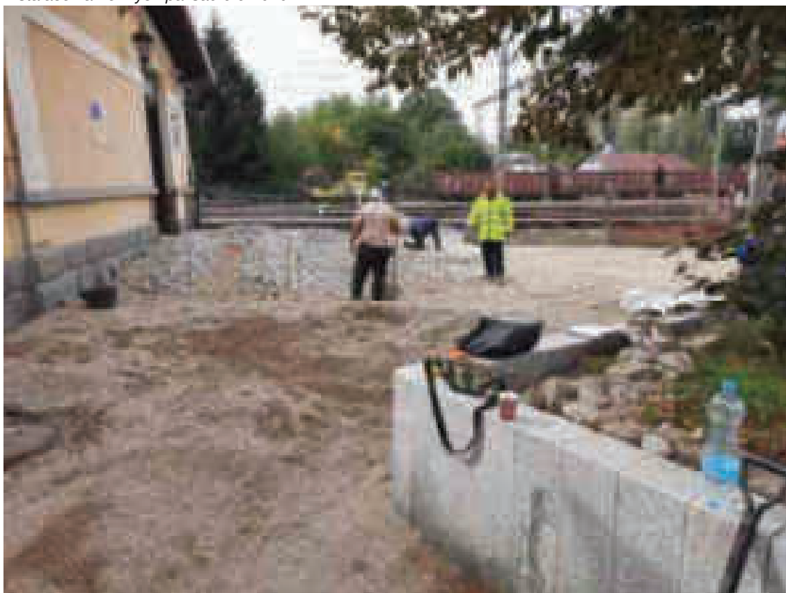
Montáž dlažeb na rampě pro handicapované na pozemku SŽ 8.10.2020
