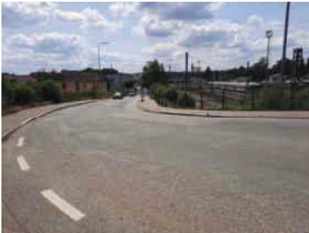
Sloupy veřejného osvětlení před zahájením prací
