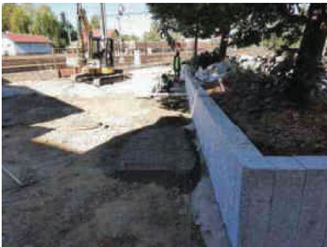
Hotové kamenné palisády 18.9.2020
