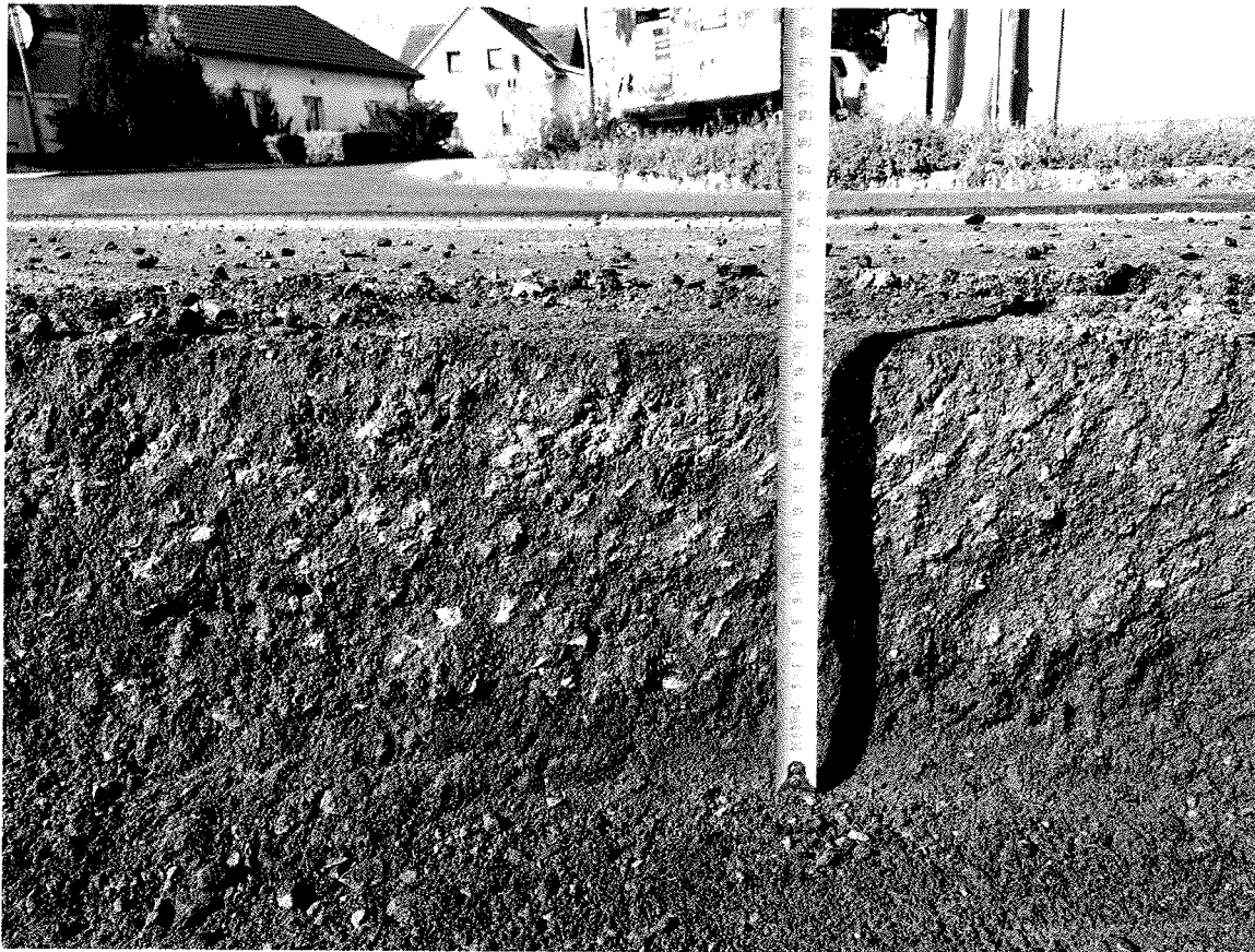
Tloušťka frézování asphaltových vrstev SO 001.1 a 2
