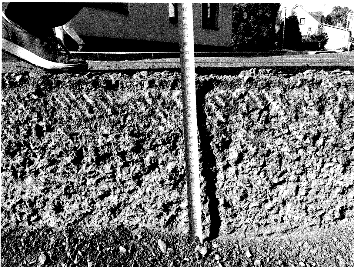
Tloušťka frézování asphaltových vrstev SO 001.1 a 2
