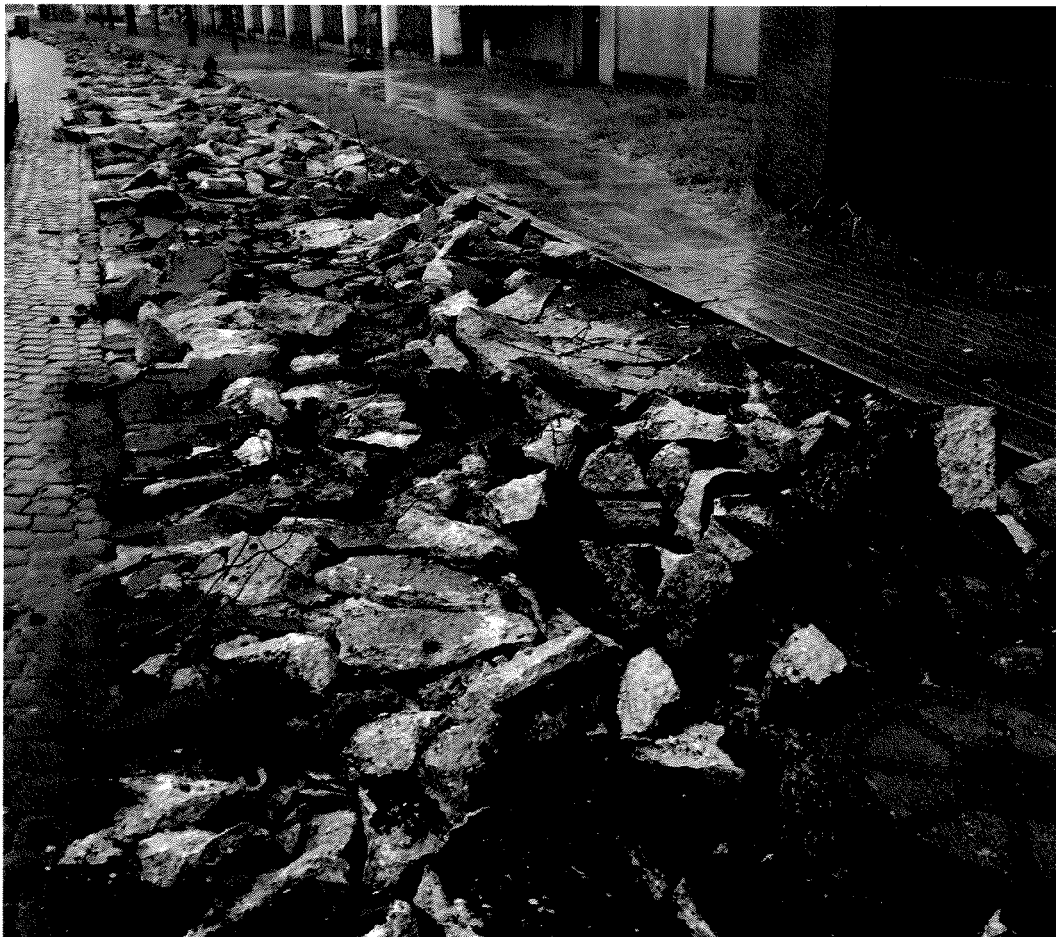
Vybouraná vrstva ŽB konstrukce SO 001.1 a 2
