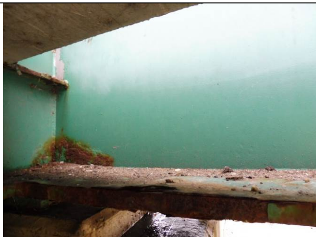
Koroze spodní pásnice hl. nosníku.
