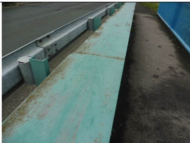
Koroze horní pásnice nosníku NK.
