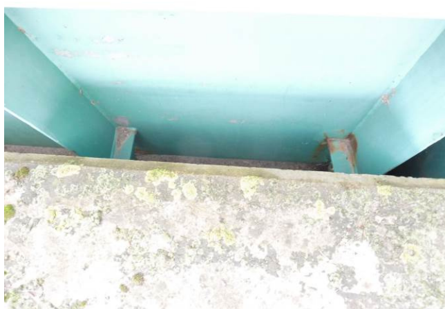
Koroze příčníků vedle římasy.
