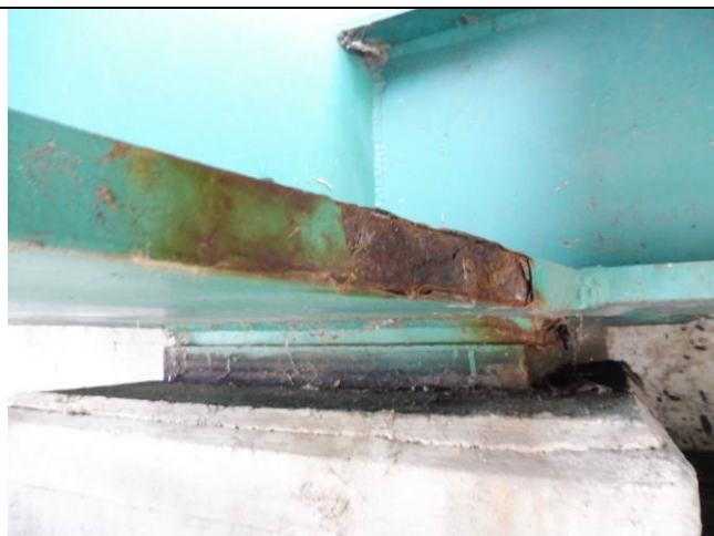
Koroze spodní pásnice nosníku NK.
