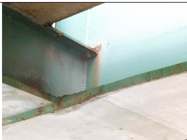
Koroze příčnicku a spodní pásnice hl. nosníku.
