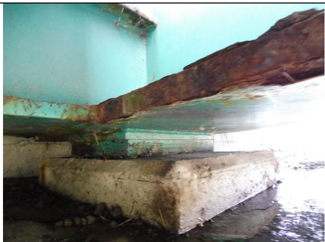
Koroze spodní pásnice hl. nosníku.
