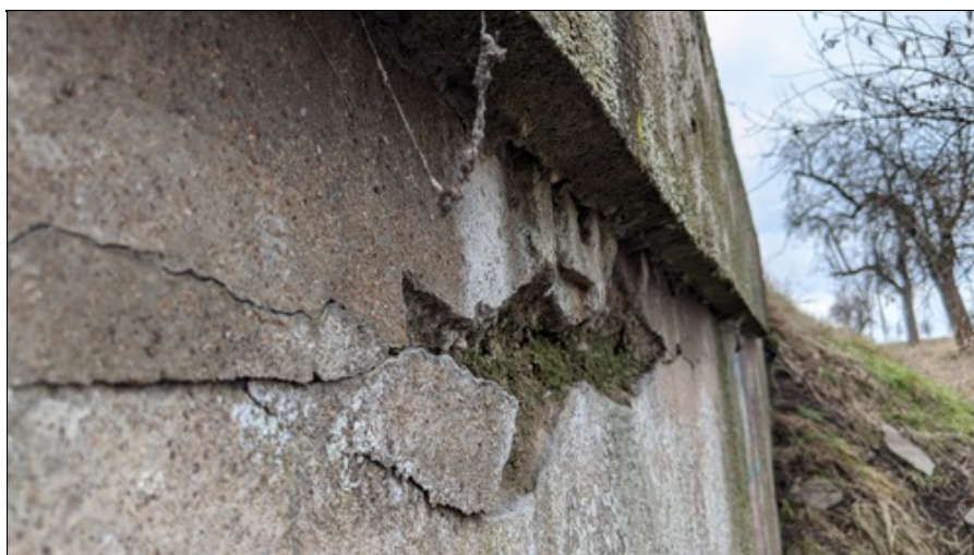
Degradovaný vnější líc pravé poprsní zdi
