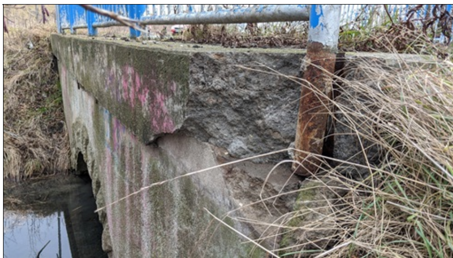
Vylomená část římsy nad OP2 vpravo.
