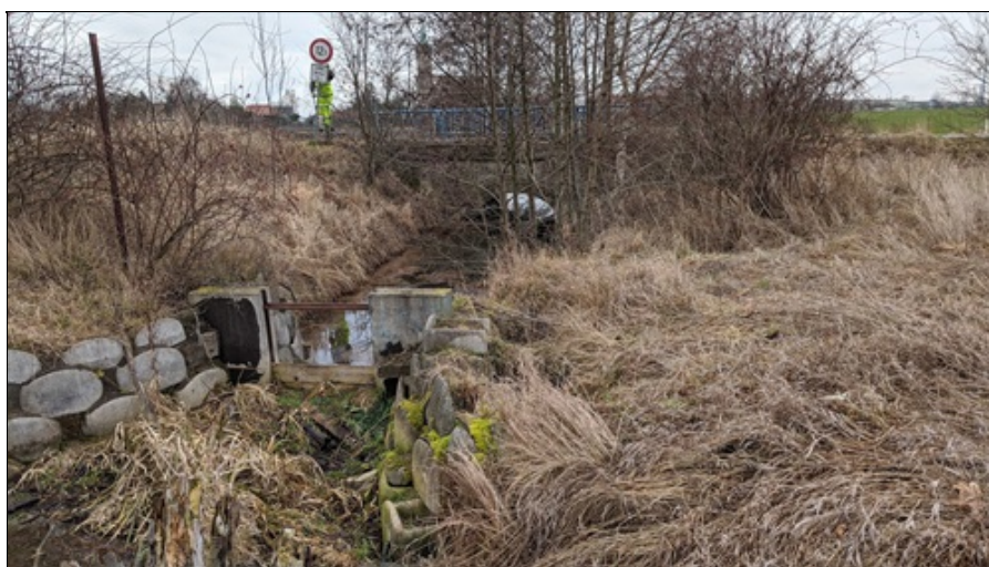
Detail rozpadajícího se Vodního díla vpravo od mostu.
