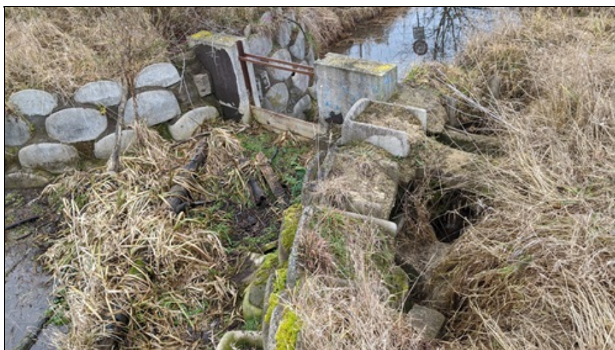
Podemleté opevnění "vodního díla" nad stavidlem.
