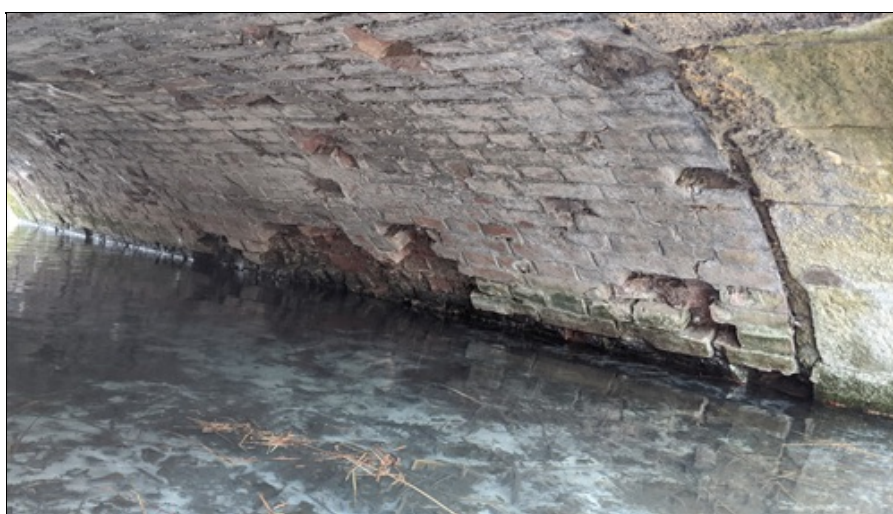
Pata klenby na OP2 - rozpadající se cihelné zdivo
