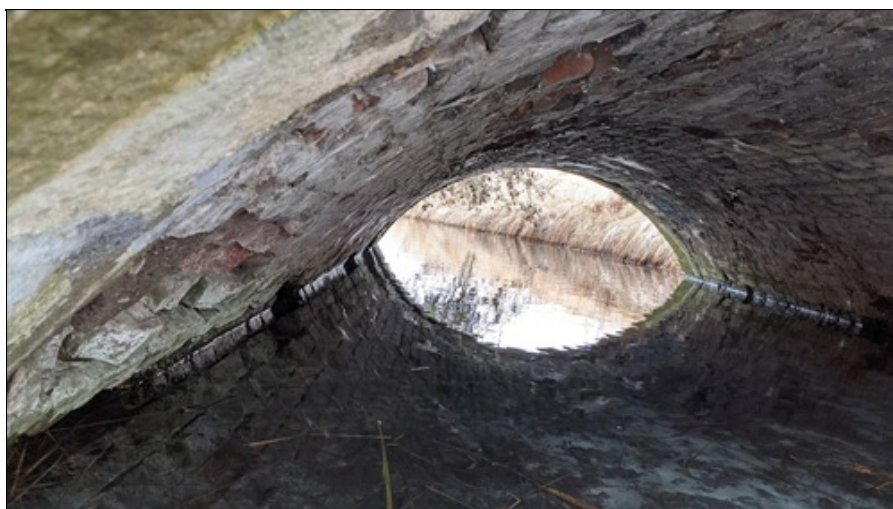
Rozpadající se cihelné zdivo klenby v celé její ploše.
