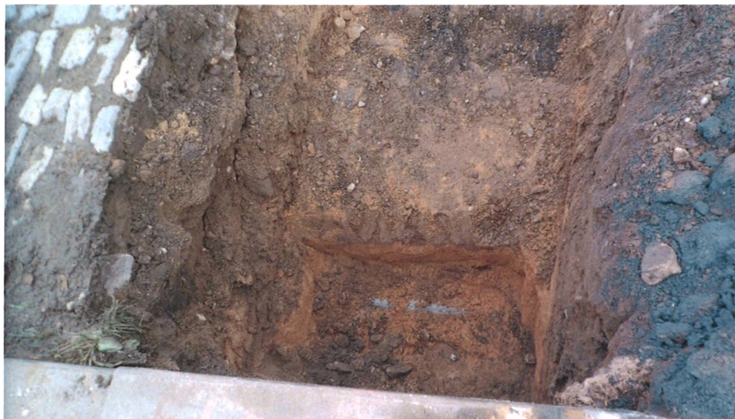
Kopaná sonda pro zjištění hloubky inženýrských sítí v prostoru budoucího autobusového zálivu
