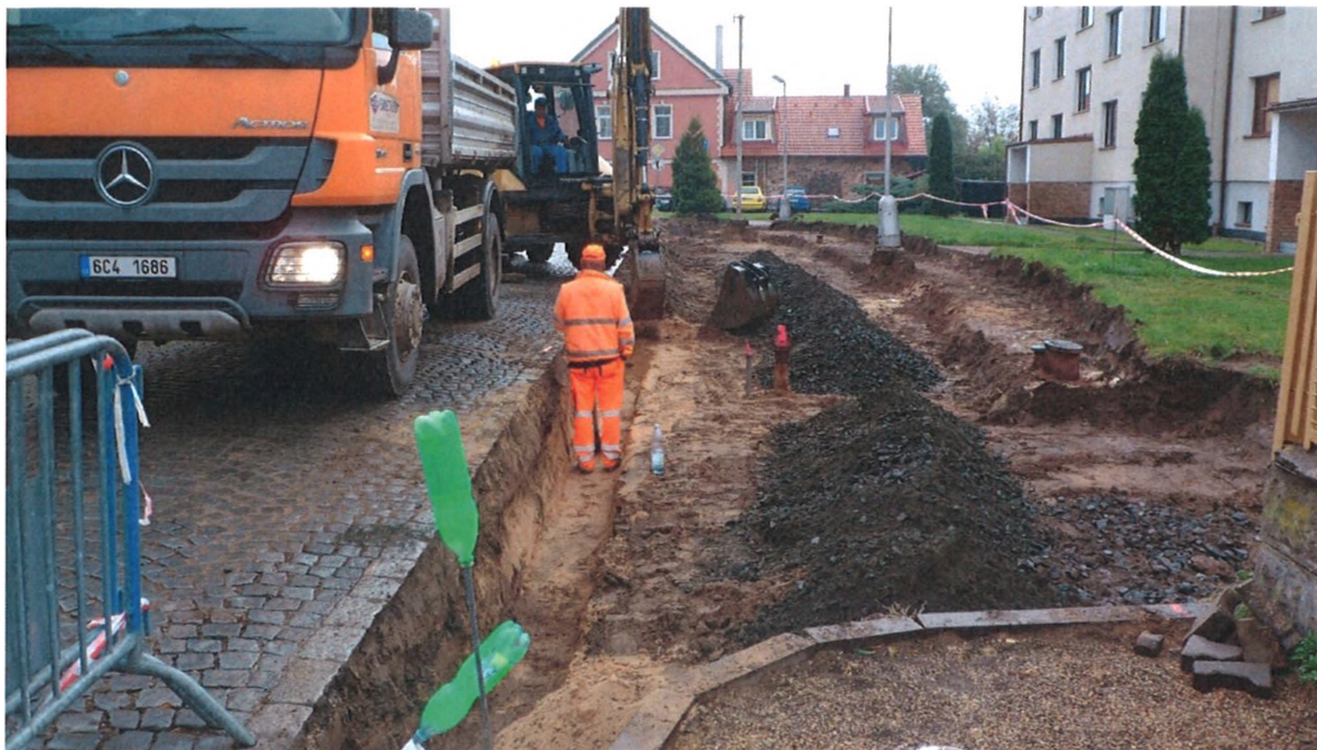
Osazení drenážního travivodu pro odvodnění zemní pláně zálivu
