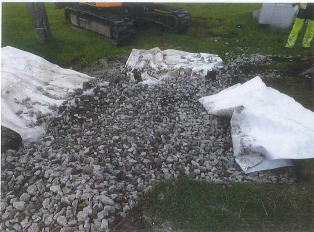
Dílčí změna č. 2: Zřízení vsakovací jámky – obr. 1
