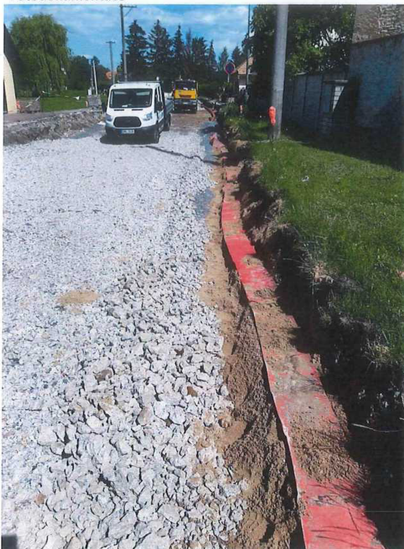
Dílčí změna č. 4: Přesunutí vedení VO – obr. 3
