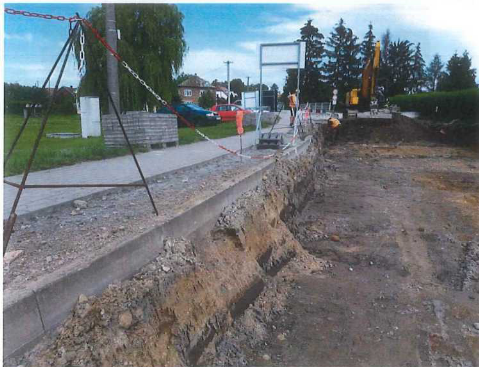
Dílčí změna č. 5: Vybourání a osazení silničních obrub – obr. 1
