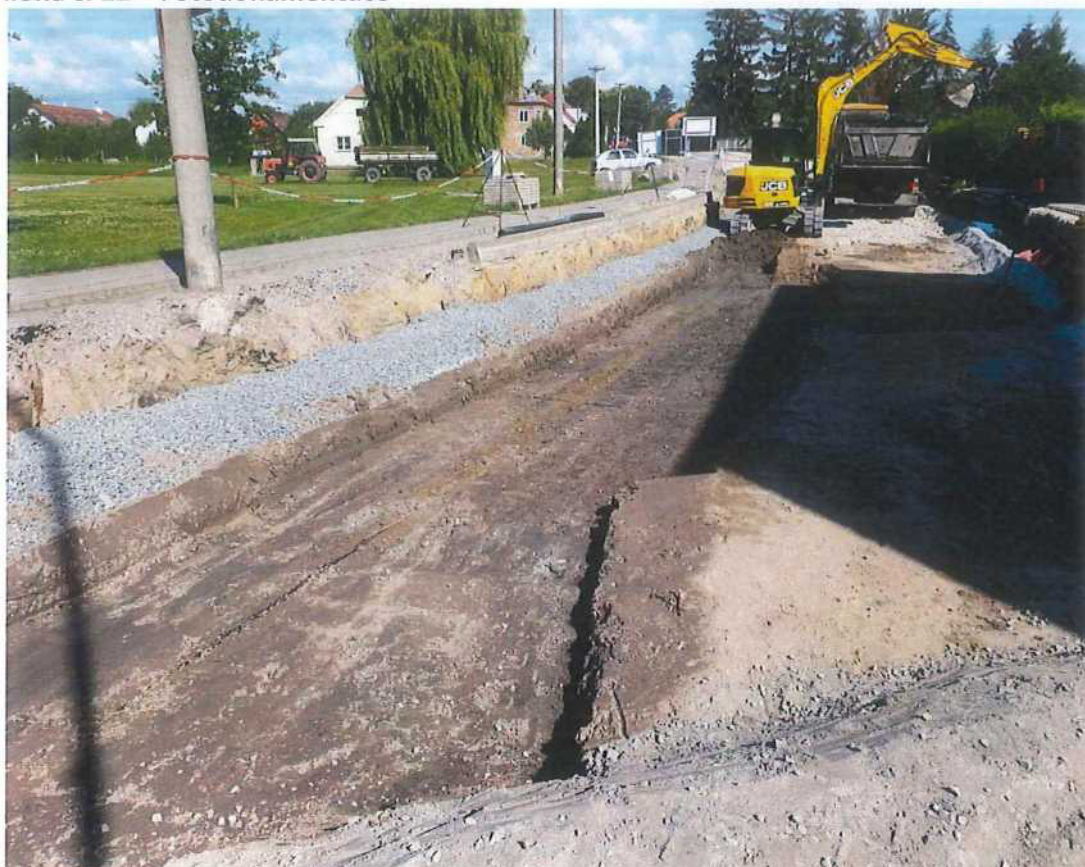
Dílčí změna č. 1: Lokální sanace parapláně – obr. 3
