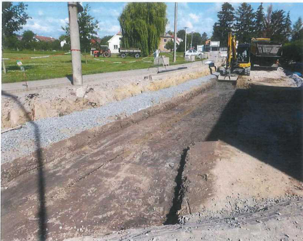
Dílčí změna č. 1: Lokální sanace parapláně – obr. 1
