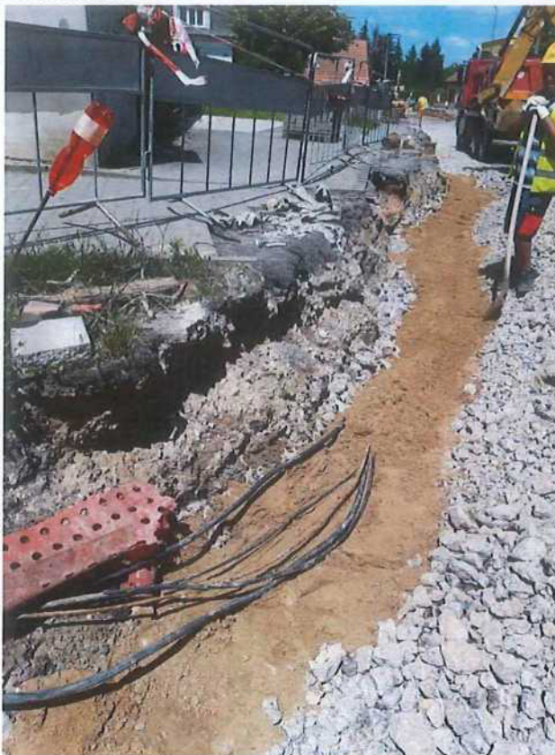
Dílčí změna č. 4: Přesunutí vedení VO – obr. 1
