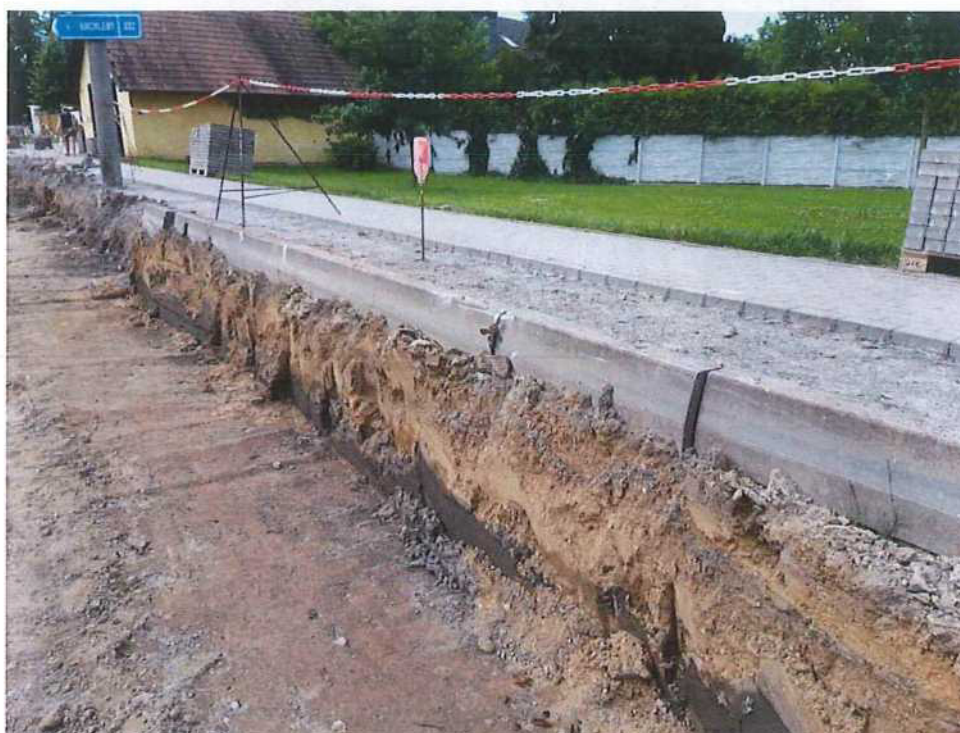
Dílčí změna č. 5: Vybourání a osazení silničních obrub – obr. 2
