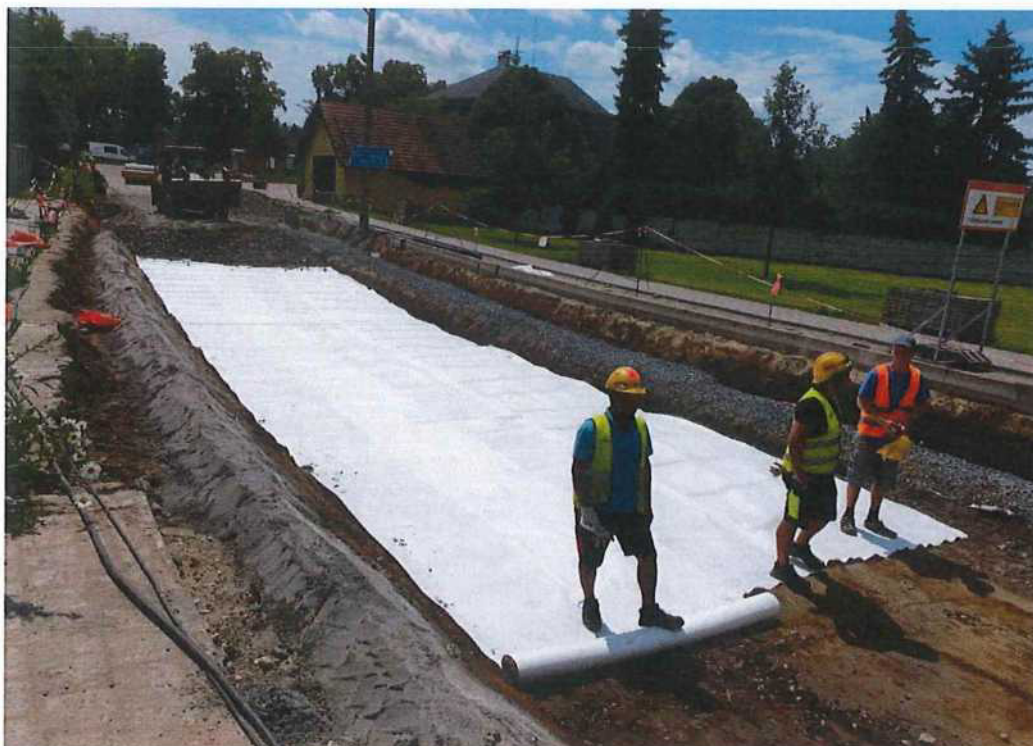
Dílčí změna č. 1: Lokální sanace parapláně – obr. 2
