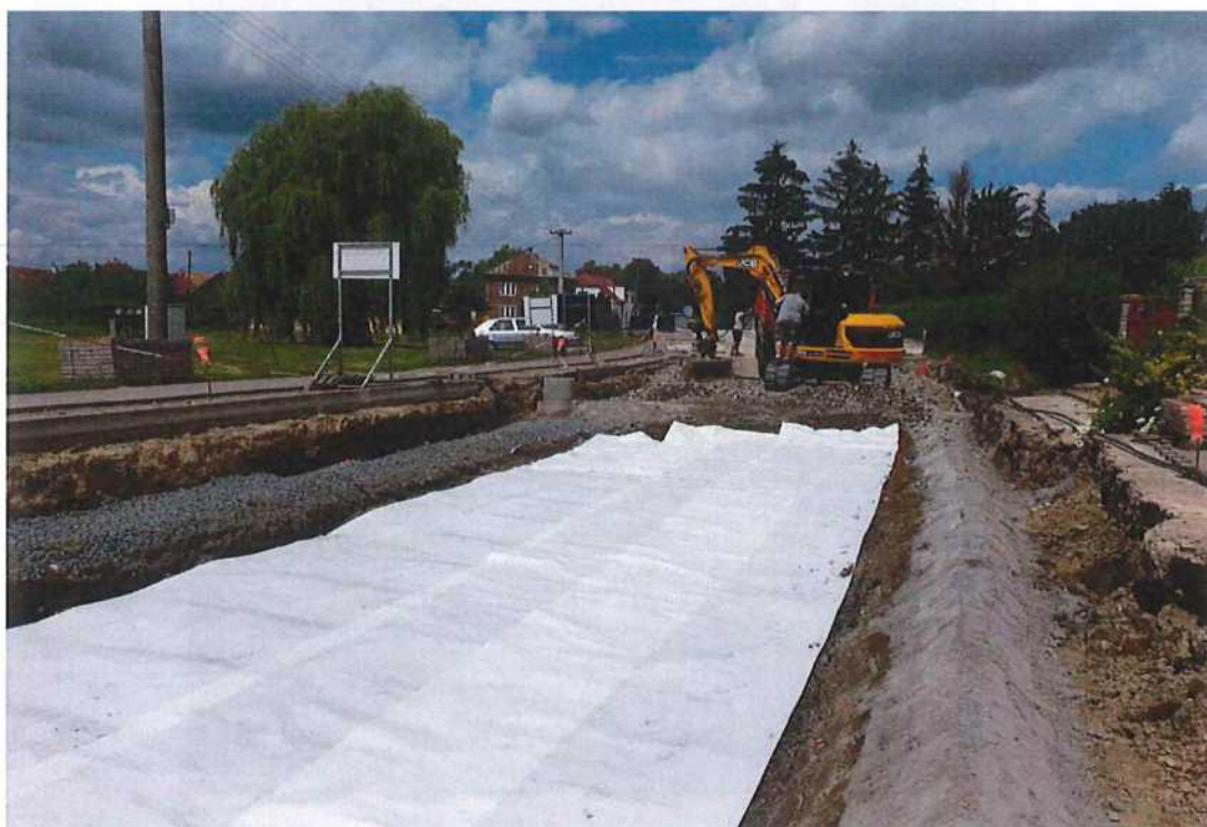
Dílčí změna č. 1: Lokální sanace parapláně – obr. 4
