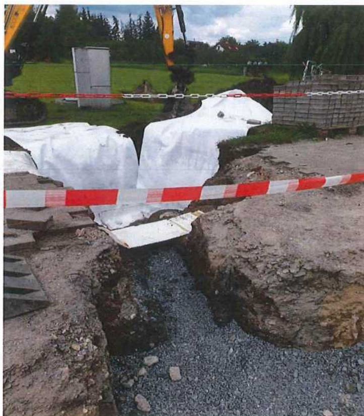
Dílčí změna č. 2: Zřízení vsakovací jámky – obr. 2
