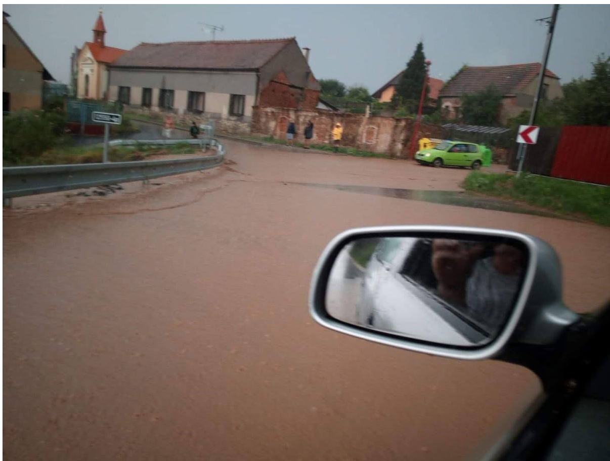
Zaplavená vozovka v oblasti propustku
