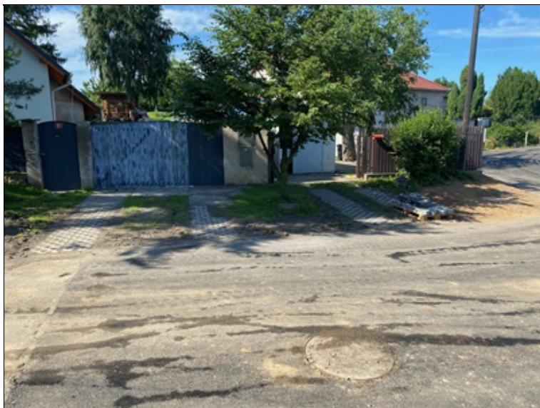
Zpevněné vjezdy k soukromým pozemkům (zatravnovací tvárnice)
