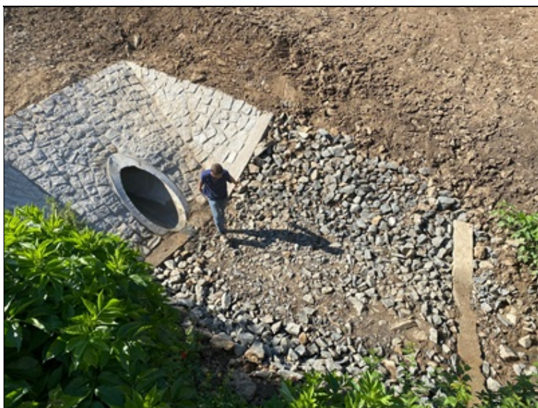
Betonové prahy v korytě na výtoku a zpevnění koryta kamenným záhozem
