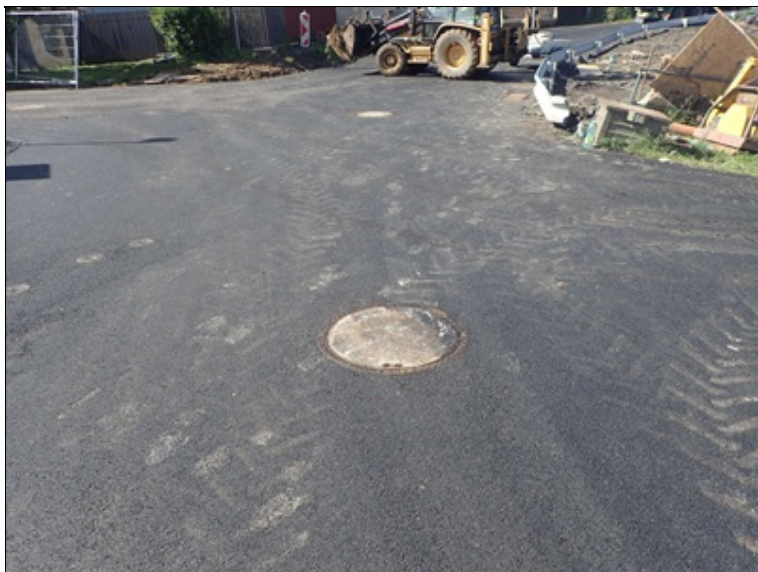
Poklopy revizních šachet kanalizace DN 300 v povrchu III/12550
