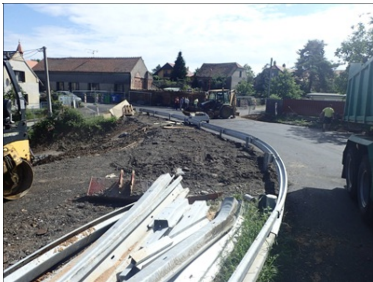
Ocelové svodidlo na vnitřním okraji III/12550 - pohled z vnější strany
