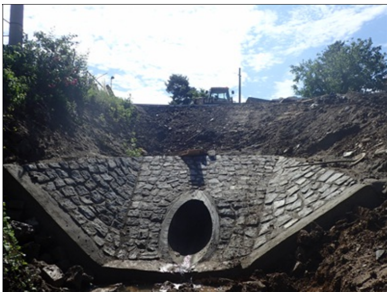
Celkový pohled z koryta vodoteče na opevněné výtokové čelo
