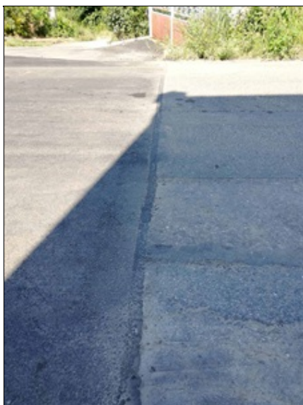
Příčná spára ve vozovce v napojení stávajícího a nového krytu - začátek úpravy
