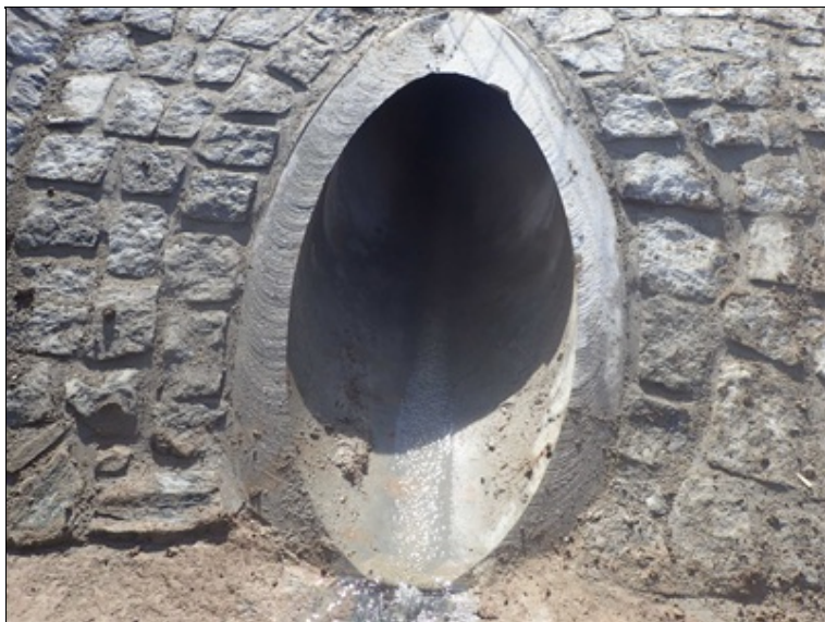
Detail šikmého ukončení koncové trouby DN 800 na výtoku z propustku
