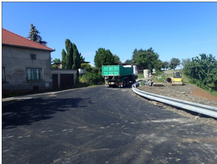
Pohled z mostního objektu na levé předpolí (směrem na Opatovice)
