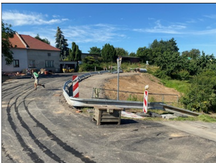
Krátký náběh nového ocelového svodidla před propuskem vpravo (odklon do sjezdu)
