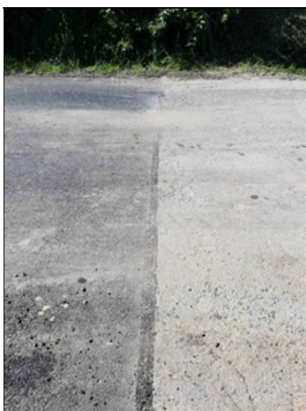
Příčná spára ve vozovce v napojení stávajícího a nového krytu - konec úpravy
