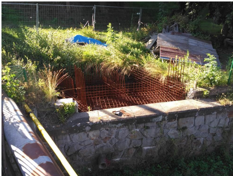
Obr. 1 - stávající stav OP1 – armatura
