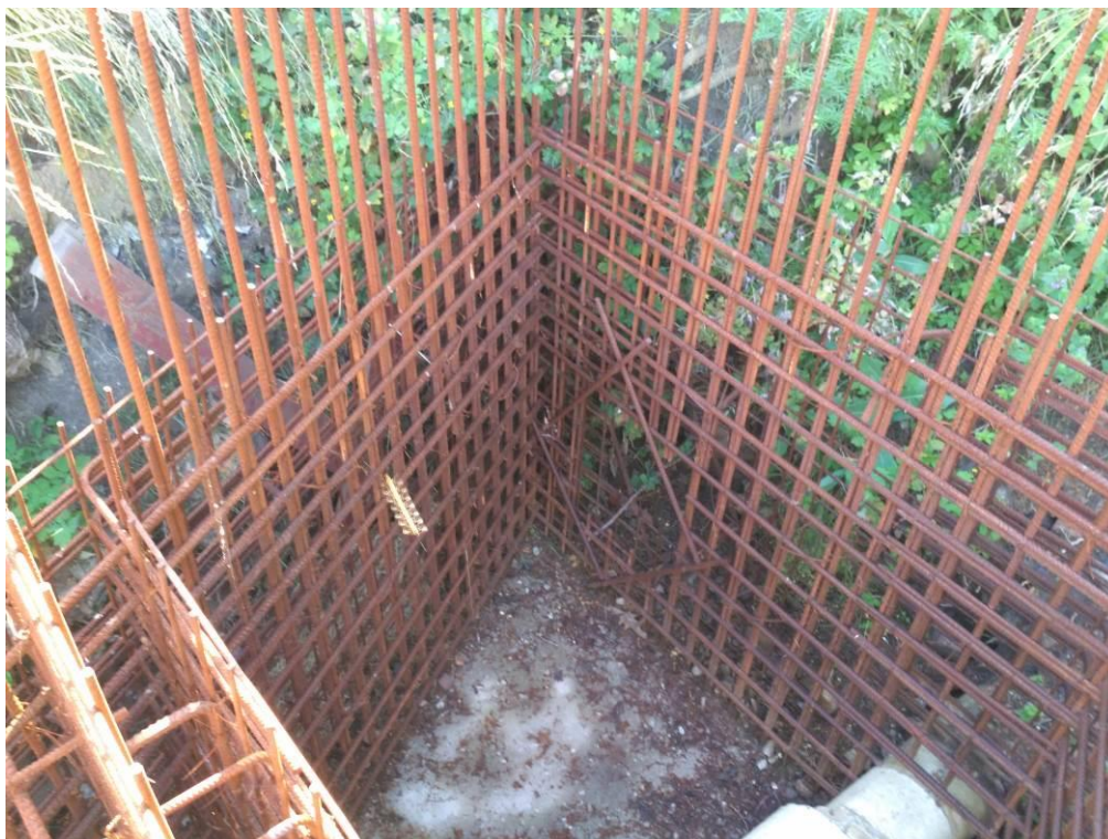
Obr. 3 - stávající stav OP1 – armatura – zadní prostup
