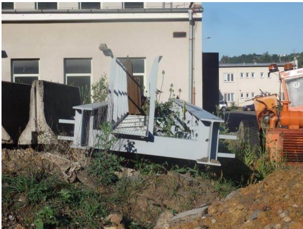
Obr. 7 - stávající stav nosné konstrukce lávky – uskladněna na dvoře KSUS
