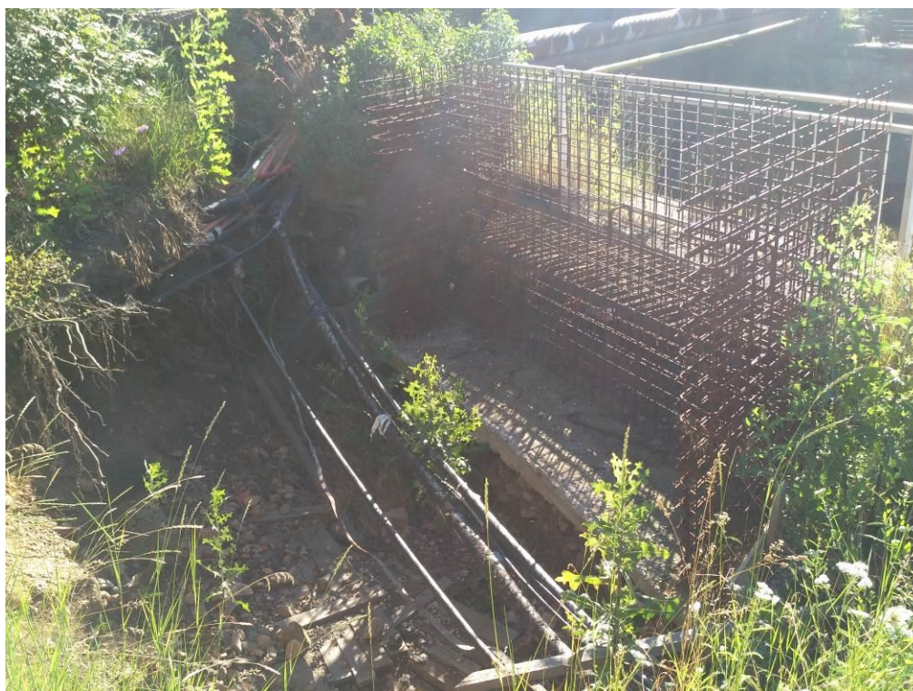
Obr. 6 - stávající stav OP2 – inženýrské sítě v místě výkopu
