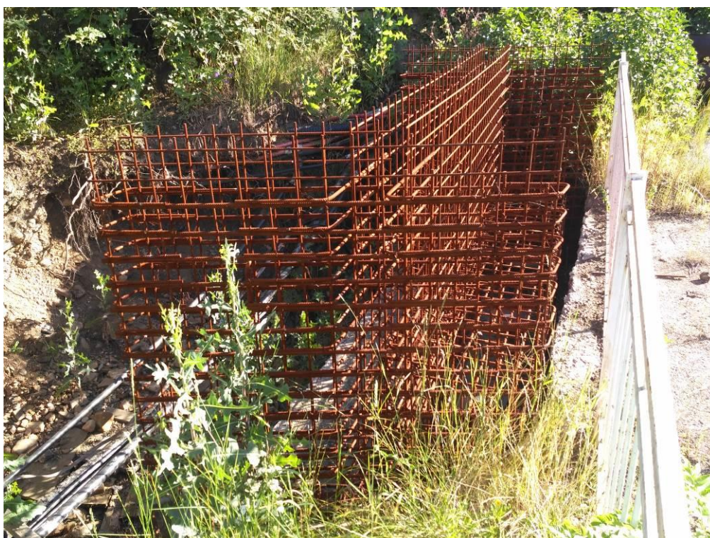
Obr. 4 - stávající stav OP2 - armatura
