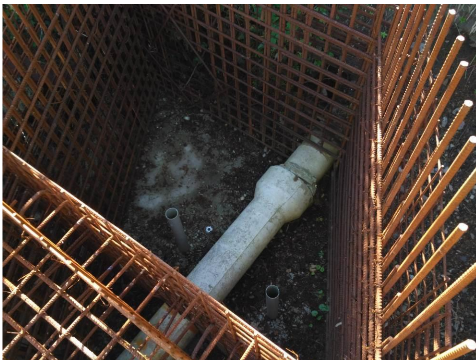
Obr. 2 - stávající stav OP1 – kameninová trubka jdoucí skrze opěru
