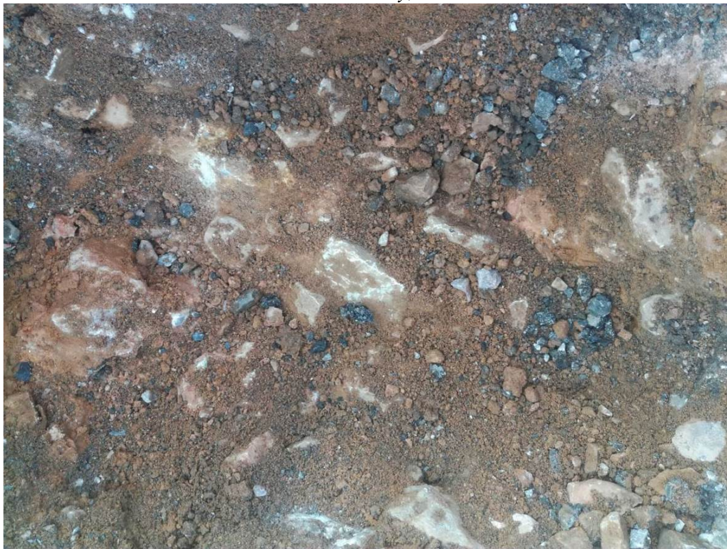
Obrázek B. 3 Štětová vrstva v konstrukci vozovky, sonda K1
