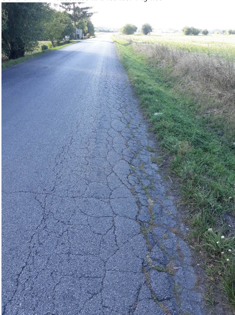
Obrázek A. 2 Nedostatečná únosnost krajnice
