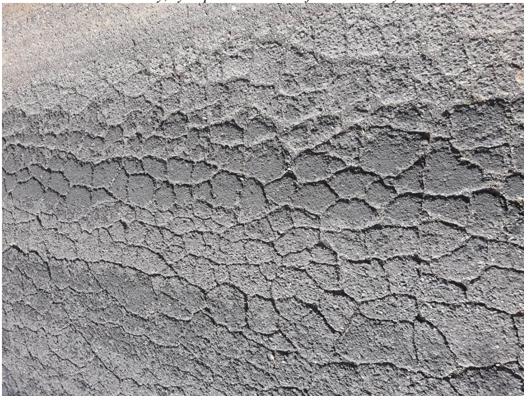
Obrázek A. 4 Síťové trhliny, vyčerpaná životnost asfaltem stmelených vrstev
