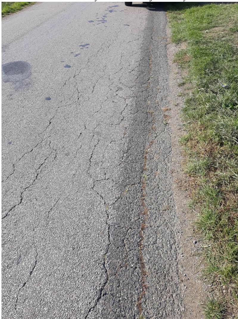
Obrázek A. 1 Síťové trhliny v oblasti okraje vozovky
