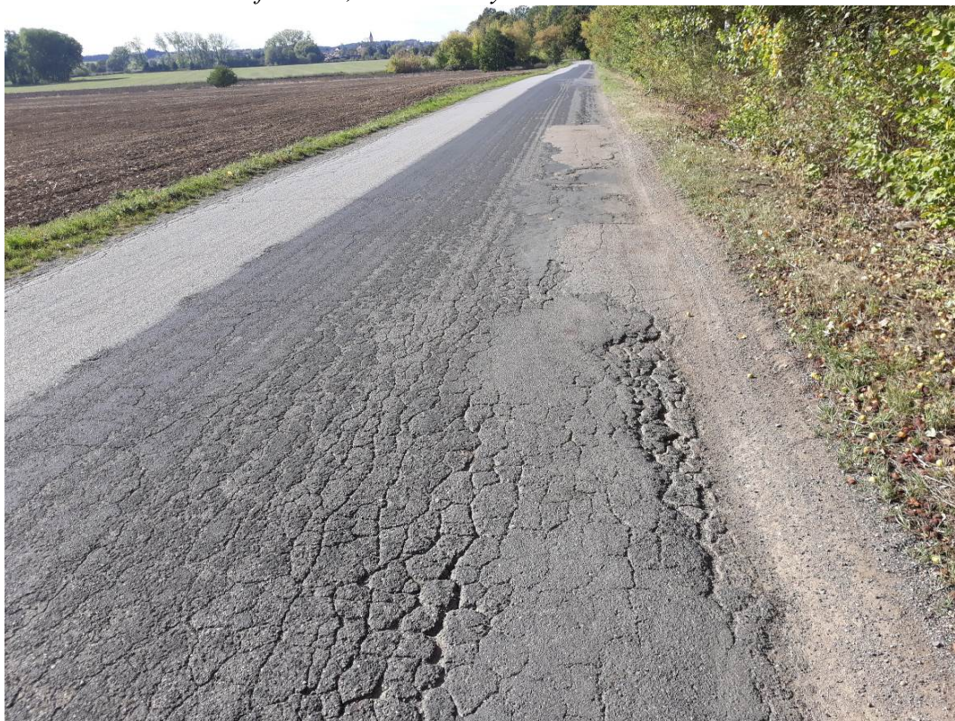
Obrázek A. 5 Příčné deformace, síťové trhliny
