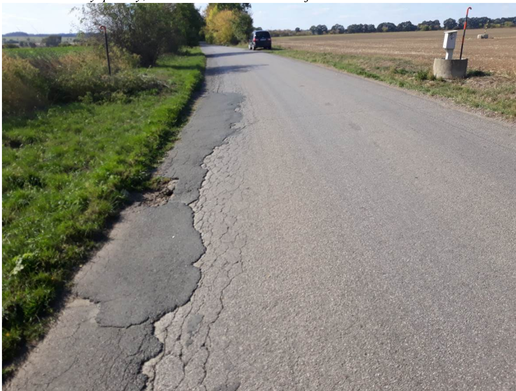
Obrázek A. 3 Vysprávký, nedostatečná únosnost krajnice
