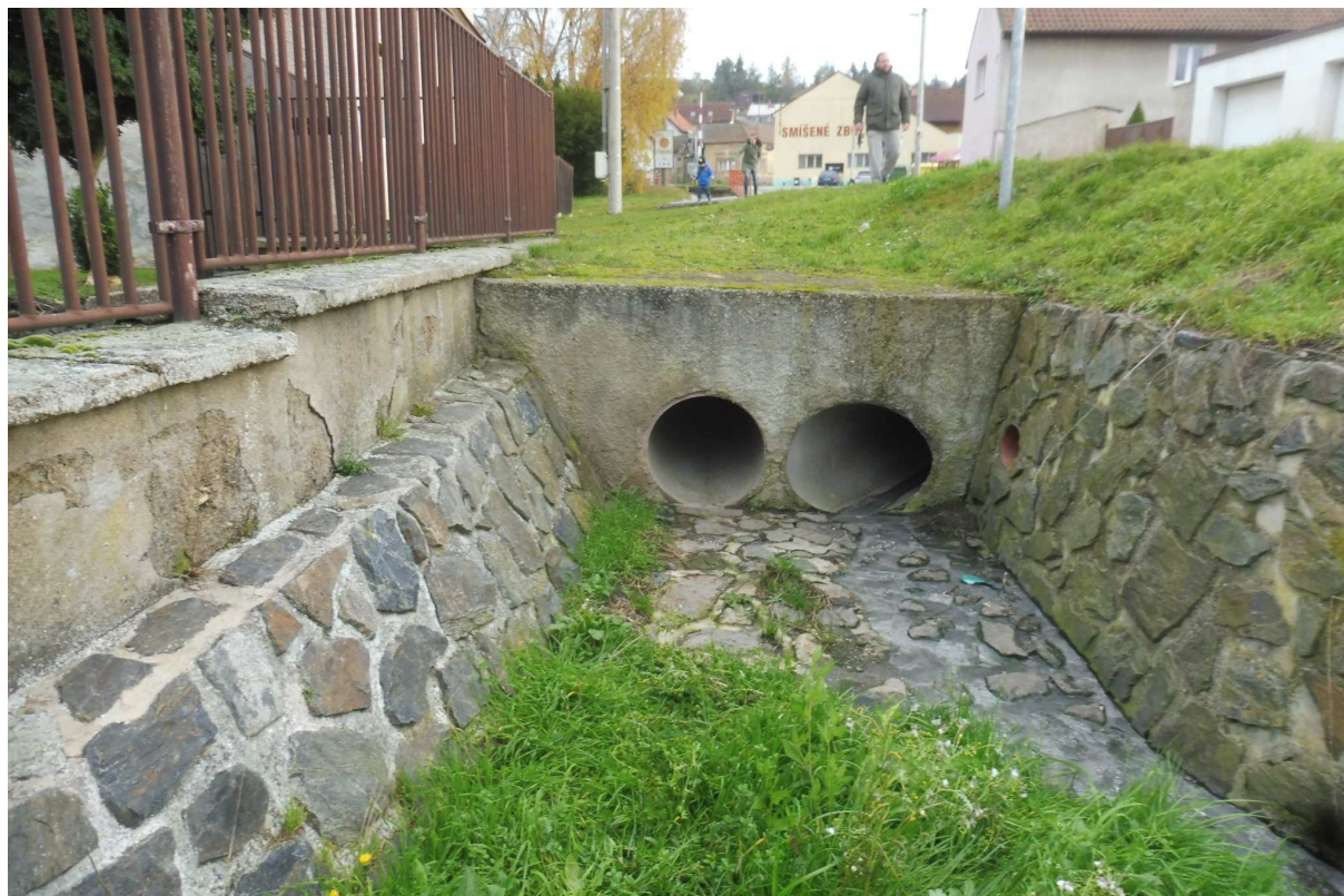
Vyústění odvodnění komunikace do inundačního pole
