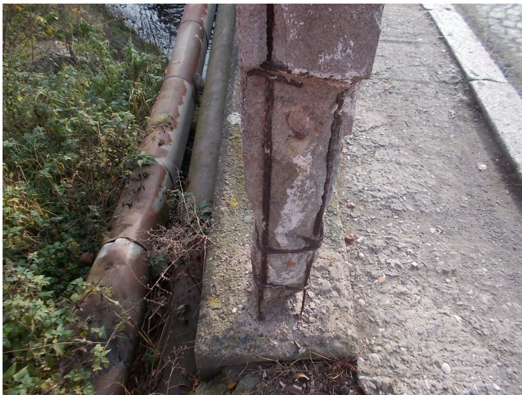
Záchytný systém a chráničky na mostě ev. č. 24010-3
