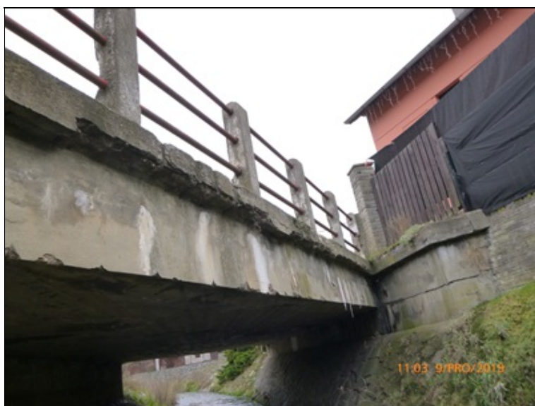
Stav říms, zatékání na bok NK
