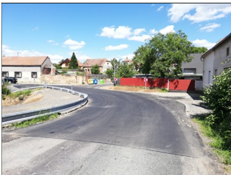
Pohled na mostní objekt z levého předpolí
