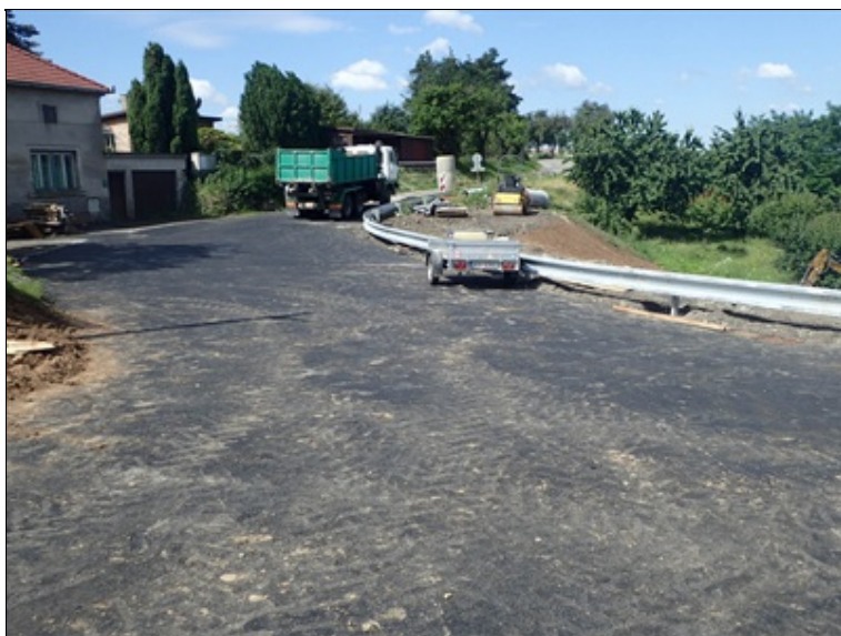
Povrch nové vozovky III/12500 v oblasti propustku
