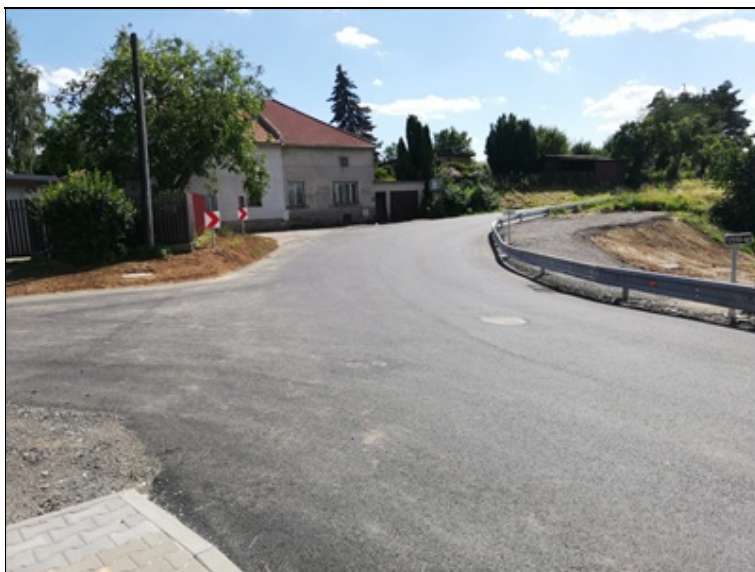
Pohled na mostní objekt z pravého předpolí
