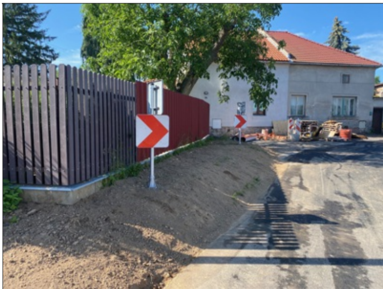
Příčná spára ve vozovce v napojení stávajícího a nového krytu - začátek úpravy
