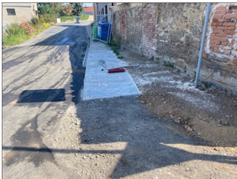
Dokončený chodník na levé straně III/12550 před křižovatkou se zámkovou dlažbou a poklopem ŠP2
