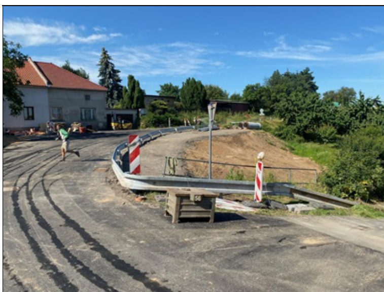
Krátký náběh nového ocelového svodidla před propuskem vpravo (odklon do sjezdu)
