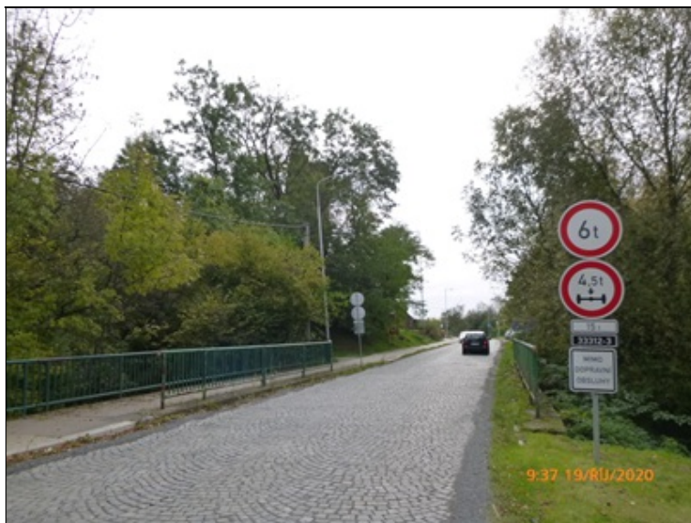
Pohled na most po směru staničení.
