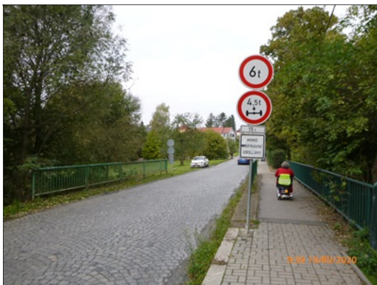
Pohled na most proti směru staničení.
