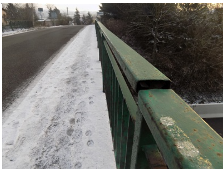
Rozpojené madlo ve dvou stycích za sebou. Zatím pevné
