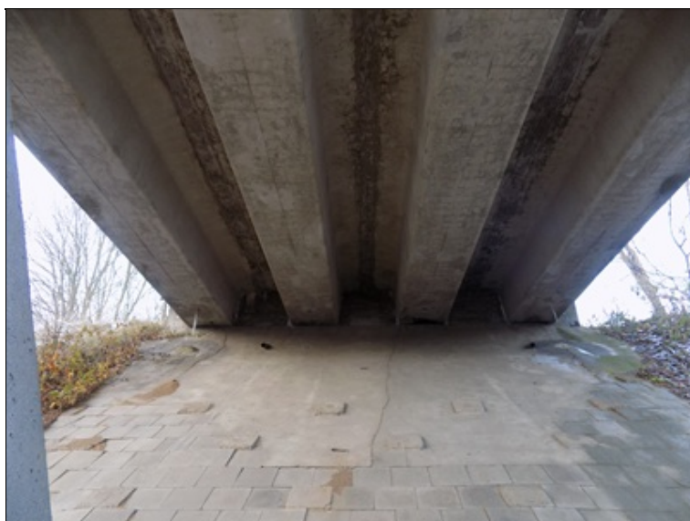
Opěra OP1, výluhy v koncovém příčniku
