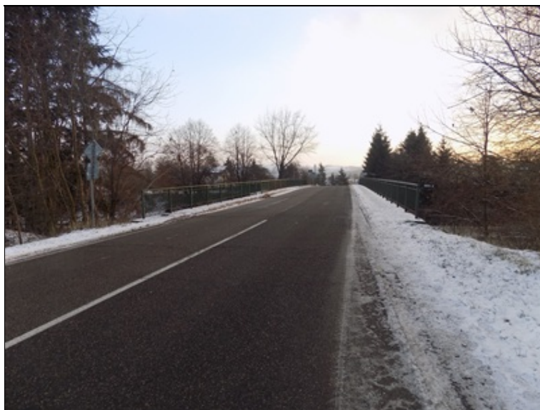
Uspořádání na mostě ve směru staničení
