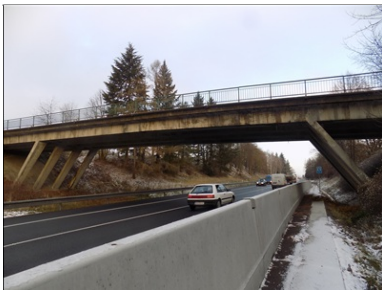
Pohled na most z pravé strany
