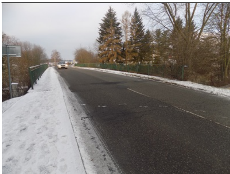
Pohled proti směru staničení
