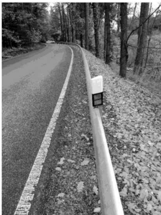
Dílčí změna 3 – doplnění chybějících směrových sloupků
