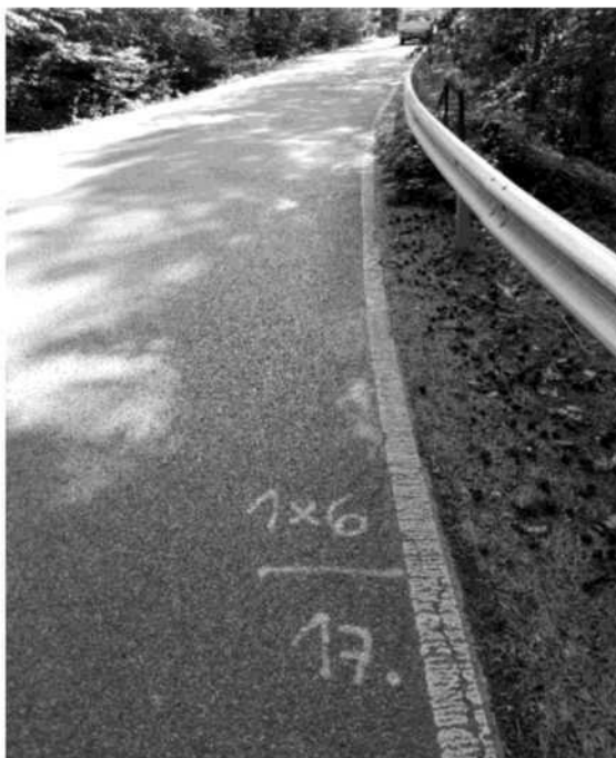
Dílčí změna 2 – provedení lokálních oprav včetně provedení nového vodorovného značení
