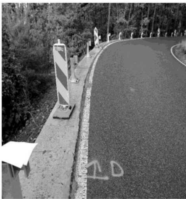
Dílčí změna 4 – změna detailu u ŽB zídky - provedení dilatace
