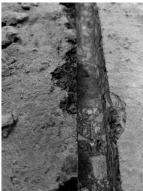
Dílčí změna 4 – změna detailu u ŽB zídky - provedení dilatace
