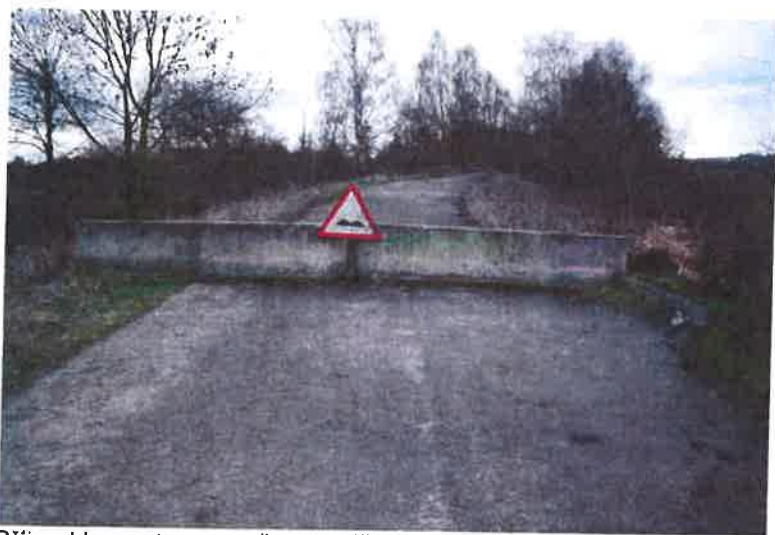
Příjezd k mostu ve směru staničení
