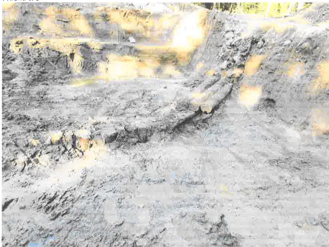
Obr.1 Nalezené původní dřevěné základy mostu
