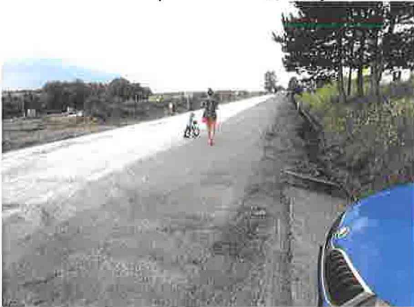
Ochrana penetračního nátěru před pokládkou ACP
