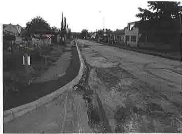
Dokončené obruby v Domašíně
