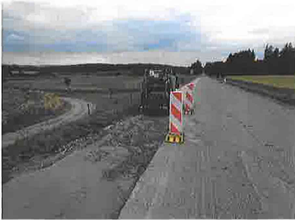
Dokončené SC na pravé straně vozovky
