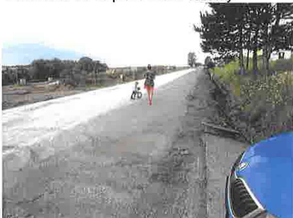
Ochrana penetračního nátěru před pokládkou ACP
