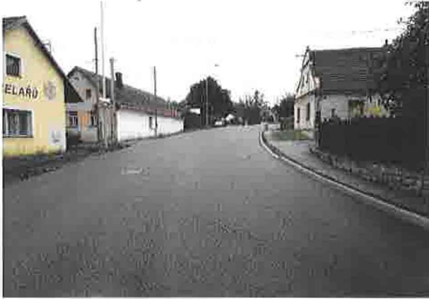
Dokončené SMA (finální vrstva) v obci Domašín
