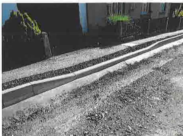
Dokončené obruby v Domašíně
