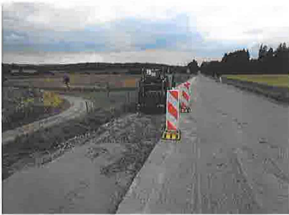
Dokončené SC na pravé straně vozovky
