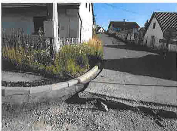
Dokončené obruby v Domašíně
