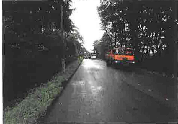
Pokládka ACO v obci Bruk
