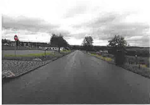
Dokončené ACO u obce Domašín - směr Domašín
