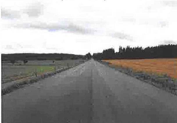
Položené ACO směr Bruk
