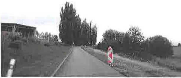
Sanace krajnice v úseku KM 11,350 - 12,150
