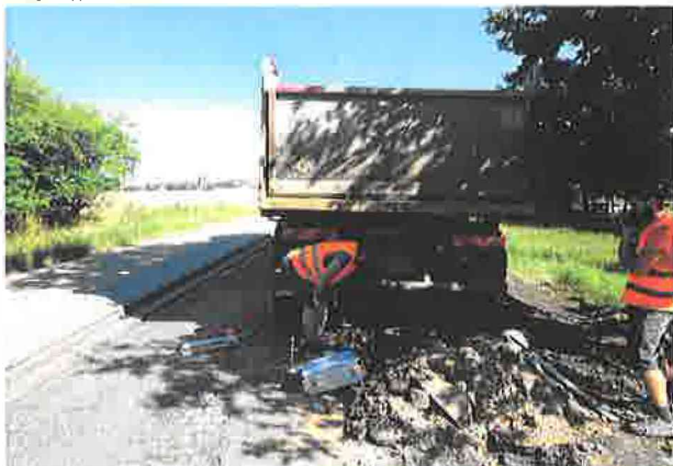
Statické zkoušky na krajnici
