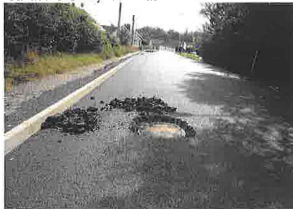
Příprava pro osazení IS do projektované výšky
