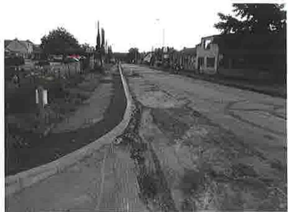
Dokončené obruby v Domašíně
