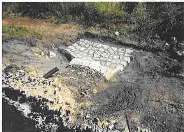
Provádění opevnění svahu propustku
