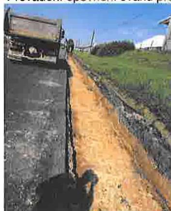
Sanace levé krajnice - Vlašim
