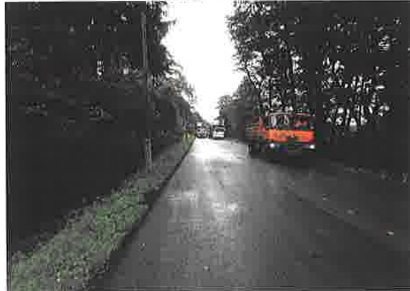
Pokládka ACO v obci Bruk
