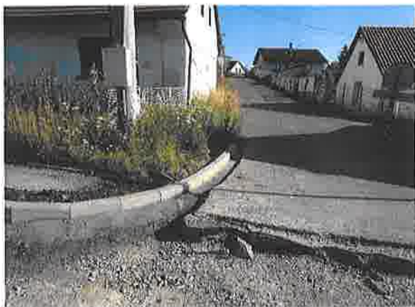
Dokončené obruby v Domašíně
