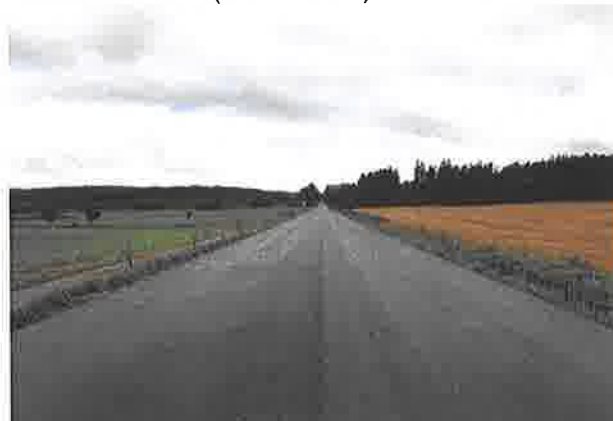
Položené ACO směr Bruk
