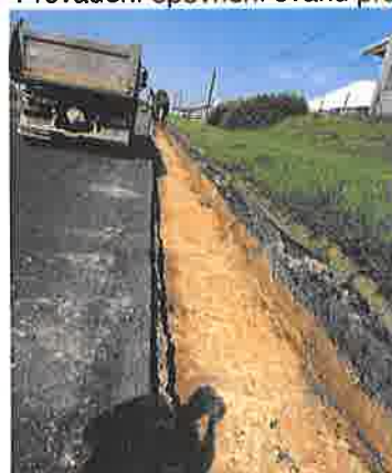
Sanace levé krajnice - Vlašim
