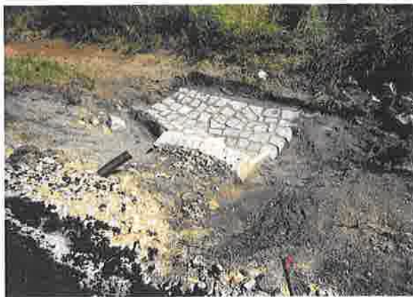
Provádění opevnění svahu propustku
