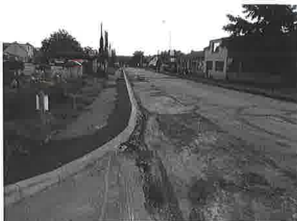
Dokončené obruby v Domašíně
