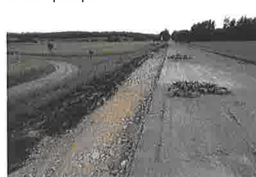
Prováděná sanace krajnice v ~KM 16,100
