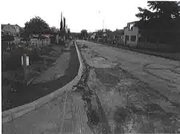
Dokončené obruby v Domašíně
