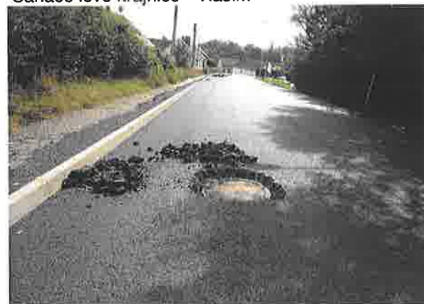
Příprava pro osazení IS do projektované výšky
