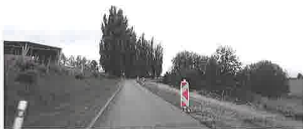
Sanace krajnice v úseku KM 11,350 - 12,150
