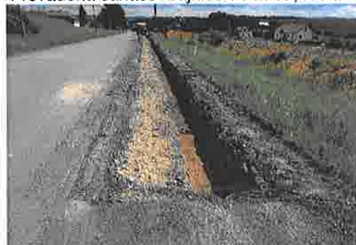
Prováděná sanace krajnice v KM 17,400 až 16,200
