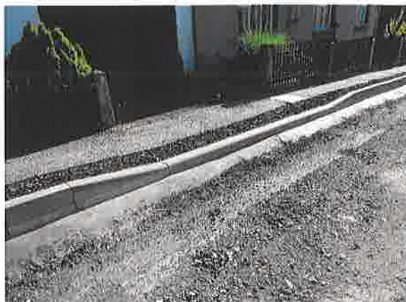
Dokončené obruby v Domašíně
