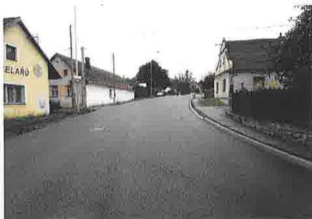
Dokončené SMA (finální vrstva) v obci Domašín
