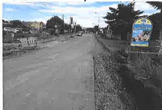
Prováděná sanace krajnice v KM 17,400 až 16,200
