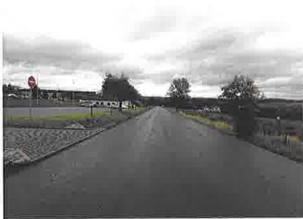
Dokončené ACO u obce Domašín - směr Domašín
