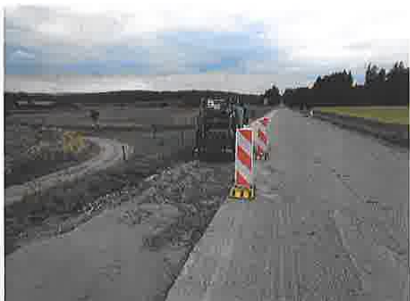
Dokončené SC na pravé straně vozovky
