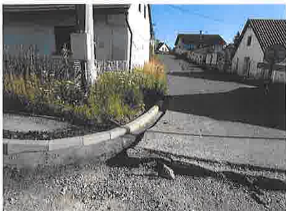
Dokončené obruby v Domašíně
