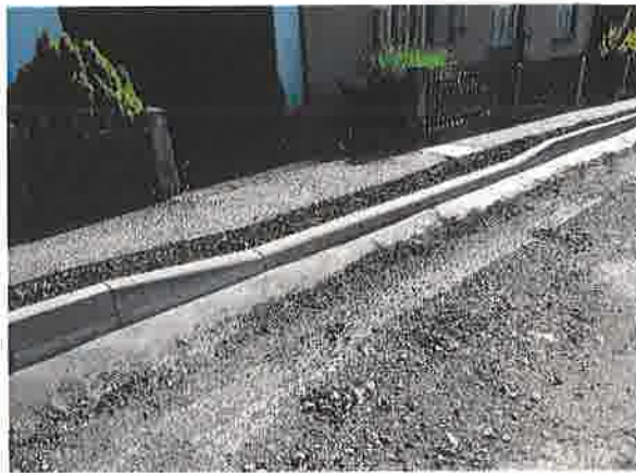
Dokončené obruby v Domašíně
