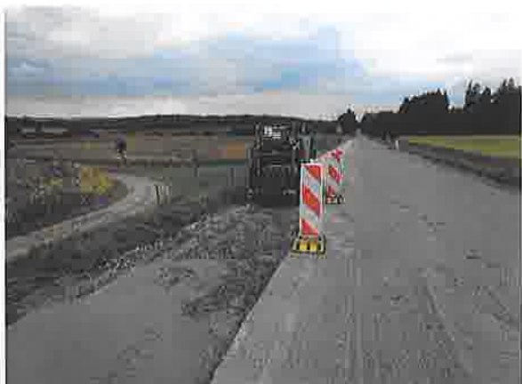
Dokončené SC na pravé straně vozovky
