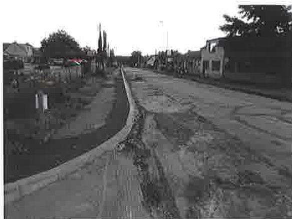
Dokončené obruby v Domašíně
