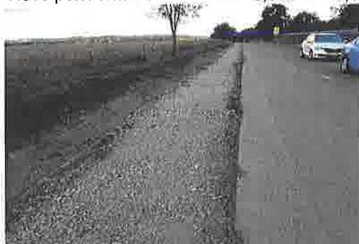
Prováděná sanace krajnice v KM 17,400 až 16,200
