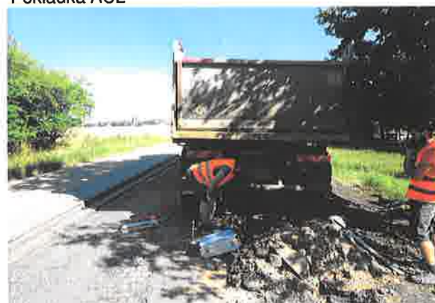
Statické zkoušky na krajnici
