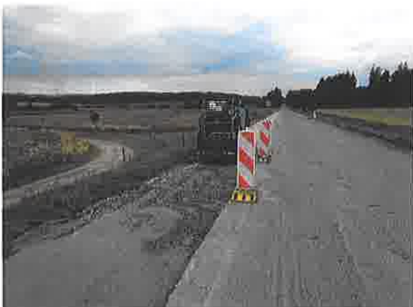
Dokončené SC na pravé straně vozovky
