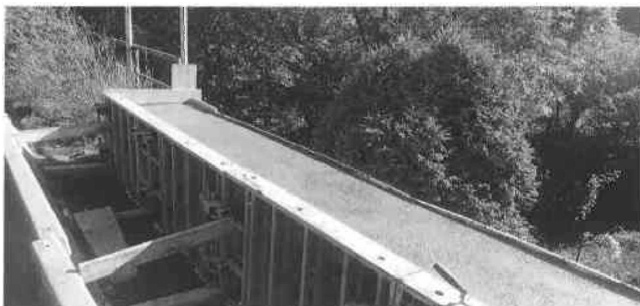
Zabedněná a vybetonovaná obetonávka:
