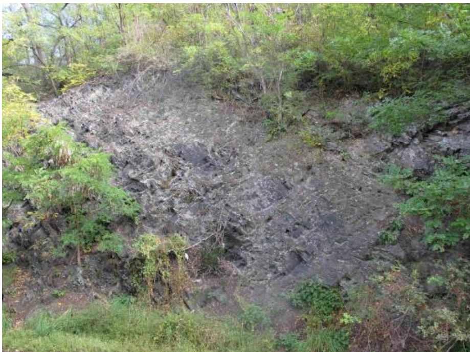
Obrázek 1 - Skalní výchoz v km 0,140 - 0,175
