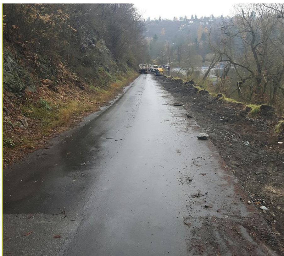
Obrázek 5 - Pohled na skalní stěnu
