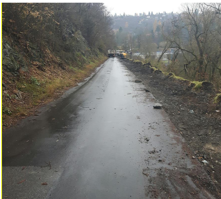
Obrázek 5 - Pohled na skalní stěnu
