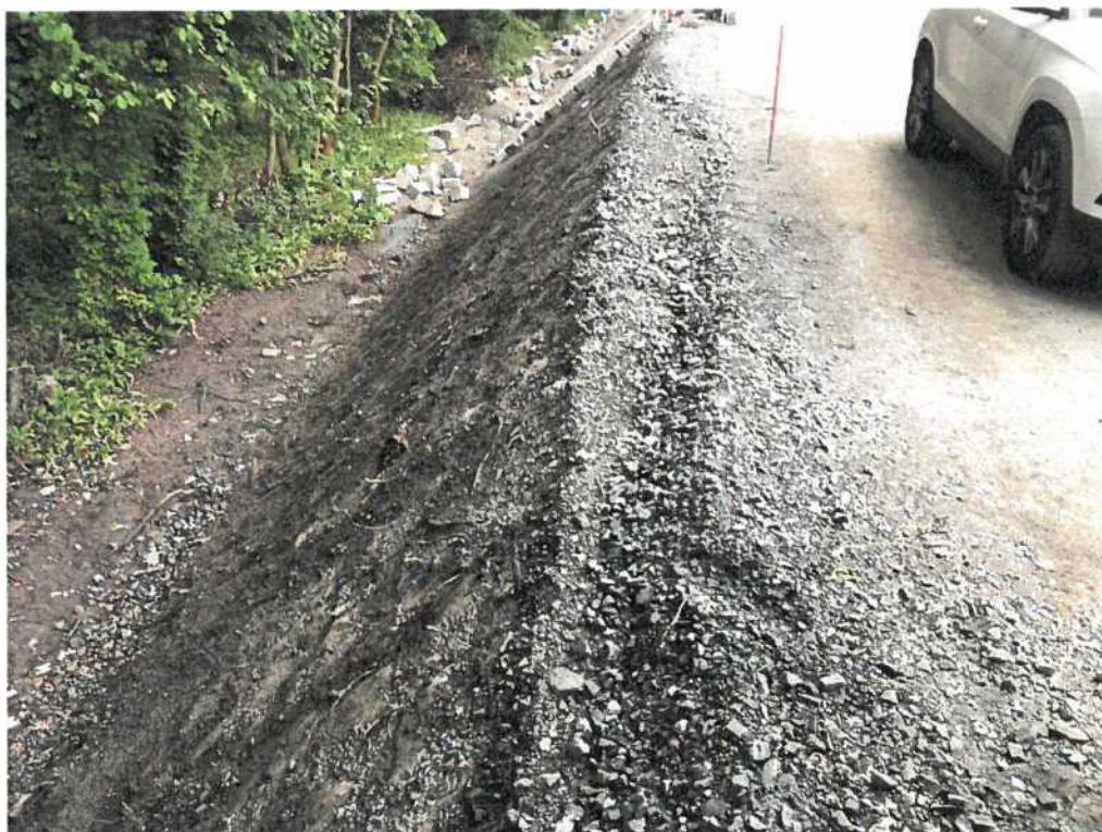
Původní kamenná dlažba v km 3,100 - 3,650
