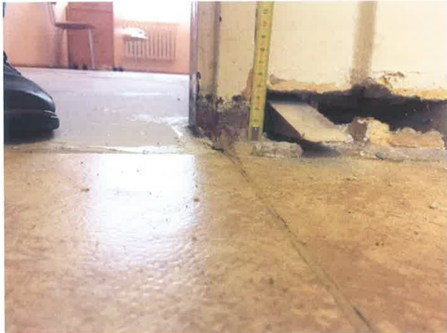
53. Pokles podlahy o 50mm – zajištění příčky pomocí klínů
