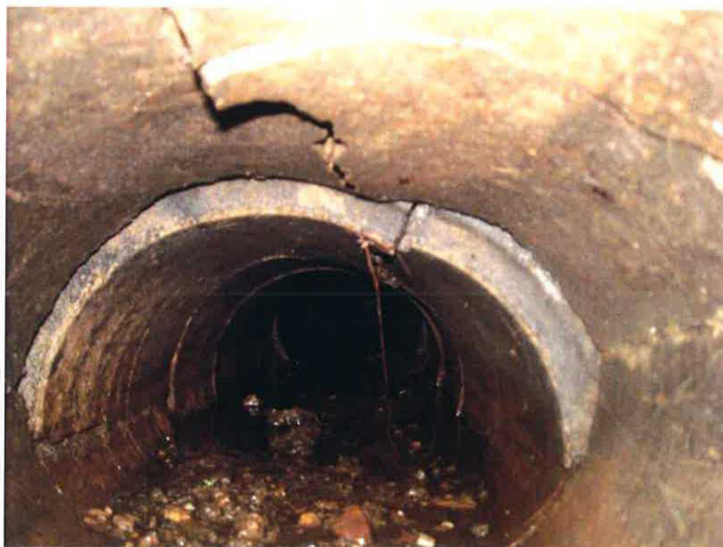
foto 2, SO 101-1 Propustek v km 4,264
