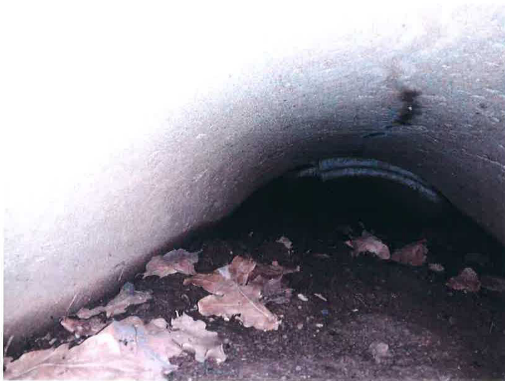
foto 1, SO 101-1 propustek v km 4,828
