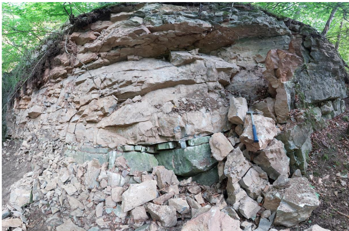
Foto 4 Odlučná hrana, odkud došlo k uvolnění horninových hmot. Zřetelně je vidět, že vrstvy vápenců jsou sub-horizontálně ukloněny pod úhlem cca 10^\circ a při povrchu nepravidelně rozpukané příčnými extenzními trhlinami. V důsledku takového strukturně-tektonického plánu horninového masivu dochází v důsledku působení eroze a zvětrávání ke vzniku poměrně výrazných skalních převisů.
