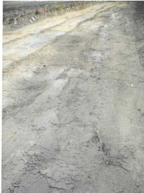
Obr.2 – Organické zbytky v podloží krajnice
