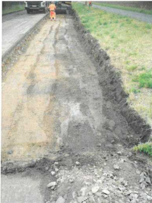
Obr.1 – Rozhraní zemin v aktivní zóně a v krajnici
