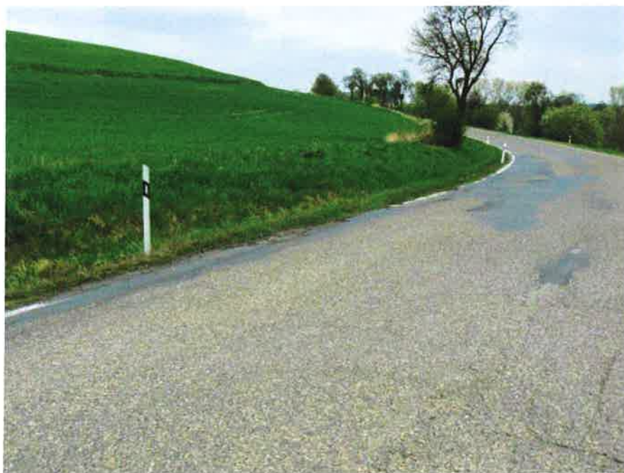
II/105 staničení cca 30,000 km
