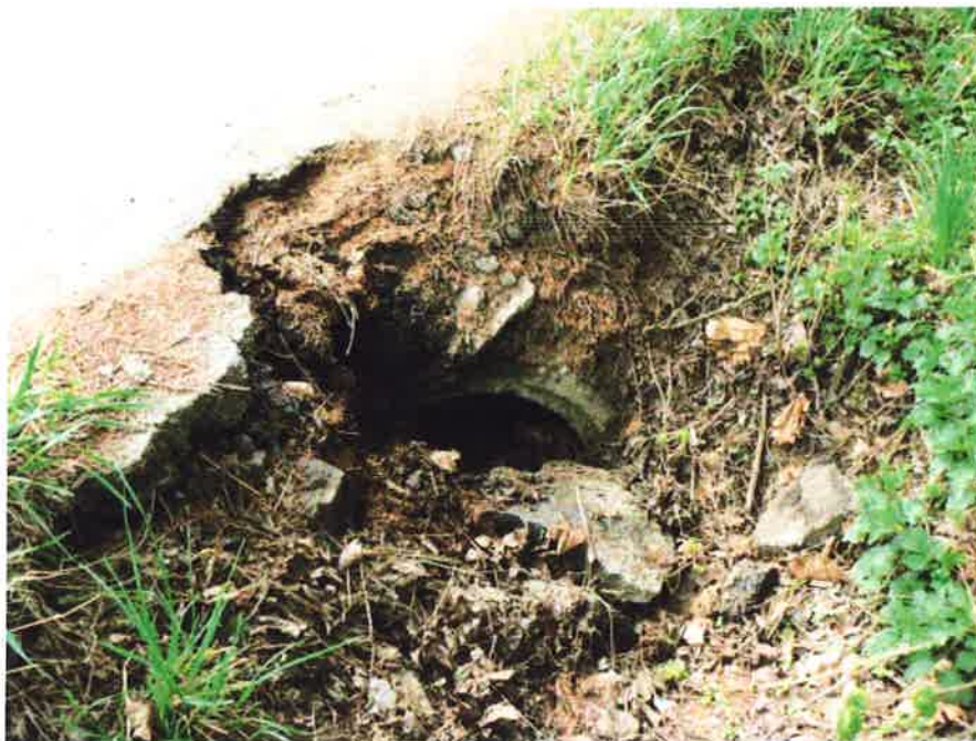
II/105 propustek staničení cca 30,700 km
