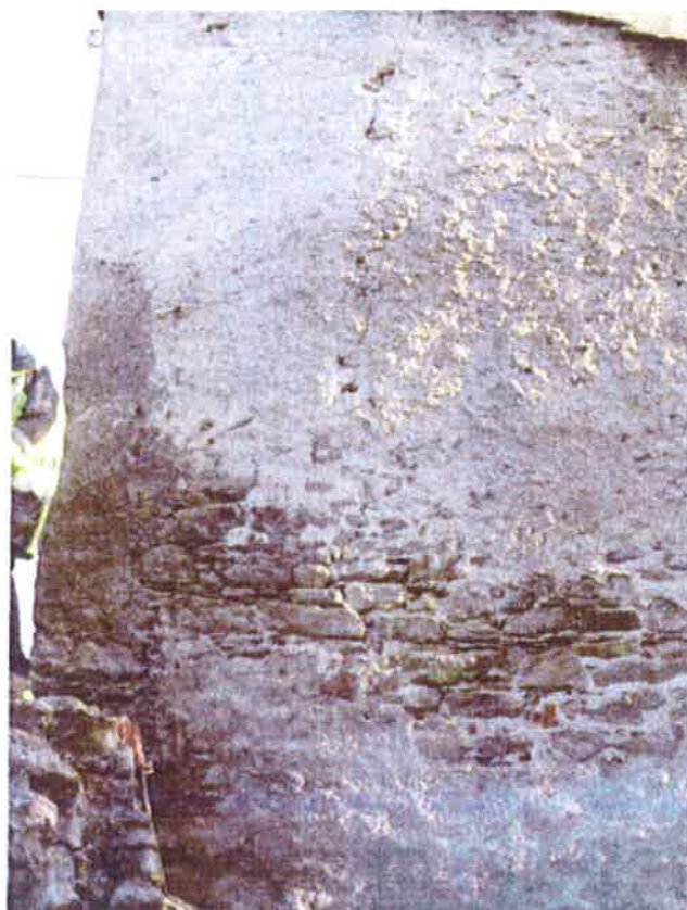
Táborská 50/1 – původní svislé trhliny na jižní stěně objektu (opatřeny sádrovými páskami)
