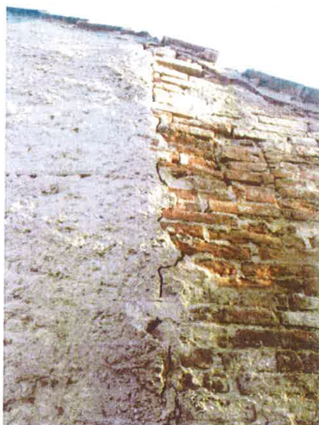
Táborská 50/1 – původní svislé trhliny na jižní stěně objektu (opatřeny sádrovými páskami)
