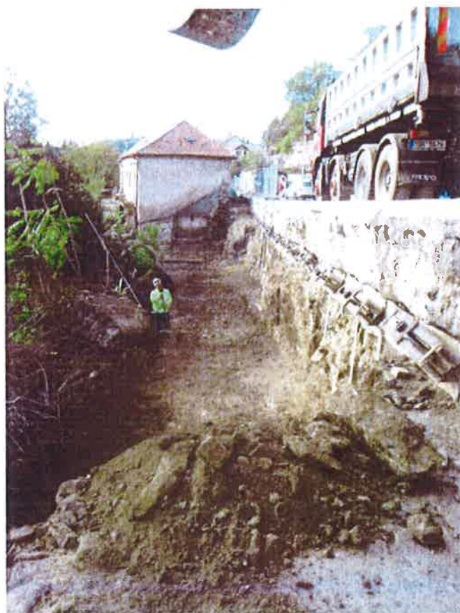
SO 251.4 - 4.úsek zdi - spára pro 2.kotevní úroveň
