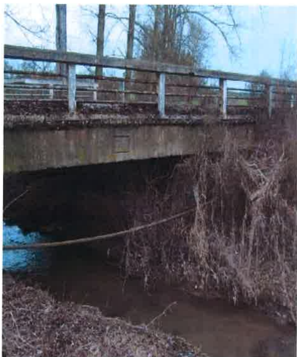
most ev. č. 228-011
