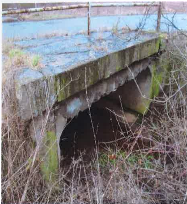
most ev. č. 228-007
