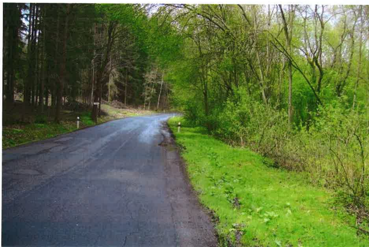
Povrch silnice a propustky
