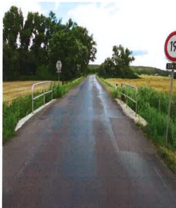
most ev. č. 228-010
