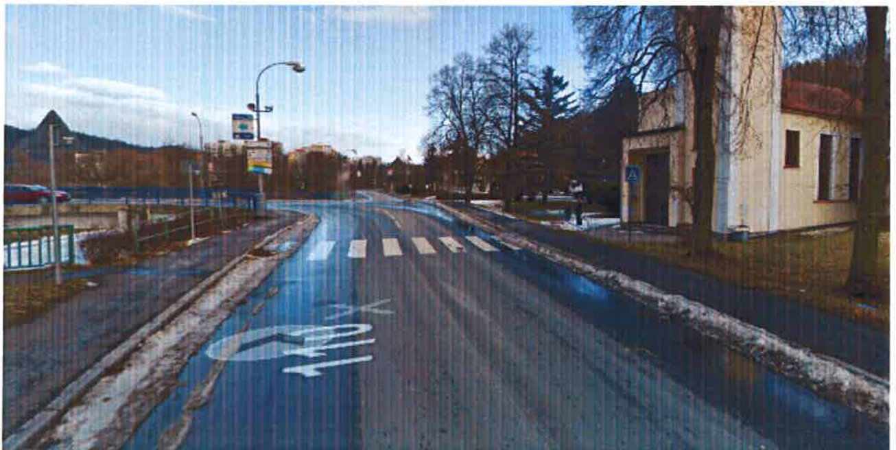
Etapa 3 – II/110 před mostem ev.č. 110-008
