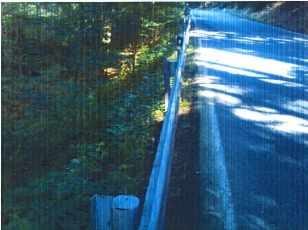
Etapa 2 za Dojetřicemi – chybějící krajnice, nestabilní svah
